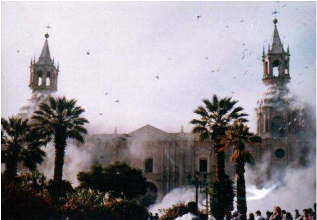
Figura 14: Vista del preciso momento del derrumbe de la Basílica Catedral de Arequipa en el terremoto del 23 de Junio del 2001
