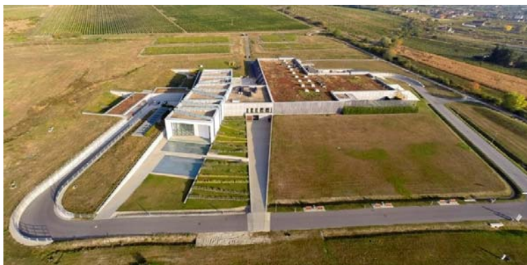
Imagen 47: Vista de Conjunto
