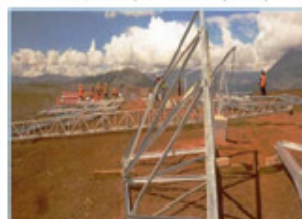
Montaje de la Torre T 220
