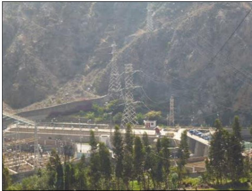
Fotografía 2.2. Línea de Transmisión Barbablanca - Lima. (Stad.com, 2015)
