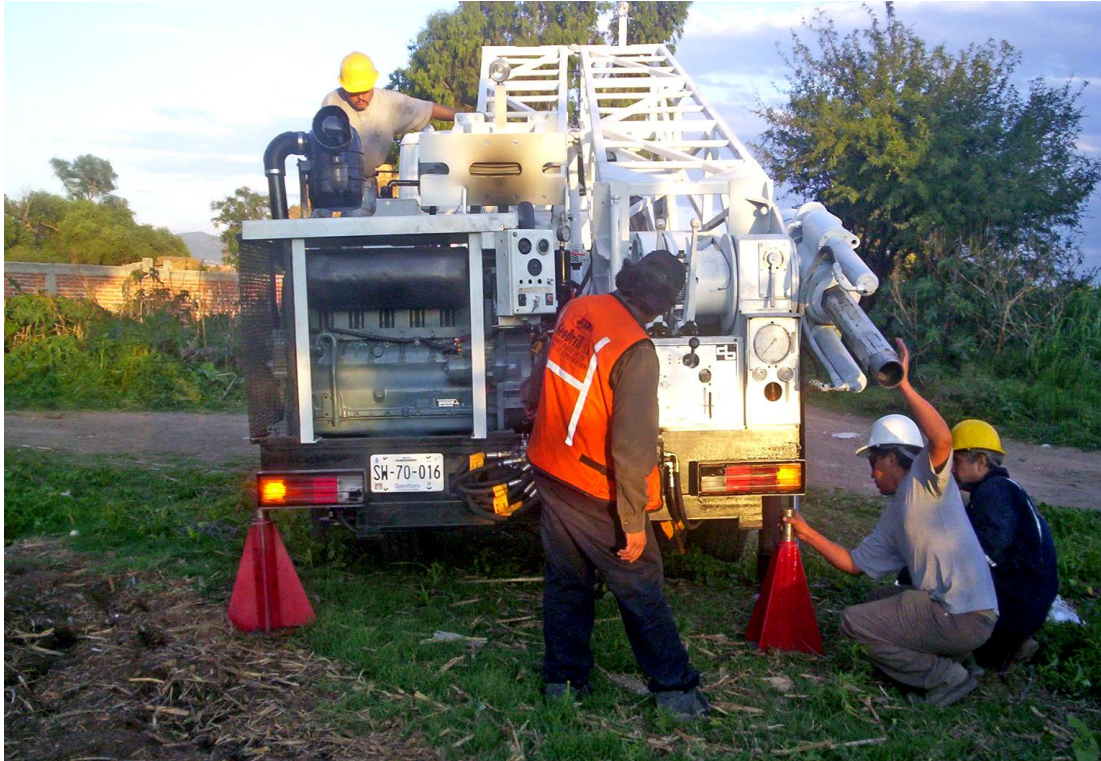
Figura 5. Nivelación de la maquina perforadora. Fuente: adaptación propia en base a la investigación realizada, 2022.
