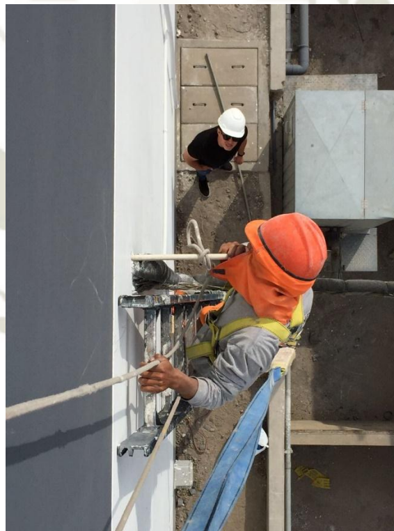
Figura N° 62: Instalación de la conexión del sensor de temperatura en el área de máquinas.
