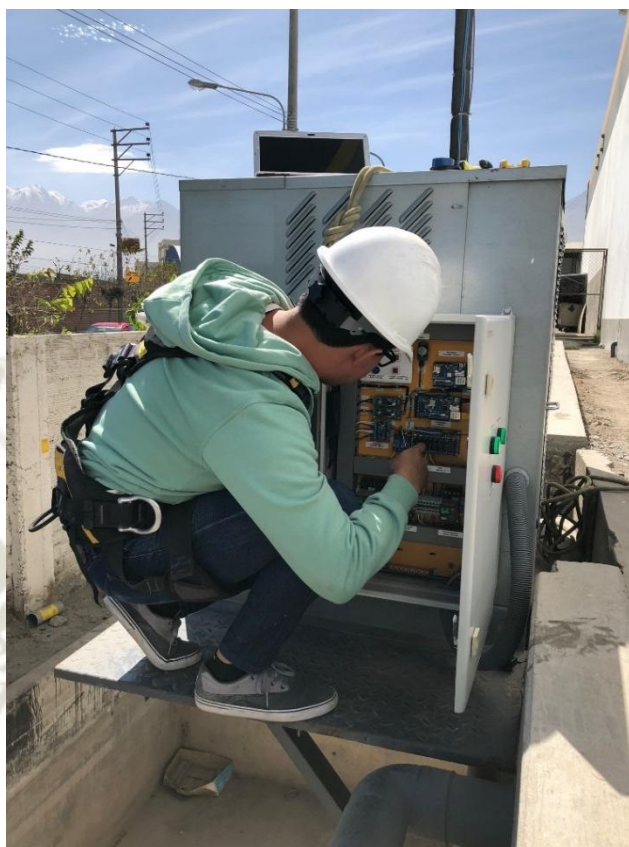
Figura N° 48: Instalación del tablero eléctrico.
