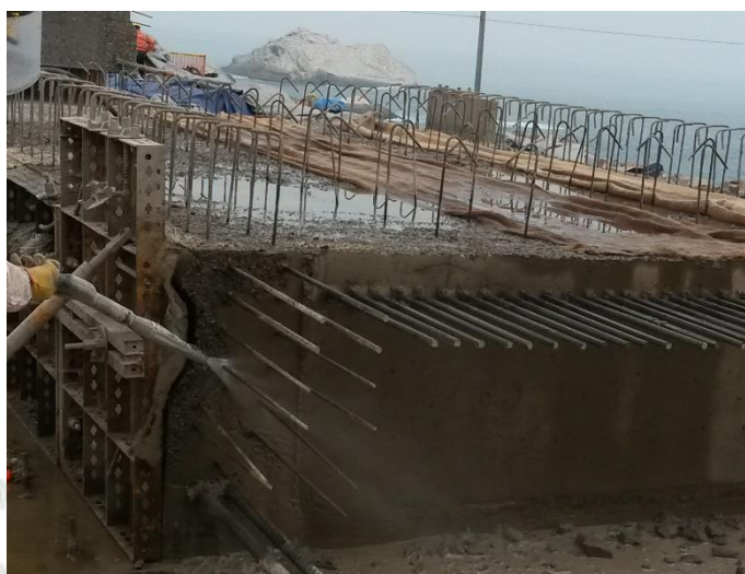
Figura 3.15: Lavado de superficie de concreto
