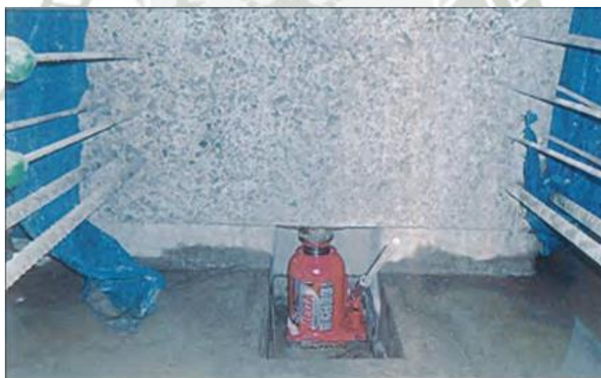
Figura 3.19: Gata usada en prefabricado tipo PI
