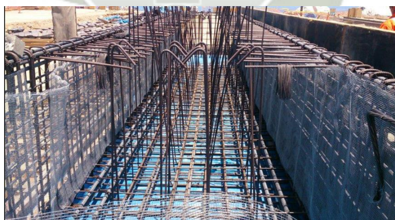
Figura 3.13: Encofrado interior con malla gallinero
