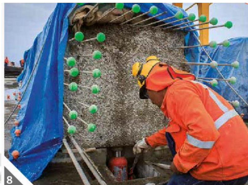
Figura 3.18: Cajuela parte inferior molde encofrado
