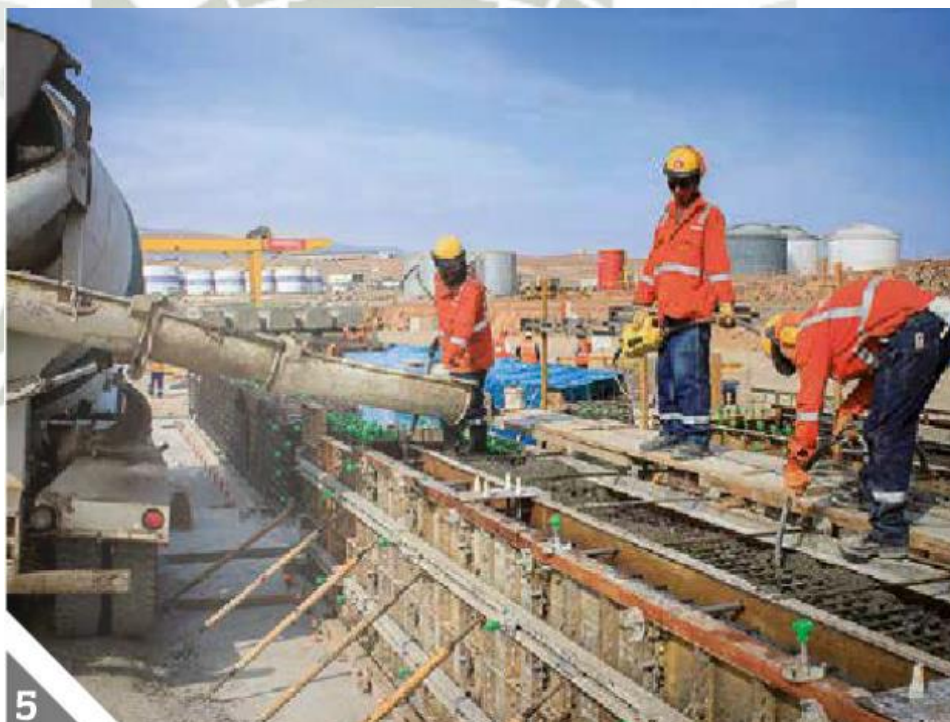
Figura 3.14: Colocación de concreto
