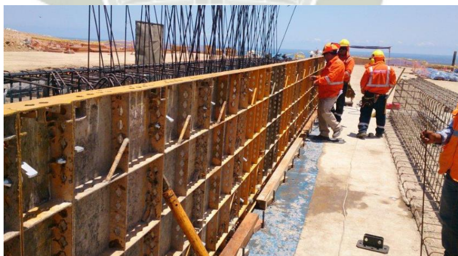
Figura 3.11: Encofrado prefabricado
