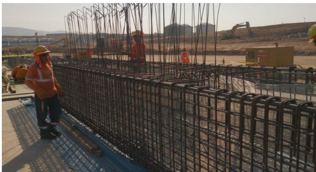
Figura 3.8: Armado de mallas de acero Elaboración propia
