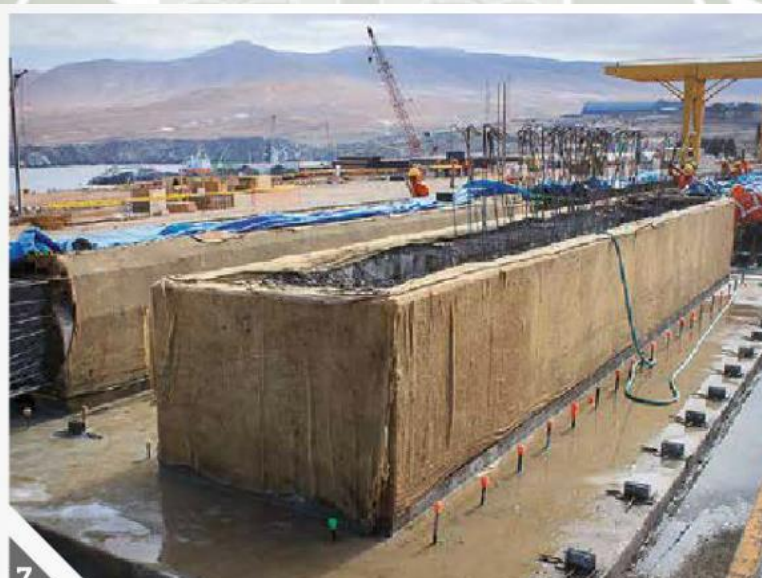
Figura 3.16: Curado de prefabricado
