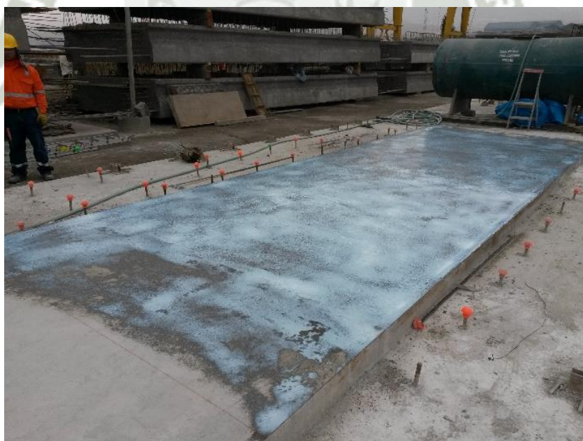
Figura 3.9: Aplicación de desmoldante
