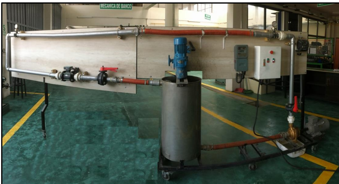
Figura 33. Módulo de Bombeo de Slurry.
