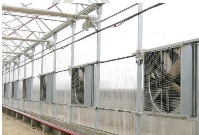
Figura 11 Ventilación Forzada en Invernaderos.
