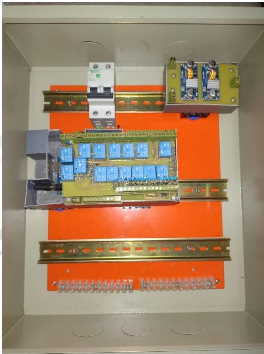
Figura 66 Montaje del Controlador y el Modulo Regulador de Tension en un Tablero Electrico.
