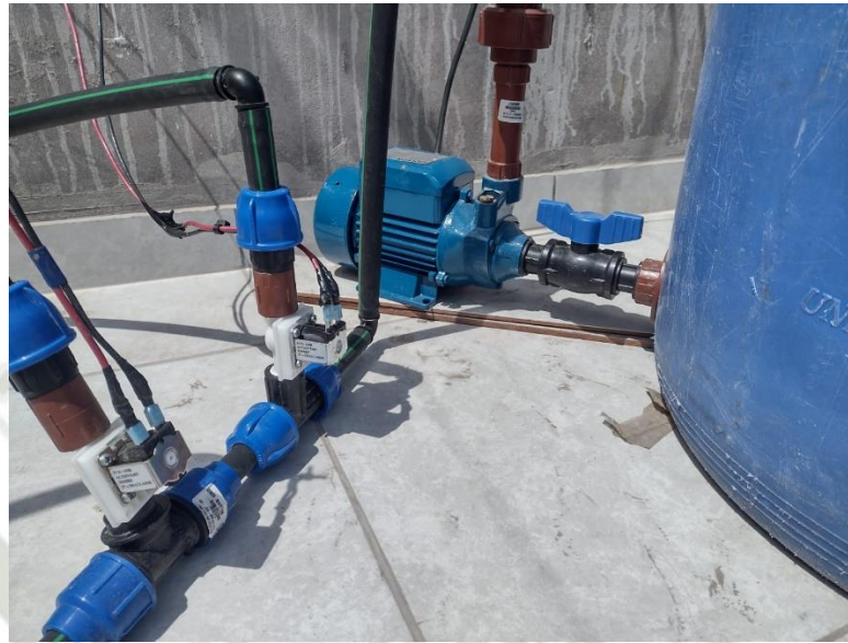
Figura 78 Pruebas de Funcionamiento del Circuito de Fuerza.
