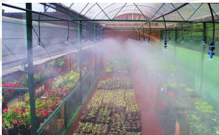
Figura 12 Refrigeración por Nebulización de Agua.
