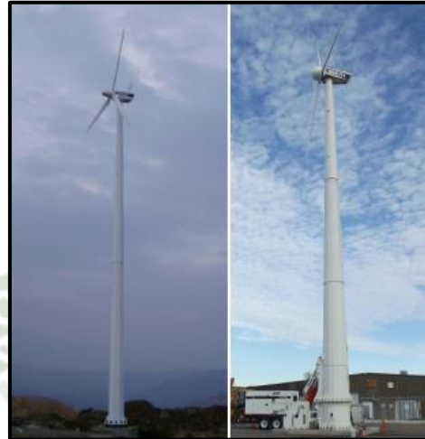
Figura 22. Turbinas eólicas con torre de acero tubular autoportante. Fuente: Aeolos wind turbine (2020)
