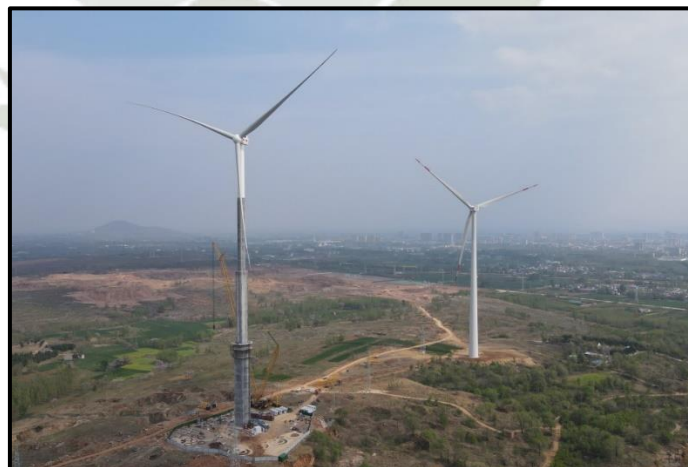
Figura 21. Turbina eólica de 170m con torre de concreto. Fuente: Esteyco (2019)
