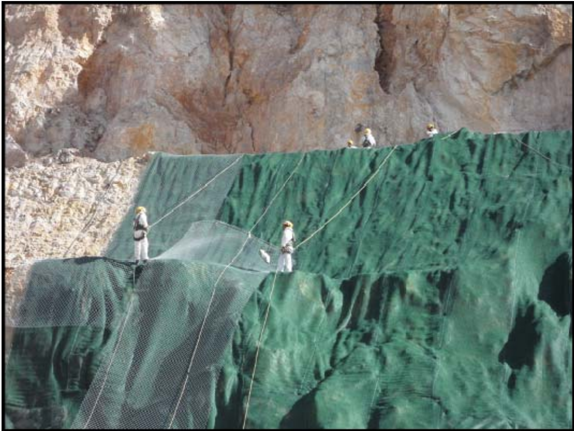
Foto 14: Tendido de geomantos y mallas
