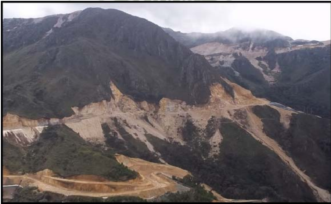
Foto 4: Foto de progresiva 3+950 en construcción hacia Pampa Verde
