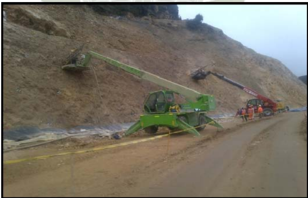
Foto 11: Perforación de talud con Manipulador Telescópico
