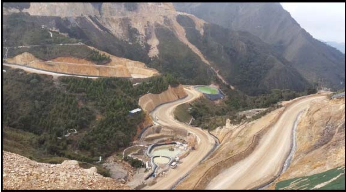
Foto 9: Vista de Carretera en Progresiva 2+750
