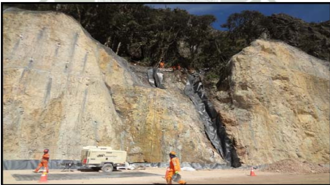
Foto 17: Recubrimiento con geomembrana en Canal de Coronación, progresiva 3+950
