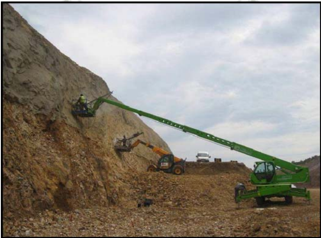
Foto 10: Pernos de anclaje
