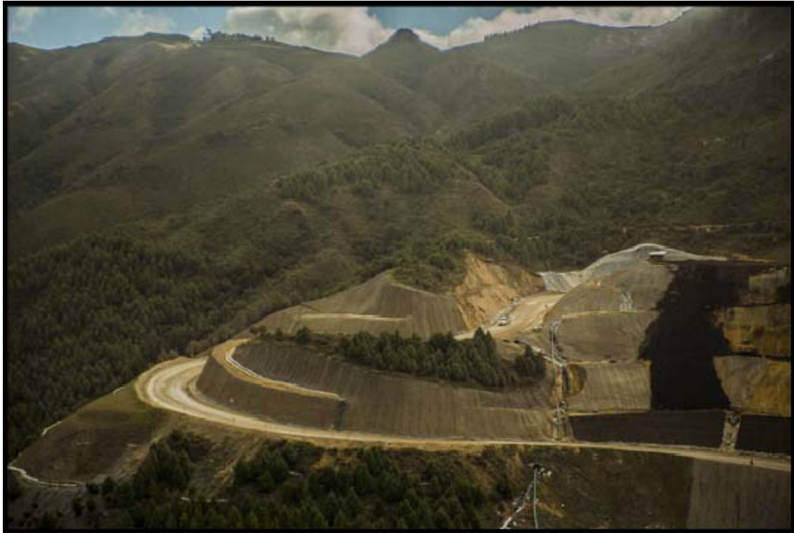
Foto 5: Foto de progresiva 3+300 finalizada
