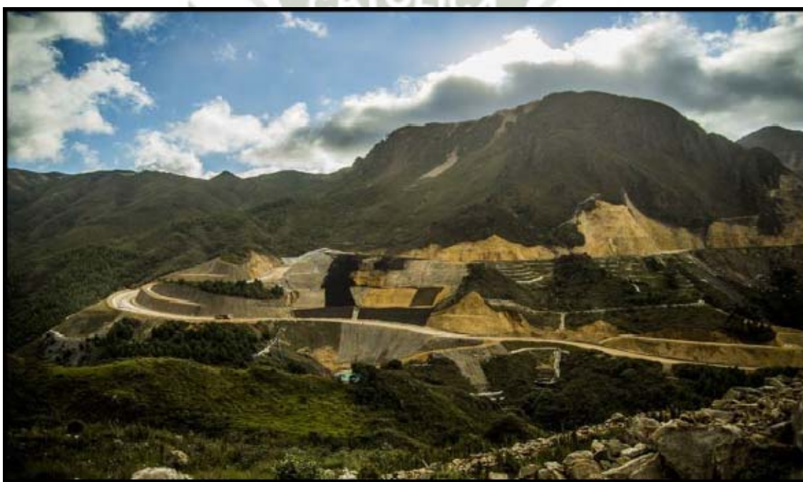
Foto 1: Carretera Pampa Verde Prog 3+250
