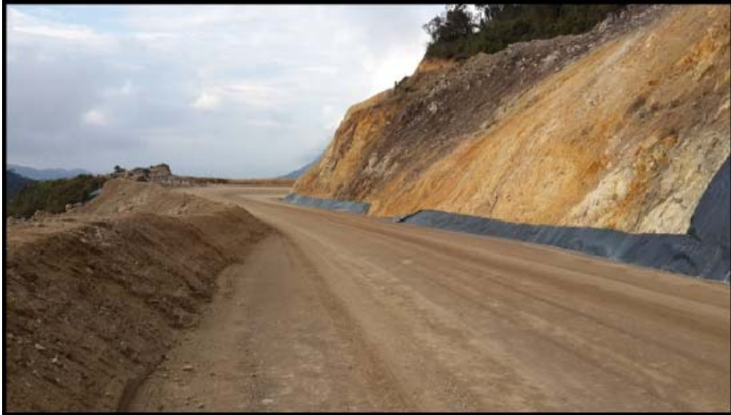
Foto 6: Progresiva 1+750 muros tipo bermas de minería
