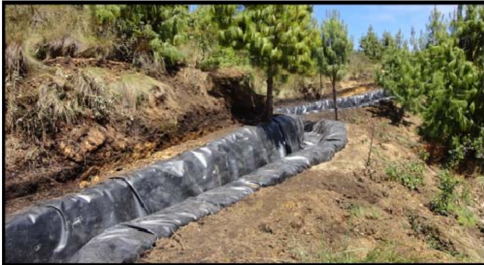
Foto 16: Cunetas de coronación
