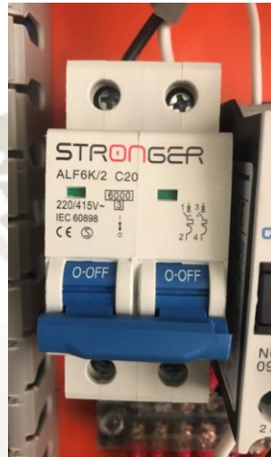
Fig. 40: Llave termomagnética de 220V/32A
