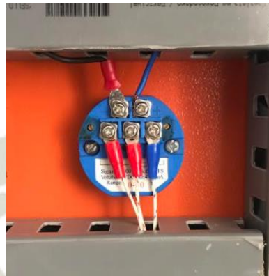
Fig. 46: Transmisor de sensor RTD PT100
