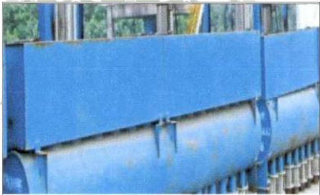
Figura N° 3. 8: Instalación de Manga de Filtros.
