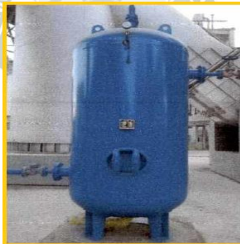
Figura N° 3. 11: Tanque de aire de 3 m3.
