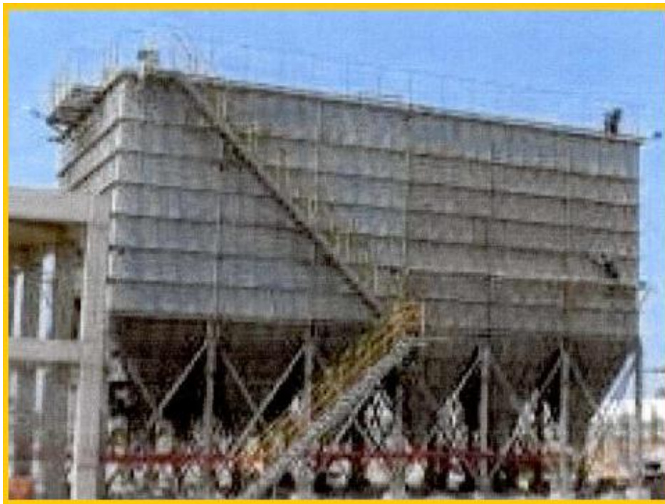
Figura N° 3. 12: Estructura del Sistema de Mitigación de Polvo.
