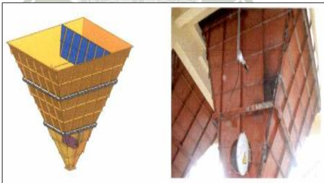
Figura N° 3. 7: Tolvas del Colector.
