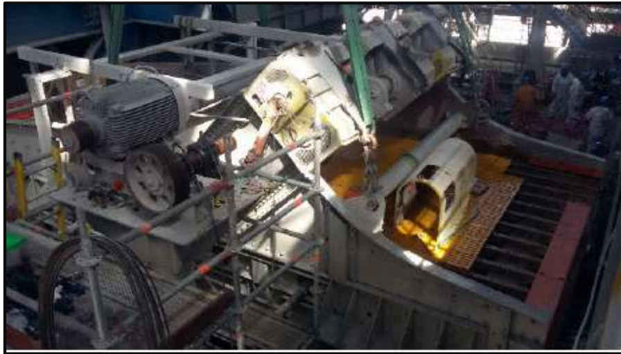
Figura 2. Mantenimiento de Zaranda Haver
