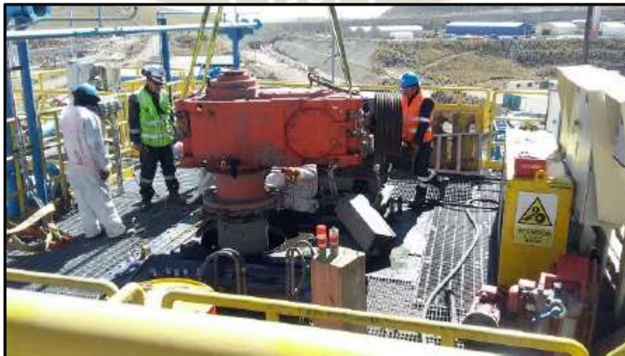
Figura 1. Mantenimiento en Celdas de Flotación
