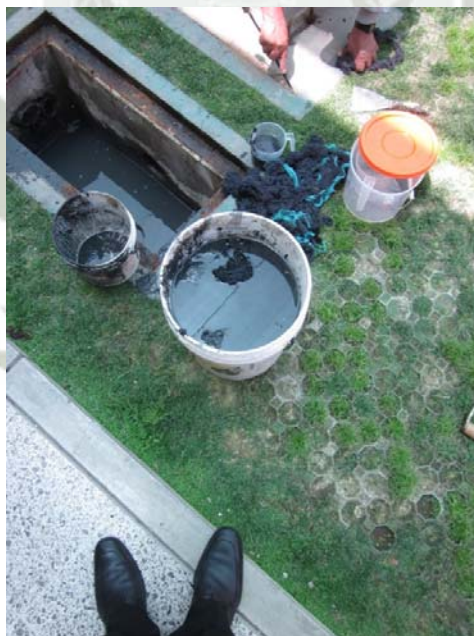
FOTO N° 10: Se observa agua residual
