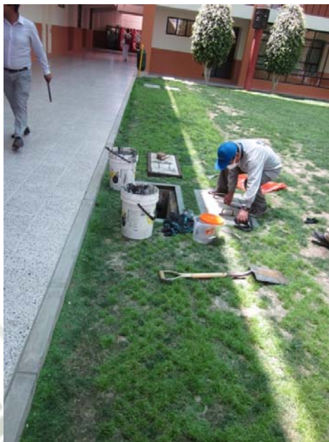
FOTO N° 9: Apertura de colector principal
