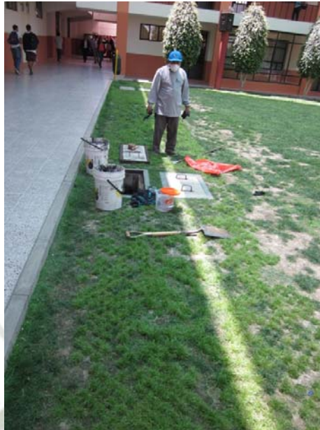
FOTO N° 7: Apertura del desarenador más importante y registro
