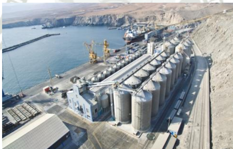
Figura 7. Sistema de almacenamiento de granos de silos
