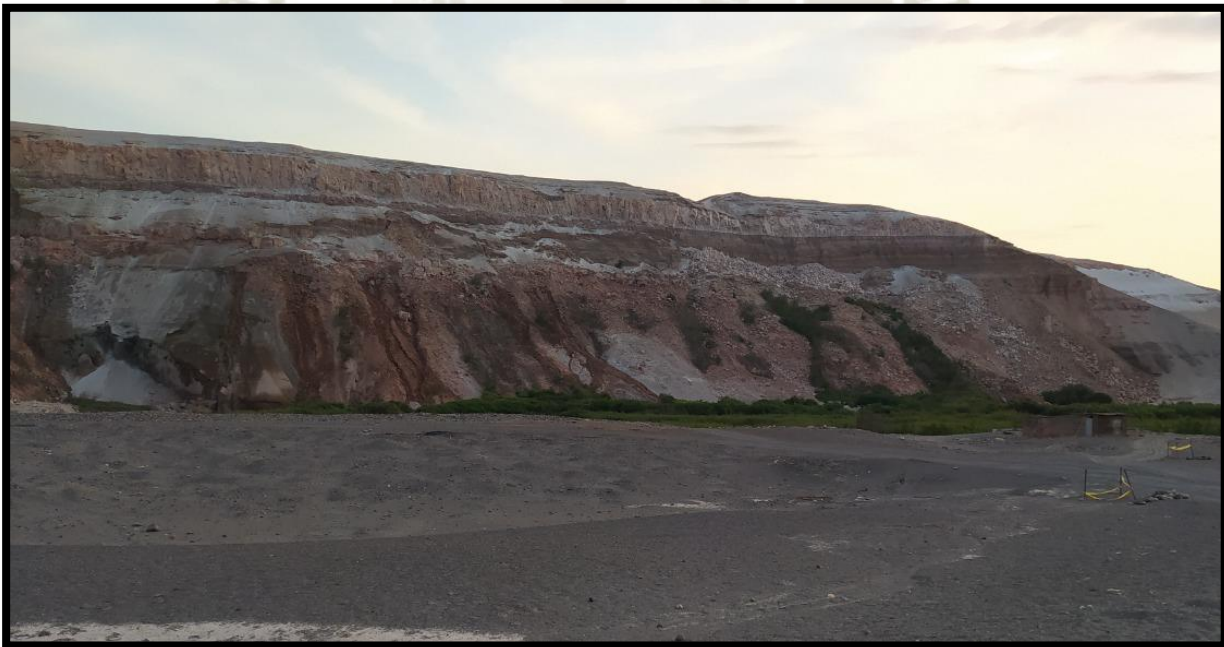
Fotografía 20: Filtraciones de La Cossio
