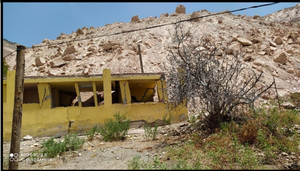
Fotografía 25: Viviendas destruidas producto de los deslizamientos en la zona de la iglesia Pie de la Cuesta
