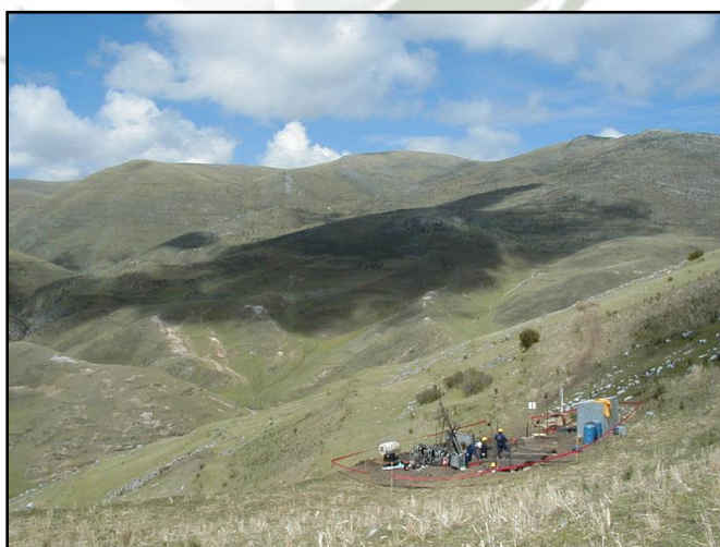
Figura N° 4. Plataforma de Perforación
