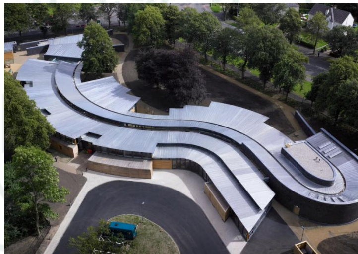
Figura 22 Vista aérea del edificio
