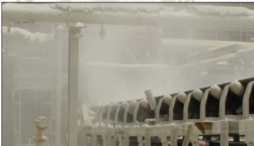
Figura 5. Polvo a la salida del túnel de la faja transportadora oversize
