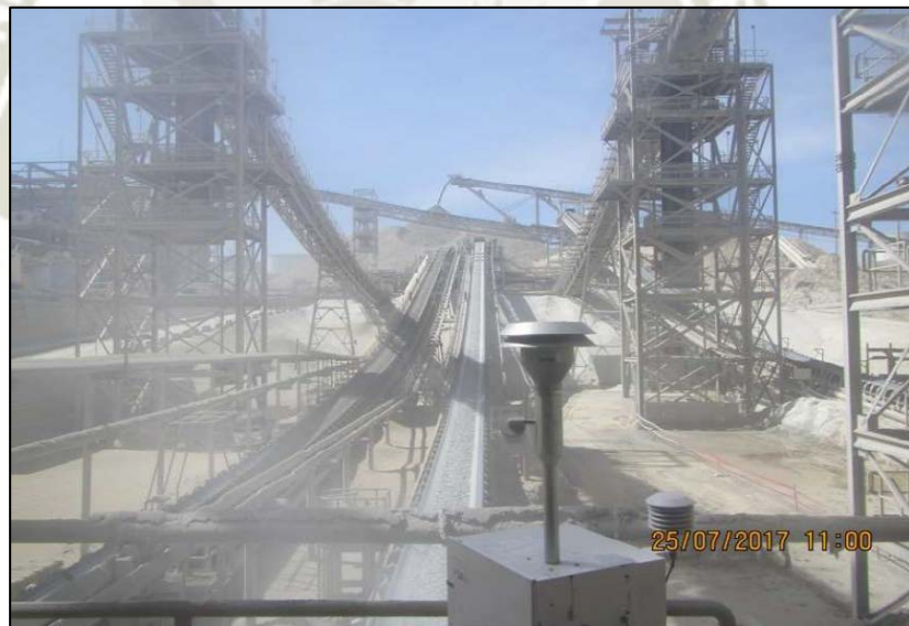
Figura 1. Polvo en las fajas transportadoras de chancado secundario.
