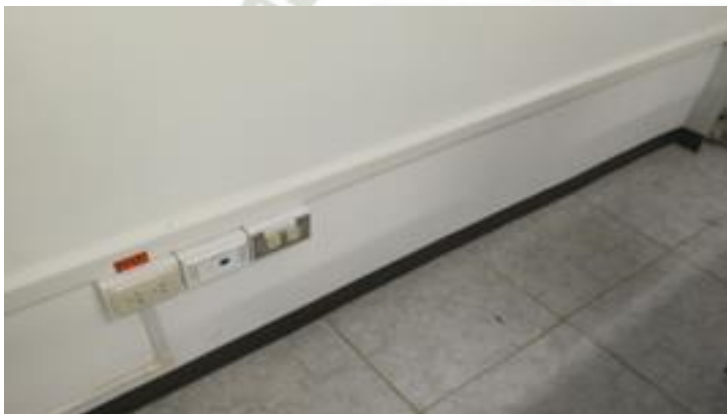
Figura 42 Corrección de instalación eléctrica
