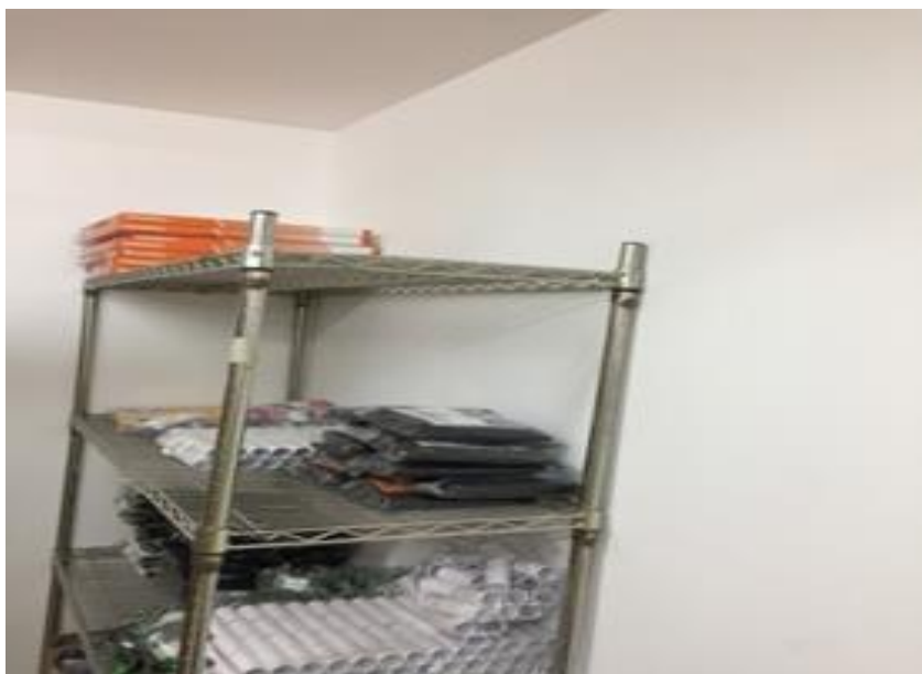
Figura 20 Sin anclajes el anaquel de las medicinas almacén central
