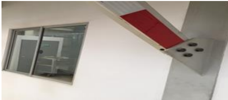
Figura 44 Retiro soporte de vigas aéreas
