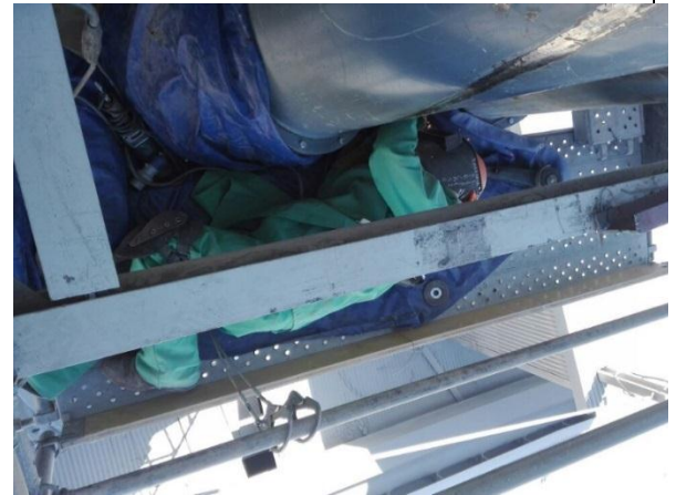
Soldadura en posición sobre cabeza tumbado.
