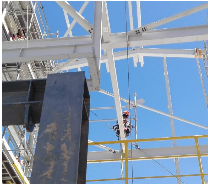
Figura N° 37. Montajista de estructuras
