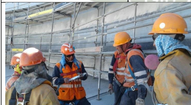
Difusión de procedimiento y especificación de trabajos de soldadura.
