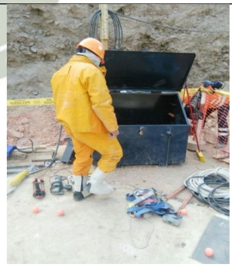
Personal soldador prepara equipos y herramientas para su traslado hacia niveles superiores.
