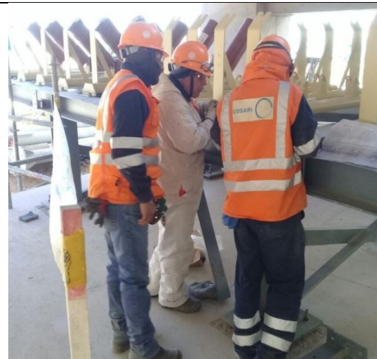
Lectura de planos de montaje y torqueo (ajuste) de estructuras.
