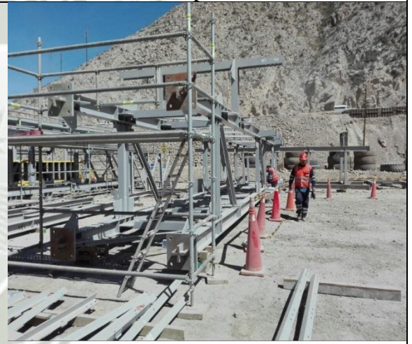
Pre-ensamblaje de estructuras grandes en almacén temporal de estructuras (Satélites).
