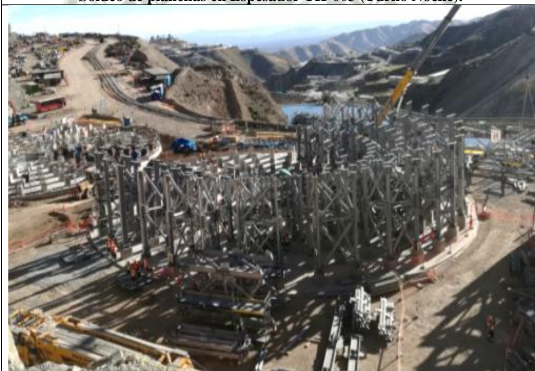
Montaje de estructuras de soporte del espesador. TH-002 Espesadores
