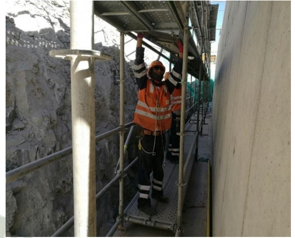
Armado de cuerpos de andamio.
