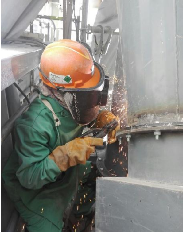
Soldadura de uniones de estructura de acero. Posición Agachado
