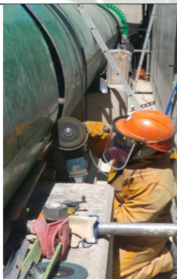
Personal soldador realiza corte con amoladora en posición arrodillado y brazos en alto.
