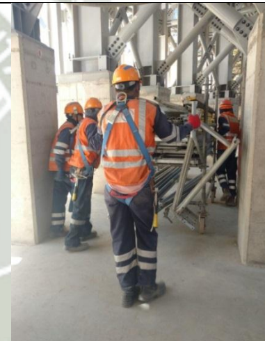
Traslado de piezas de andamio para montaje.
