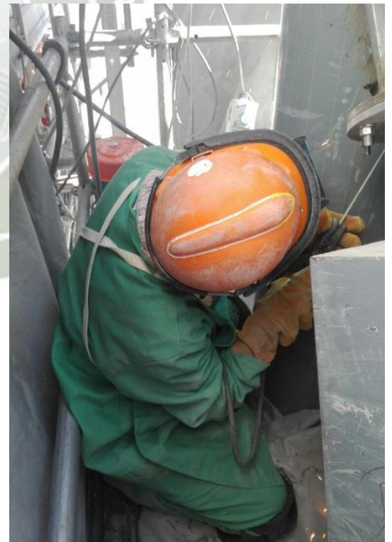
Soldadura en posición Arrodillado inclinado.
