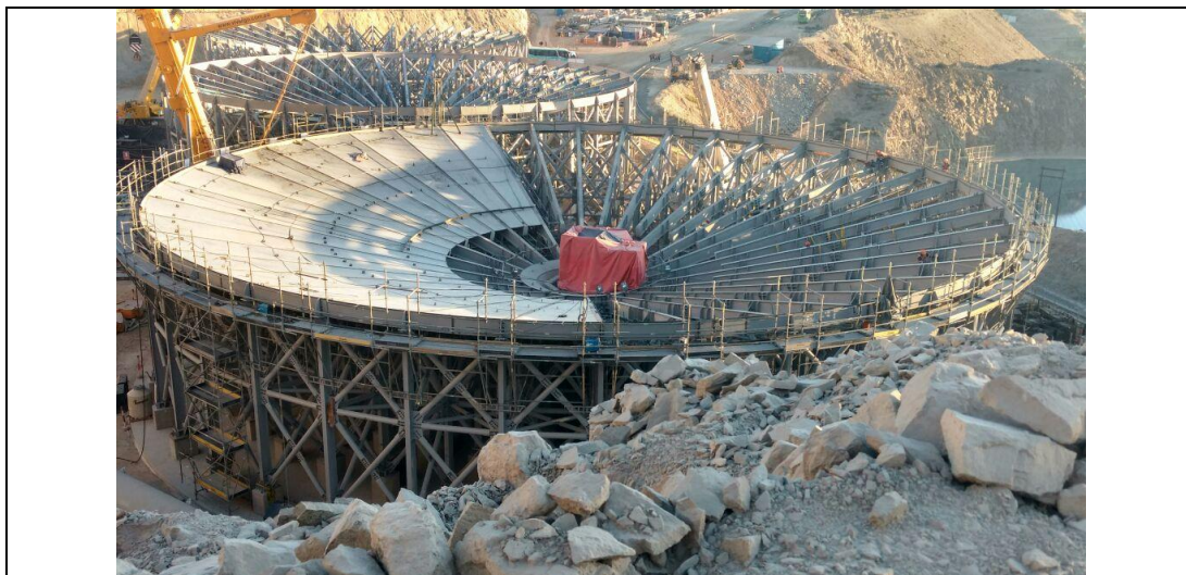
Montaje de planchas de fondo TH-001
