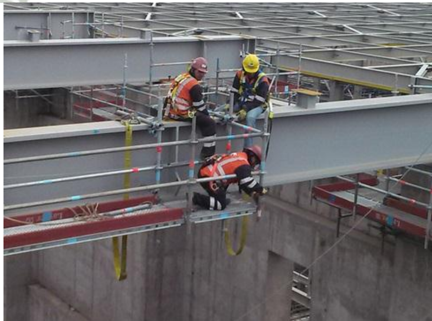
Figura N° 63. Armado de andamio voladizo.
