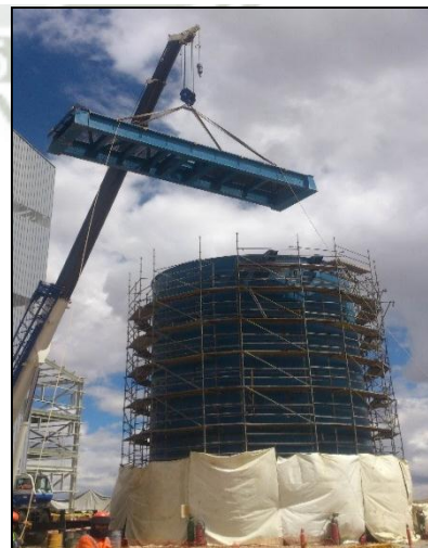
Figura N° 8. Montaje de super estructura
