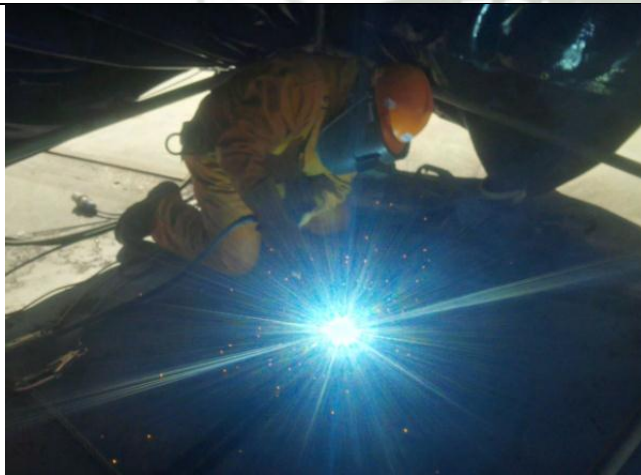
Soldadura en posición de rodillas inclinado.
