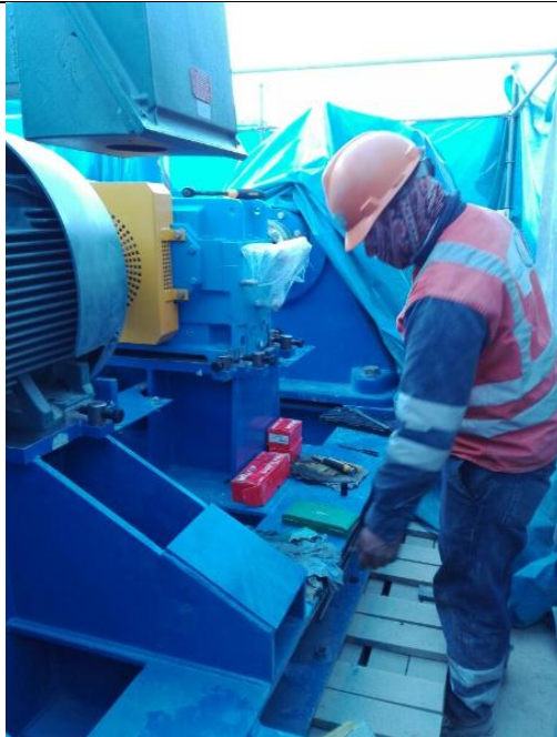
Ajuste de pernos en equipos estáticos.
