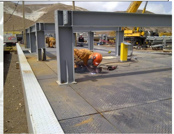
Soldadura en posición de rodillas muy inclinado.
