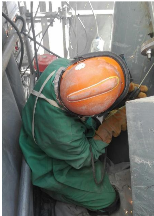
Figura N° 50. Apuntalado de estructuras.
