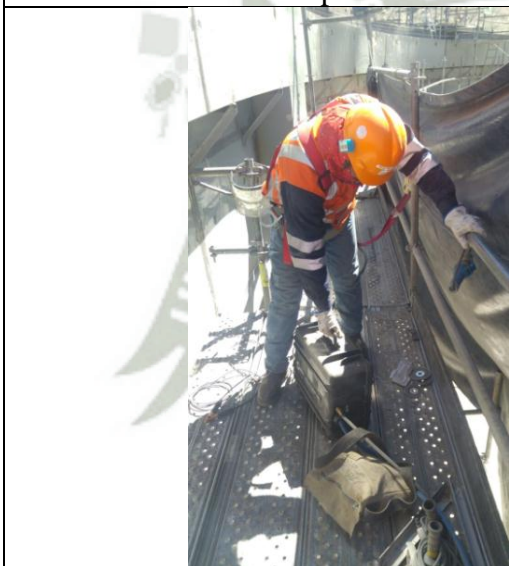
Traslado de herramientas portátiles y materiales de soldadura a niveles superiores.
