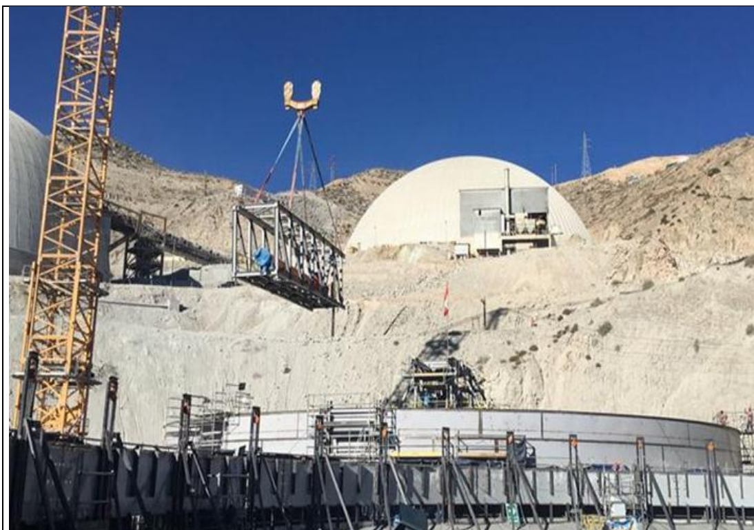
Espesadores TH-003 Montaje de puente Tramo 02
