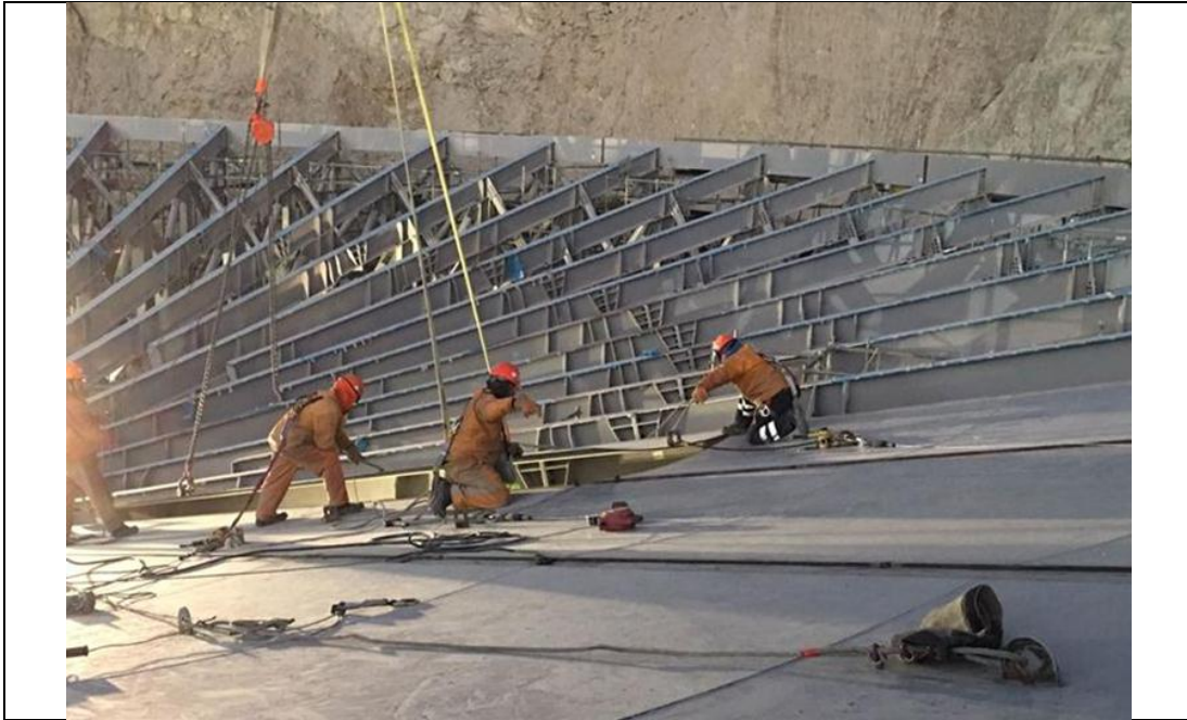
Soldeo de planchas de fondo de Espesadores
