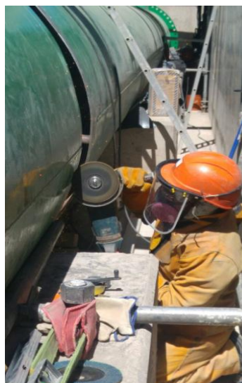
Figura N° 27. Corte de tubería con esmeril.
