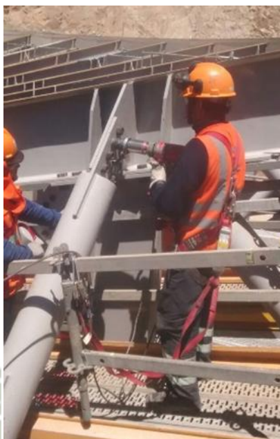
Figura N° 14. Torqueo de pernos en espesadores.
