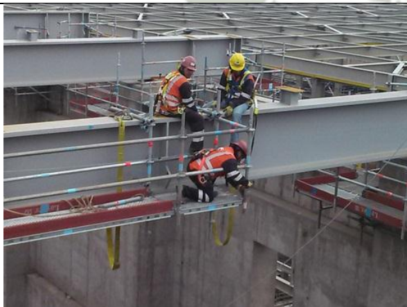
Armado de voladizo de andamio a desnivel.
