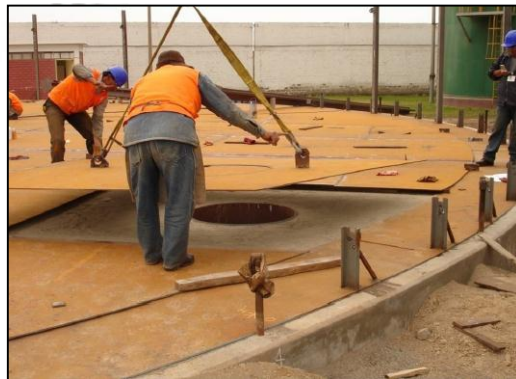
Figura N° 7. Tendido de planchas de fondo sobre la cimentación
