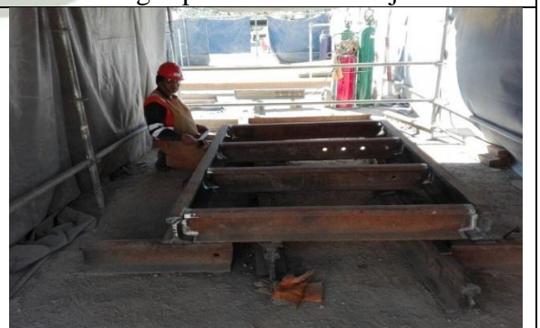
Medición y modificación de estructuras previas a su montaje.
