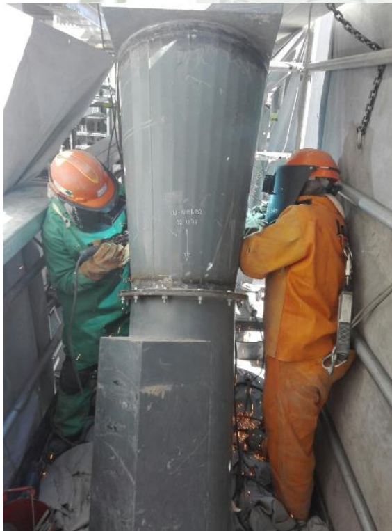
Soldadura de uniones de estructura de acero. Posición de pie.
