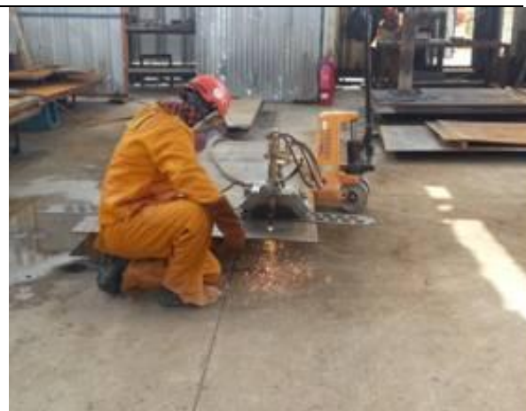
Soldadura en taller de carpintería metálica.
