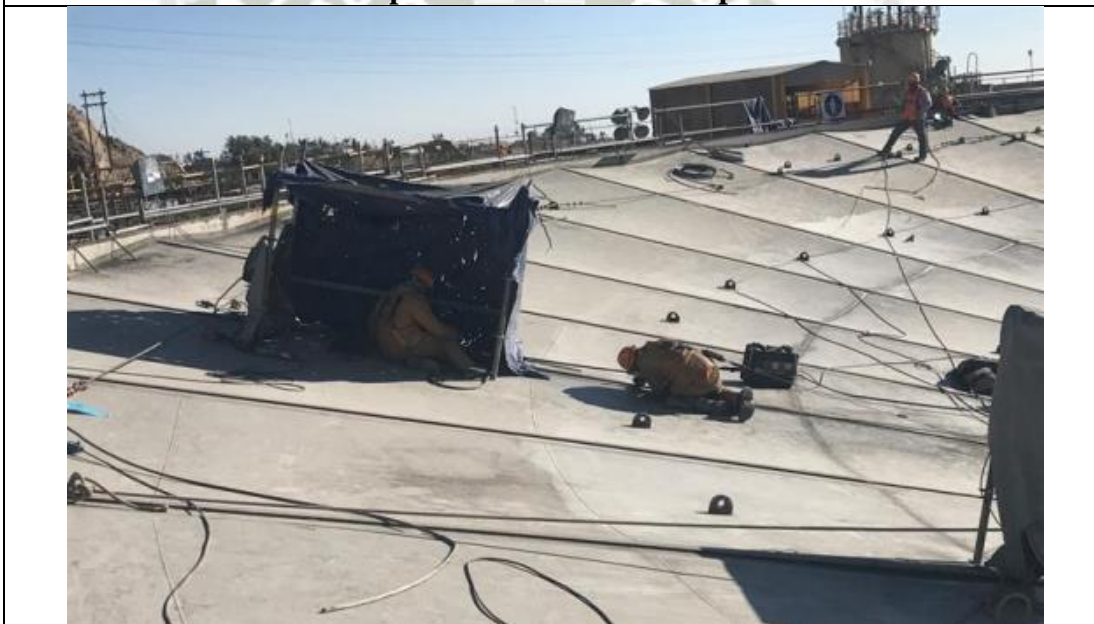
Soldeo de planchas en Estaciones de soldadura sobre tanque espesador.
