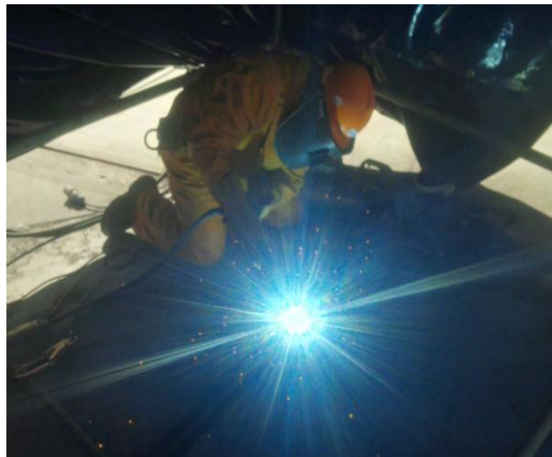
Figura N° 51. Apuntalamiento de estructura (planchas de acero).
