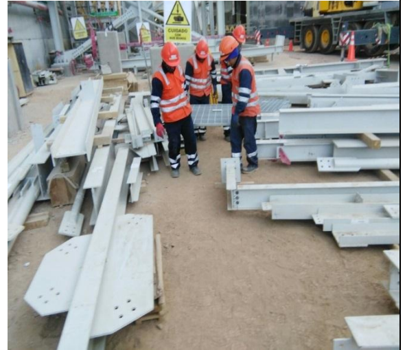
Traslado de estructuras desde almacén temporal.
