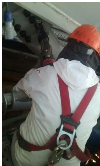
Figura N° 16. Torqueo de pernos en estructura sobre cuerpo de andamio.
