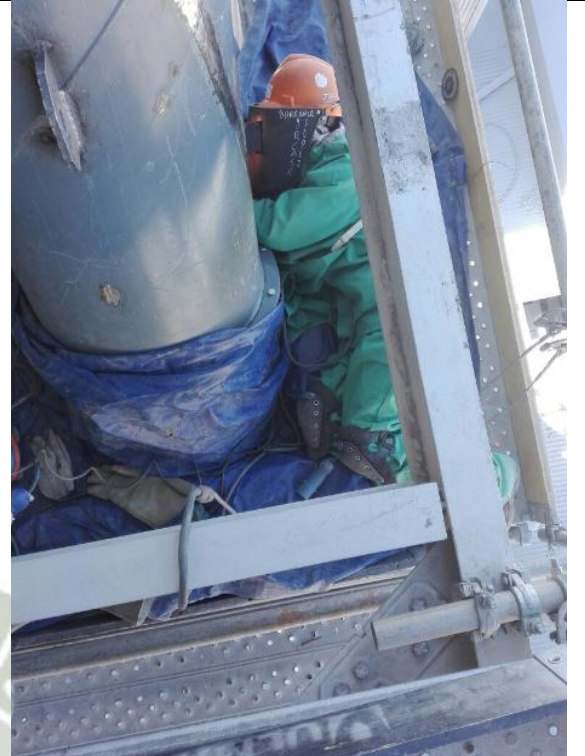
Soldadura en posición Tumbado
