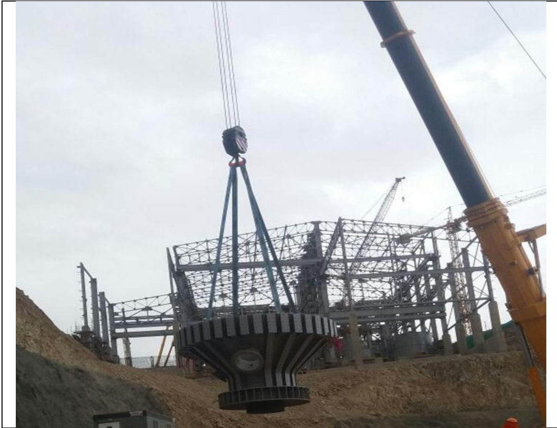
Montaje de Cono Central espesador TH-002
