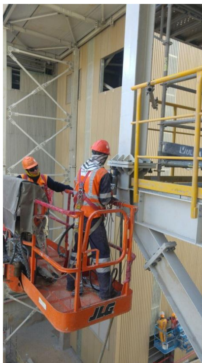
Figura N° 15. Torqueo de pernos en estructura sobre manlift.
