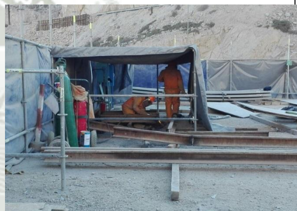
Corte de planchas de acero y/o pequeñas vigas previo a su montaje.
