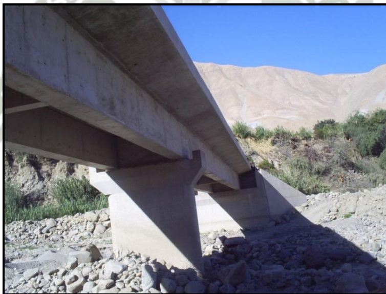
Figura 1.4 Estado actual del puente La Capilla.
