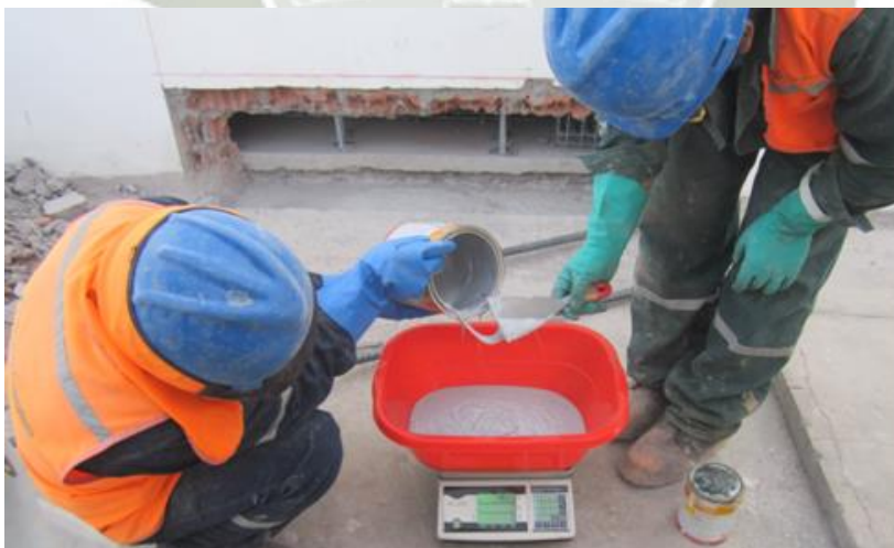
Figura 6.13 Preparación de aditivo epóxido.
