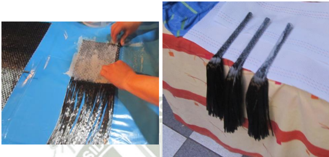
Figura 6.10 Preparación de anclajes con FRP.
