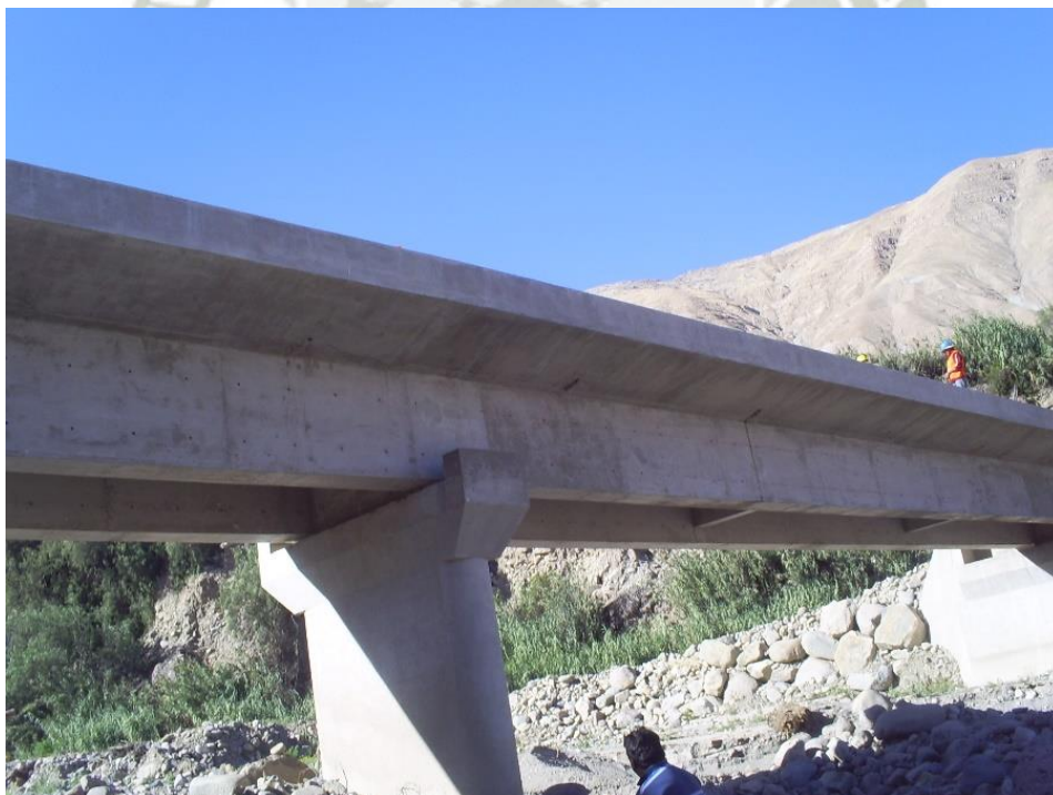
Figura 3.6 Puente La Capilla con un pilar central.
