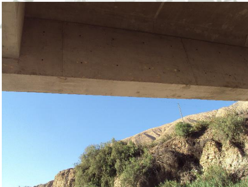
Figura 3.8 Fisura típica por flexión en vigas principales.
