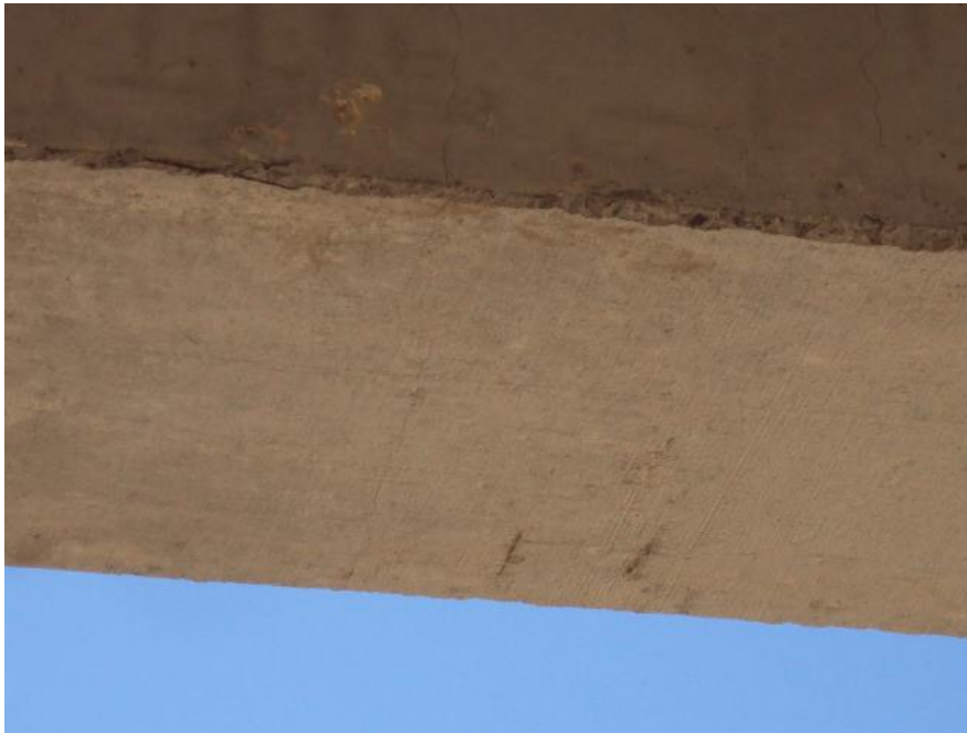
Figura 3.11 Se observa el resane de fisuras en vigas.
