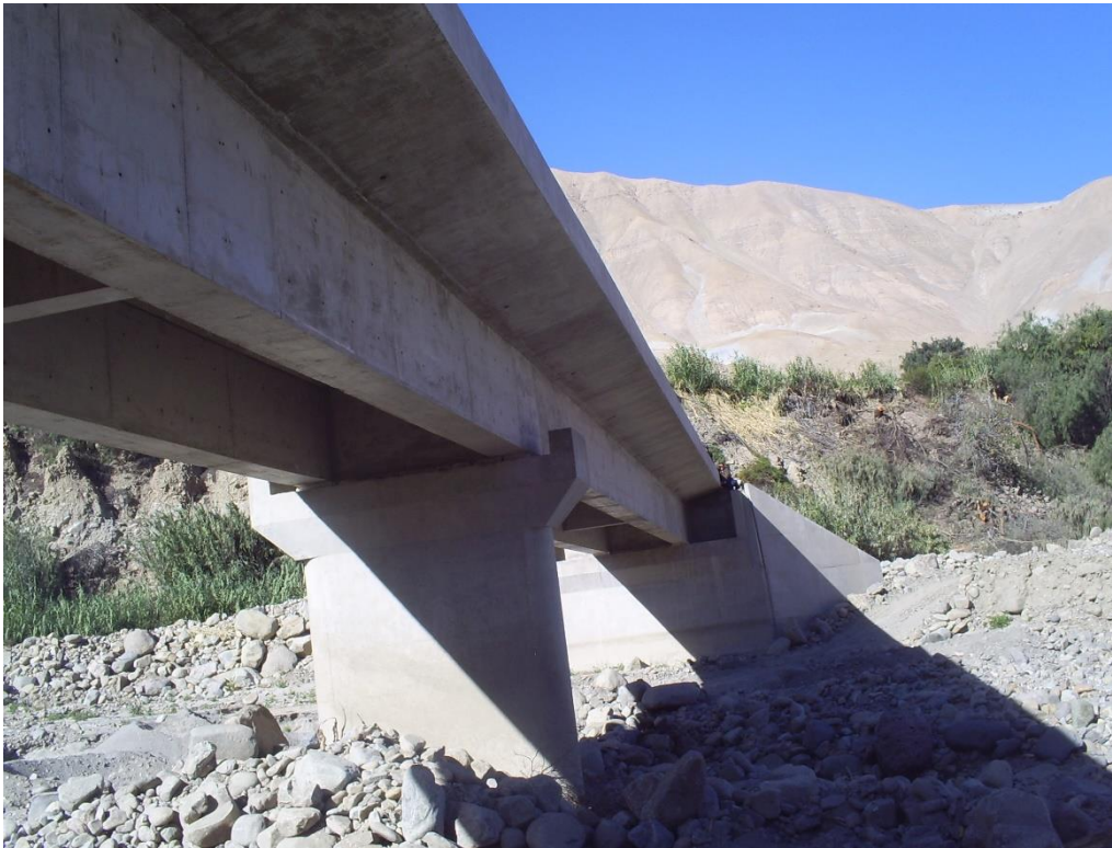
Figura 3.5 Vista del puente tipo viga losa existente del puente La Capilla
