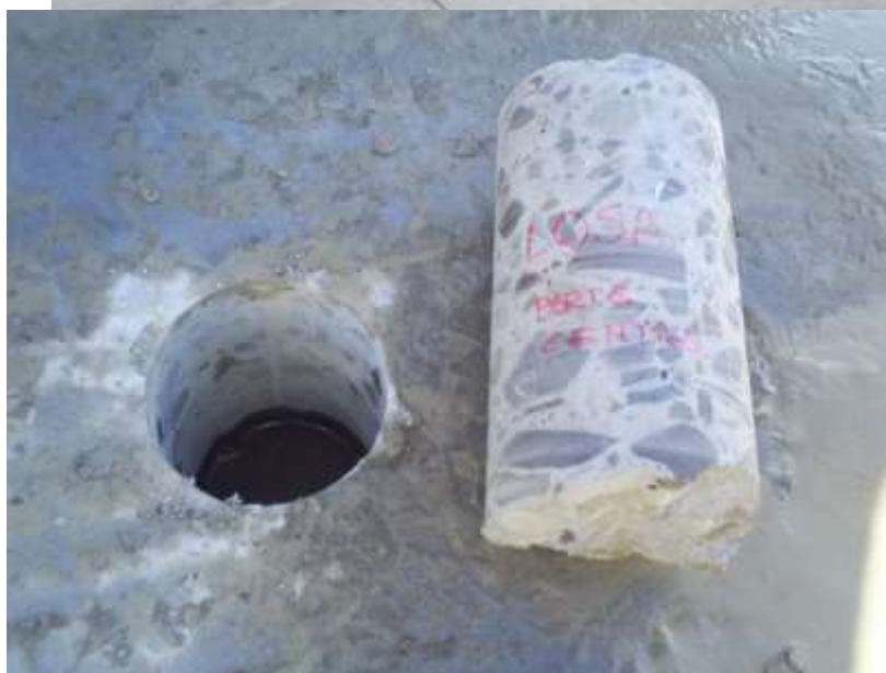
Extracción de testigos de concreto con equipo de diamantinas
