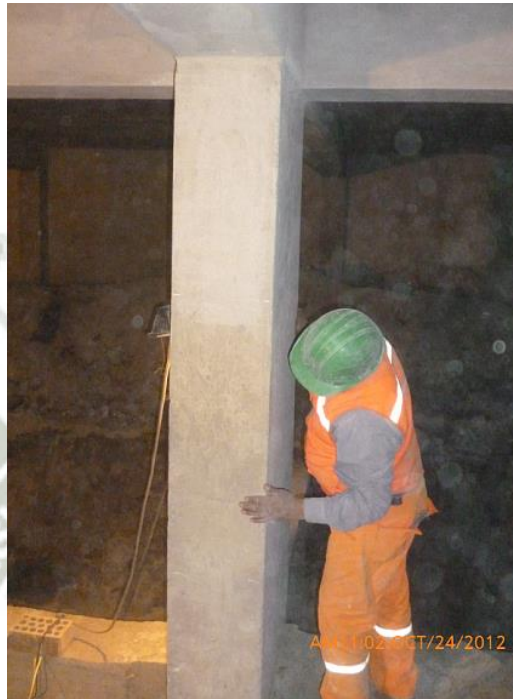
Figura 6.9 Preparación de la superficie a reforzar con FRP.
