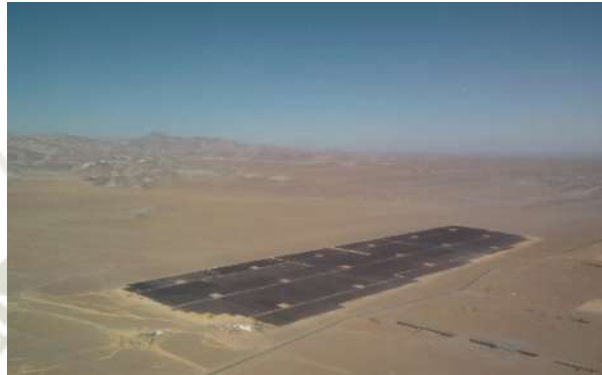
Gráfico 2. 16 – Central solar fotovoltaica Repartición 20T
