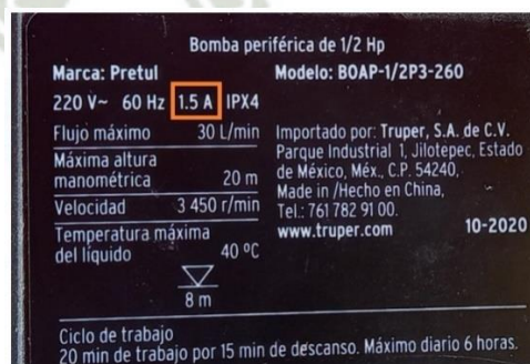
Figura 14: Placa del motor, 1.5A.
