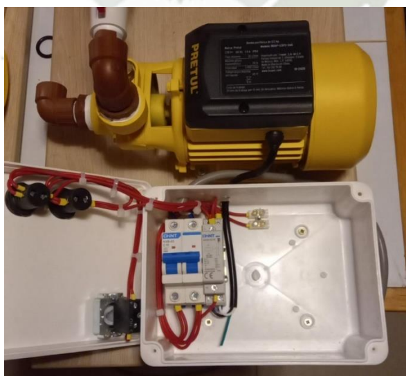
Figura 8: Instalación del arranque del motor.
