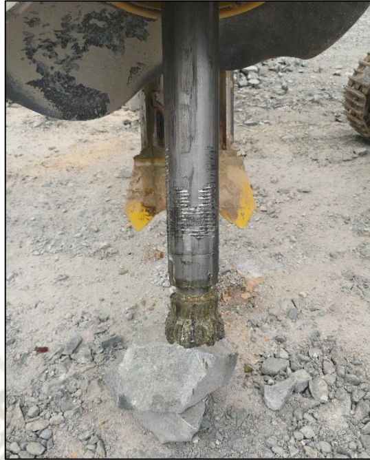
Ilustración 5: Inspección de la Broca DTH en el equipo
