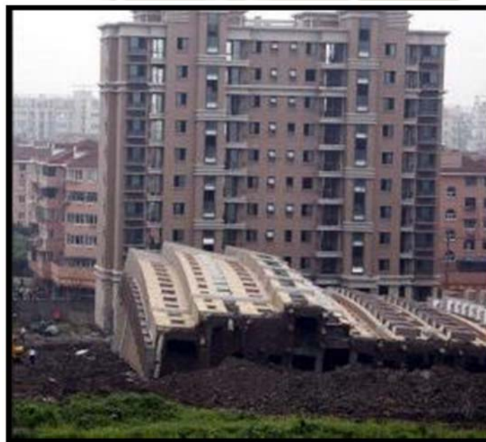
Figura 3. 8 Edificio se voltea en Shanghái.(CIGIR, 2009)
