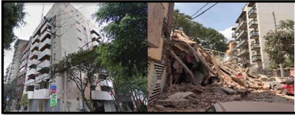
Figura 3. 3 Edificio en la Ciudad de México, falla por Resistencia y Ductilidad. (Raúl Serrano Lizaola, 2001)
