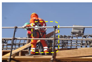
Cambio de punto de Anclaje de arnés
