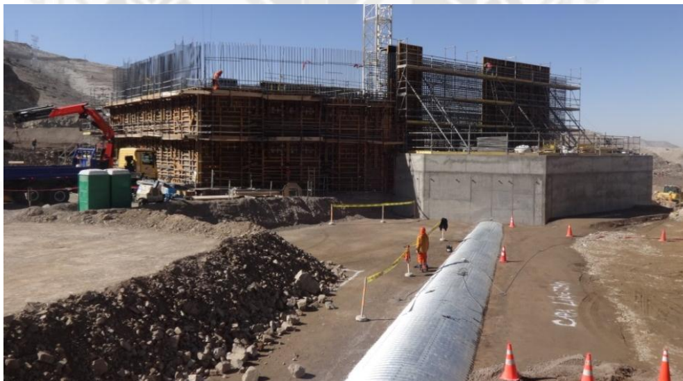
Foto 29 Conexión de tubería multiplate 30 con suroeste de cámara central
