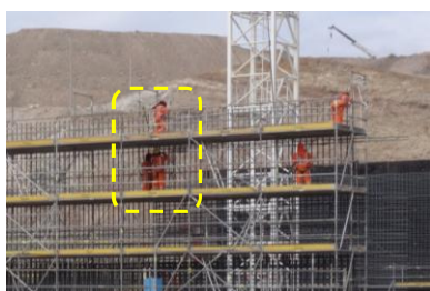
Colocación de acero en parte superior del muro
