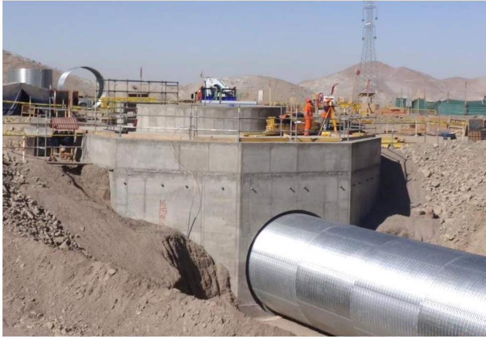
Foto 11 Relleno Estructural en Cámara TK-29
