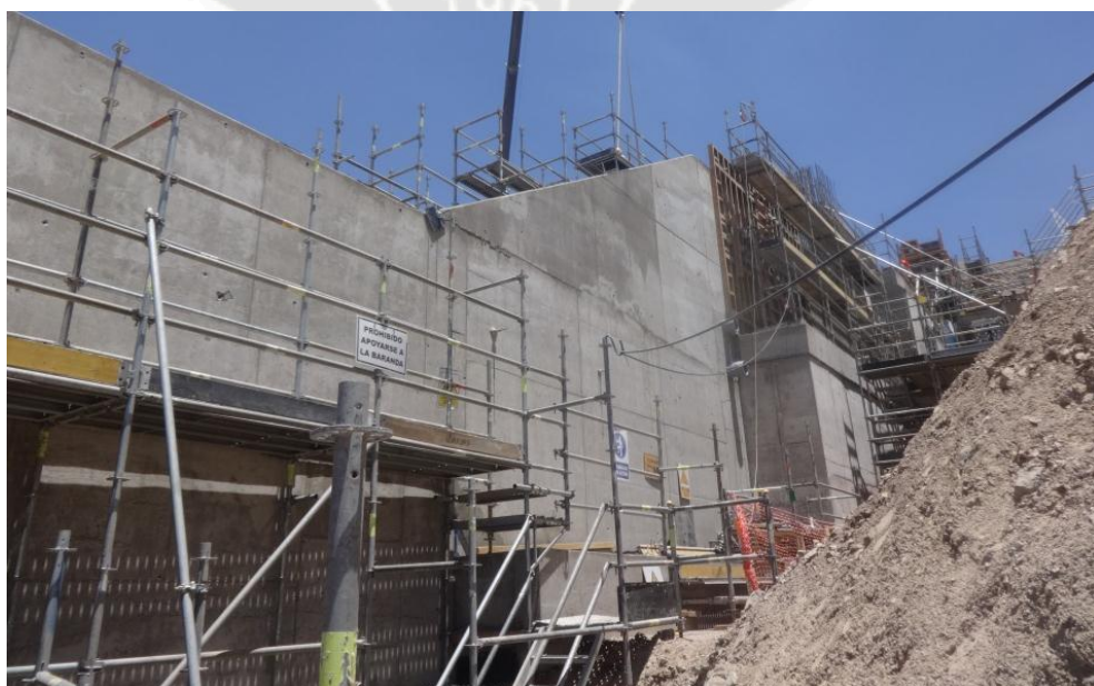
Foto 34 Vista Este del canal Slurry Fall – Noviembre 2014
