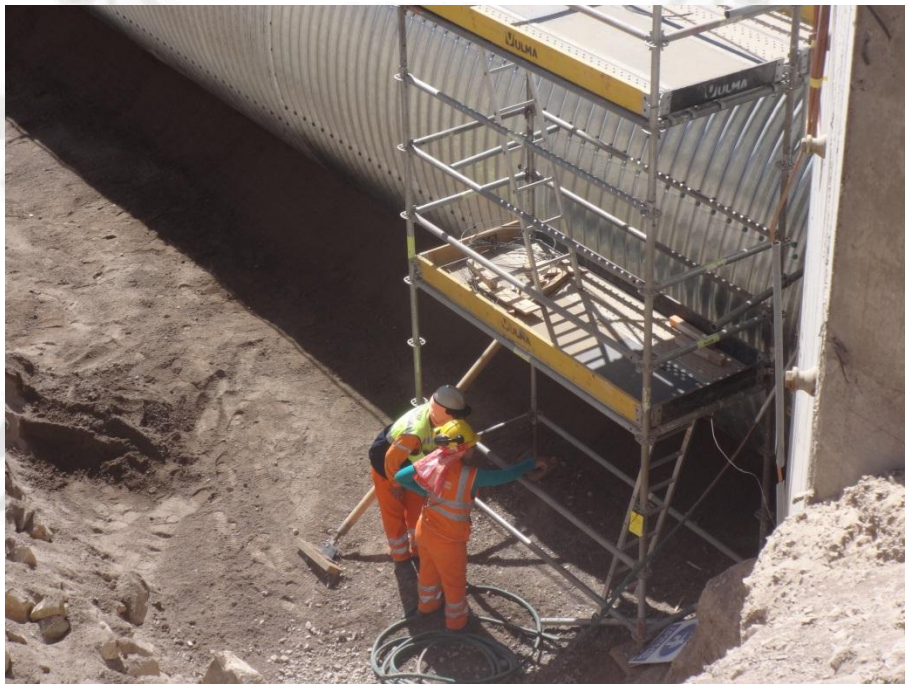
Foto 70 Inspección de área en túneles multi-plates
