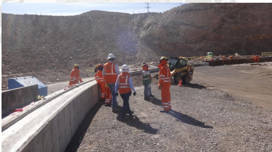
Foto 78 Reinducción a la cuadrilla de Movimiento de Tierras
