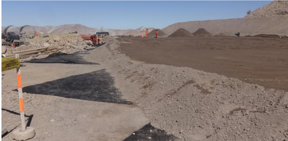
Foto 43 Colocación de relleno tipo 3 sobre geotextil
