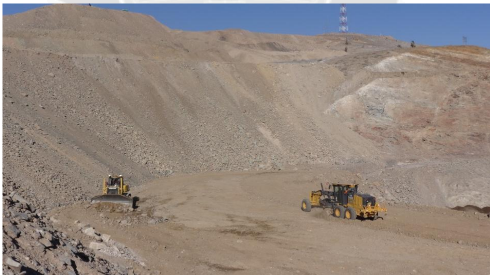
Foto 42 Nivelación de relleno masivo tipo 3
