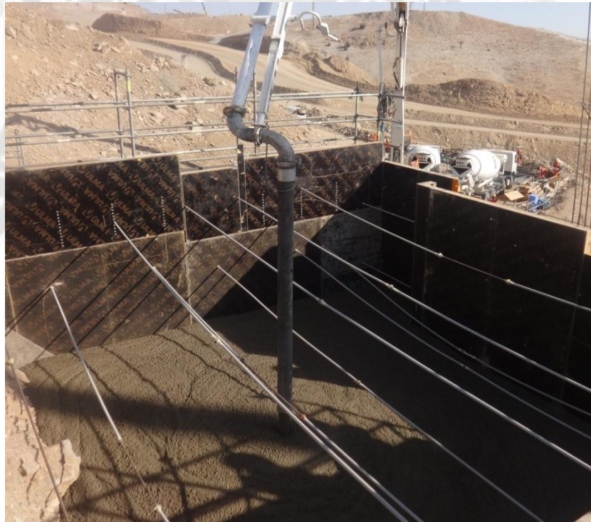
Foto 31 Colocación de concreto pobre para fundación de Slurry Fall
