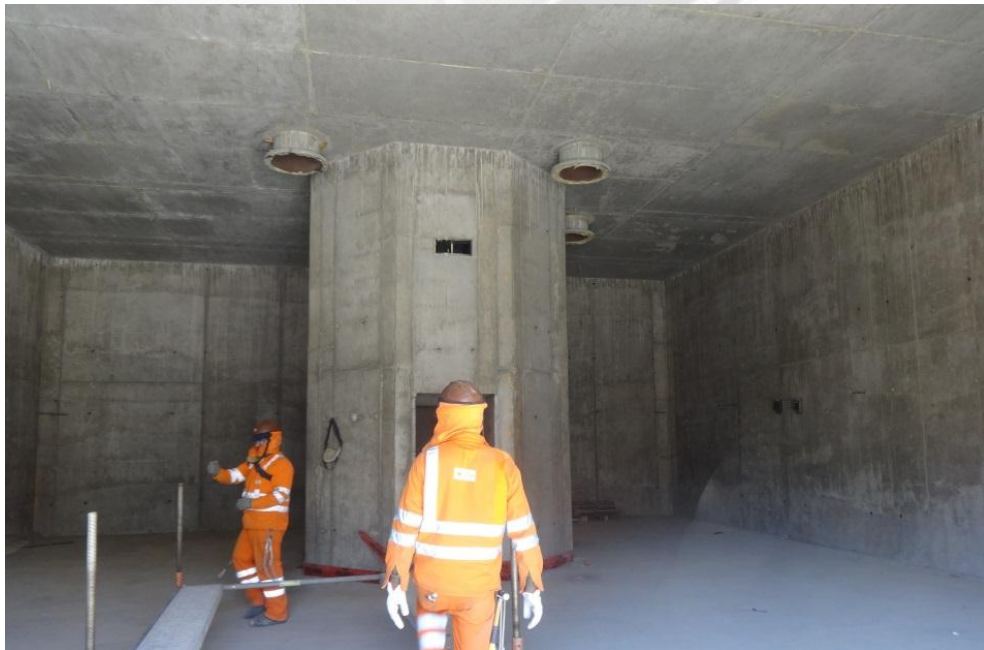
Foto 63 Acabado de concreto en cámara de espesado
