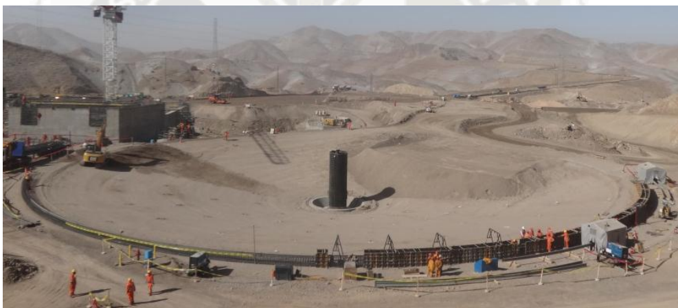
Foto 13 Perfilado de relleno para cono TK-12
