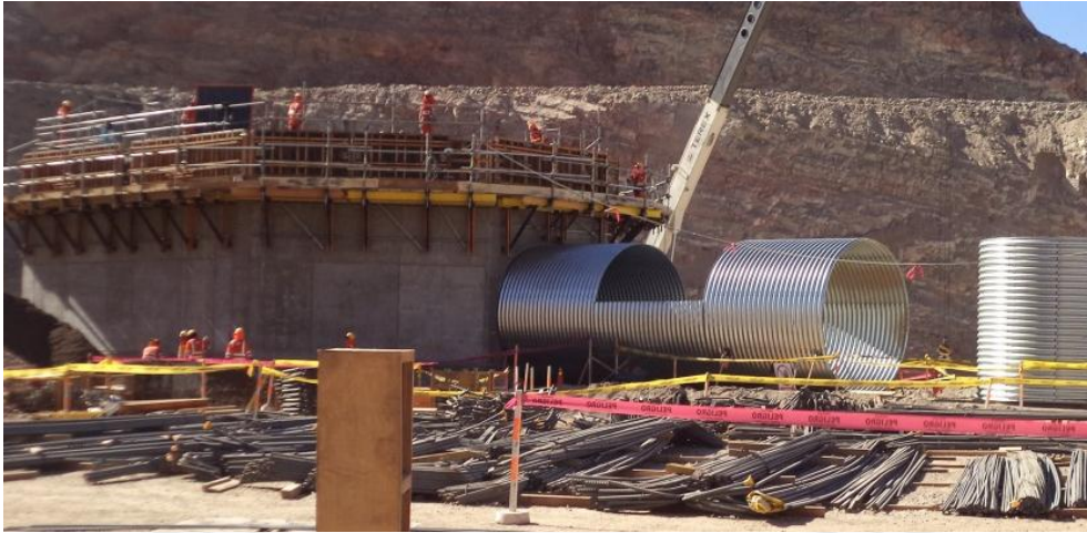
Foto 8 Montaje de anillos para túnel Multi-Plate en TK-11
