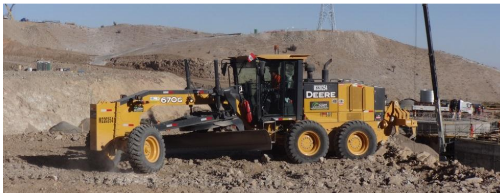
Foto 40 Motoniveladora en nivelación de relleno
