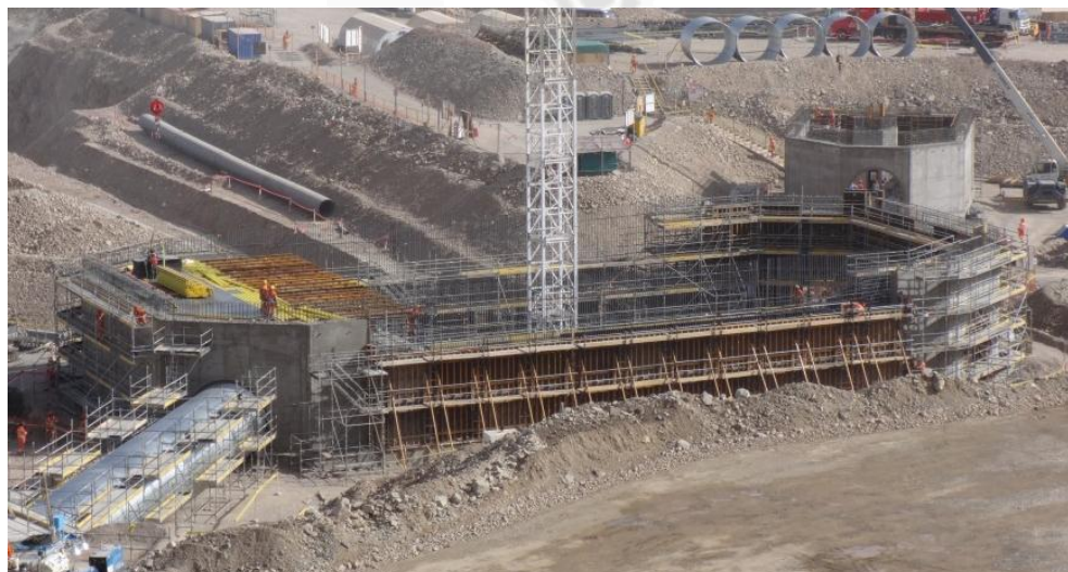
Foto 23 Encofrado de muros centrales zona norte
