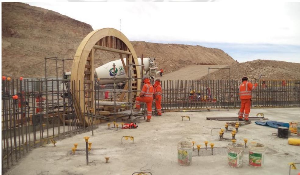
Foto 20 Encofrado de ingreso a tubería multiplate zona noroeste
