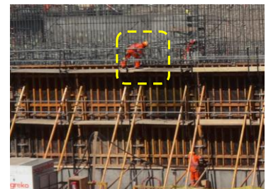
Asegurado de Panel de encofrado
