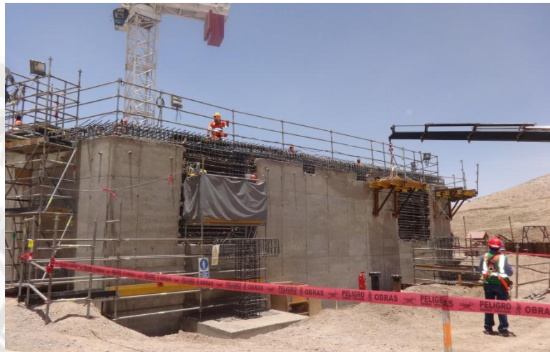
Foto 75 Barrera/ cinta de seguridad color rojo: Izaje en ejecución.
