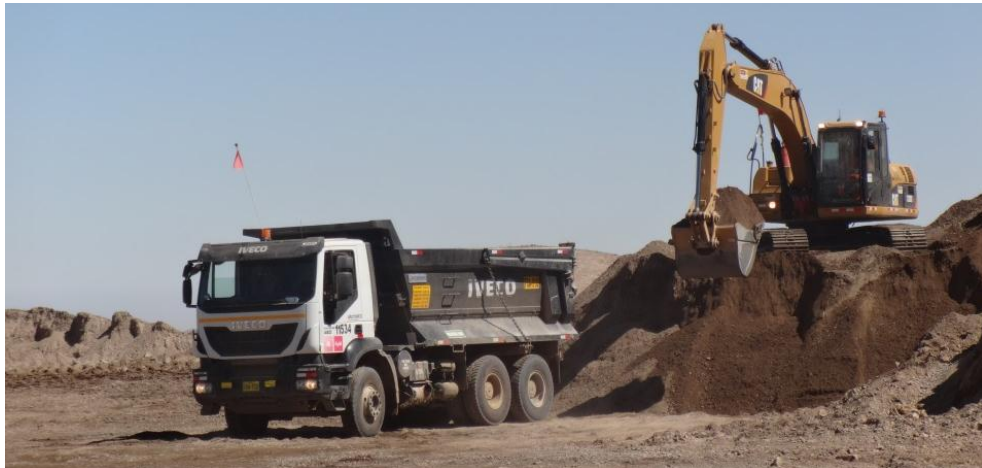
Foto 41 Carguío de material tipo 3
