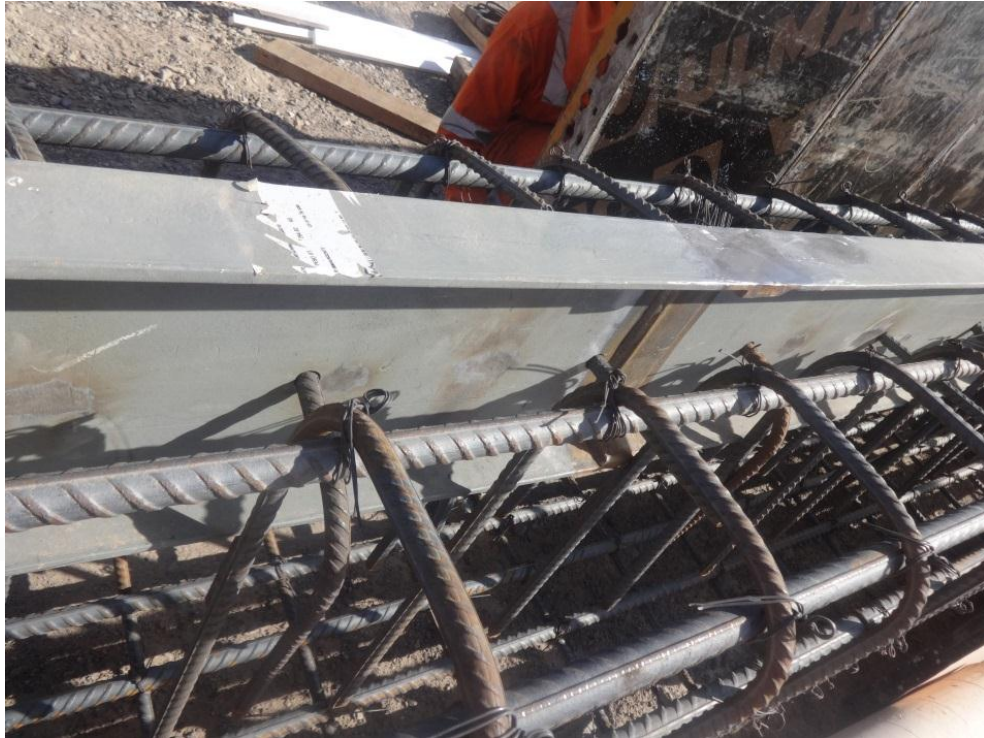
Foto 64 Soldadura de embebido en canaleta en bordillos perimetrales
