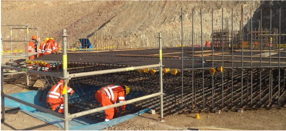
Foto 5 Colocación de Acero en losa de fundación del TK-11
