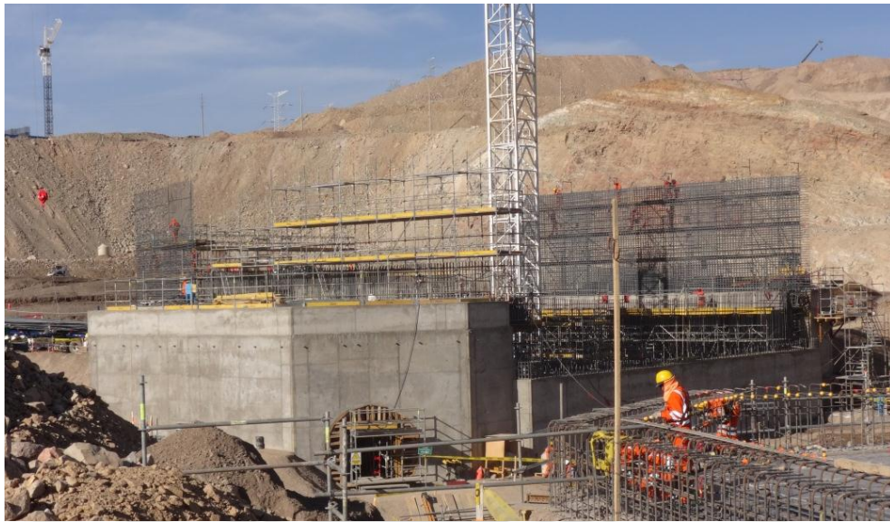
Foto 28 Vista Sur de la cámara central en construcción
