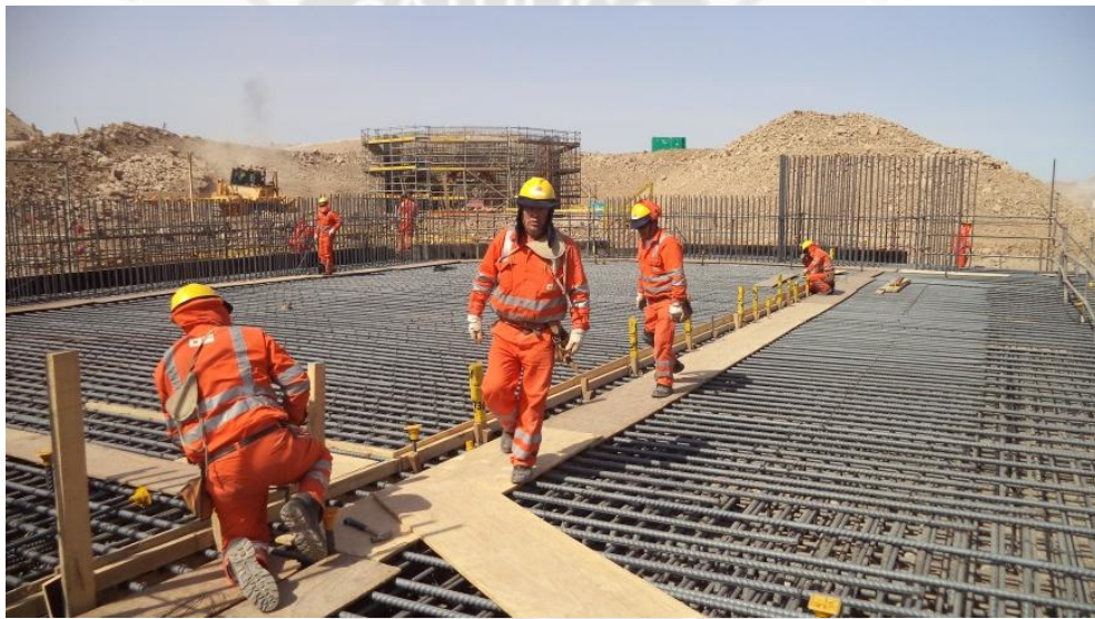
Foto 19 Colocación de acero en losa de piso de la Cámara Central
