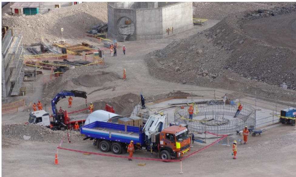
Foto 67 Izaje de paneles de encofrado al área
