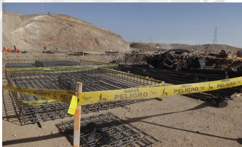
Foto 76 Barrera/ cinta de seguridad color rojo: Izaje en ejecución.
