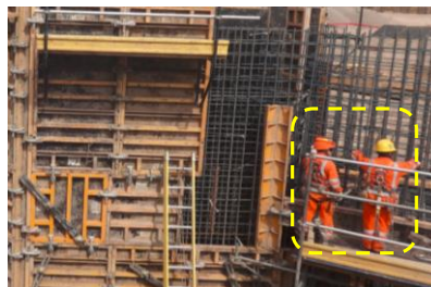
Espera de Personal por interferencia con grúa
