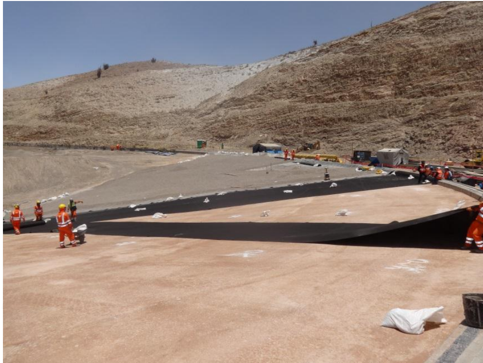
Foto 15 Colocación de geotextil no tejido sobre la capa de arcilla
