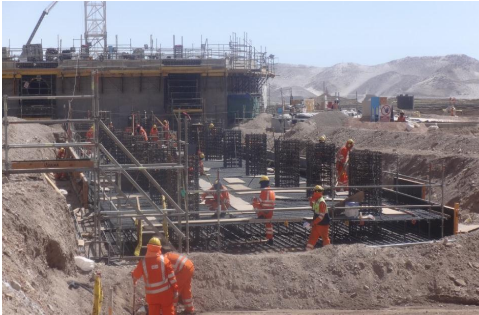
Foto 37 Colocación de acero en losas y pedestales del soporte de alimentador
