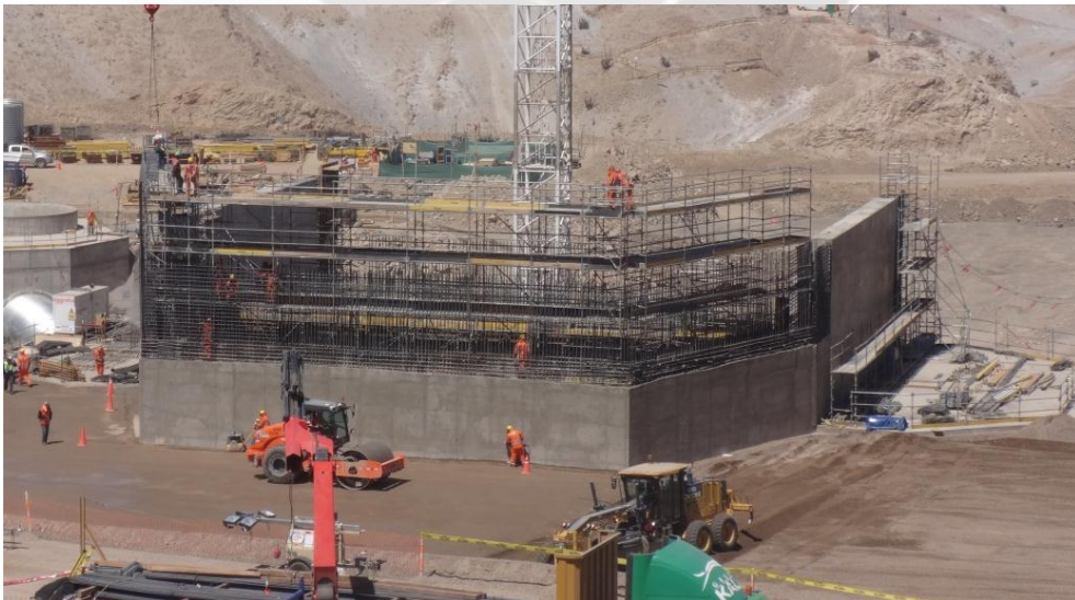
Foto 25 Colocación de acero en muros 2do nivel – lado norte
