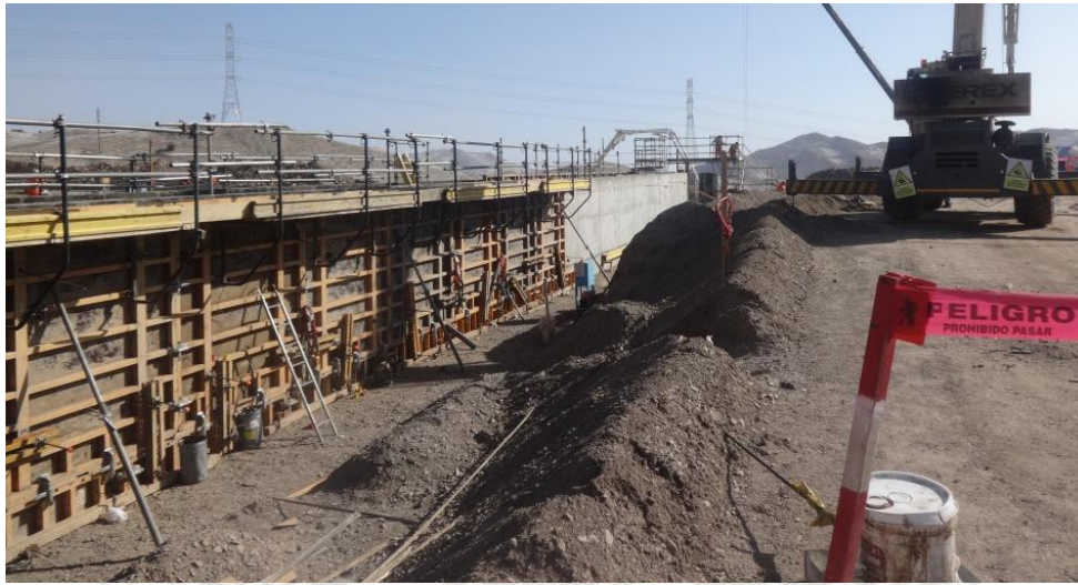
Foto 35 Encofrado del canal en zona recta
