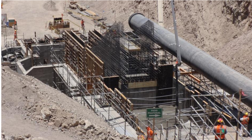
Foto 32 Colocación de encofrado en sectores 1 y 2 del canal
