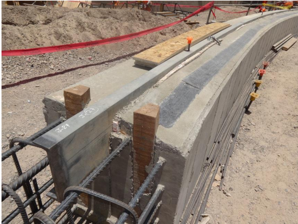
Foto 17 Bordillo perimetral en fundación para el tanque de acero
