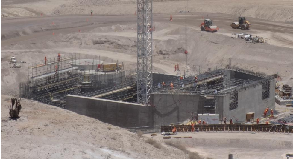
Foto 26 Vista este de la cámara central en construcción – Setiembre 2014
