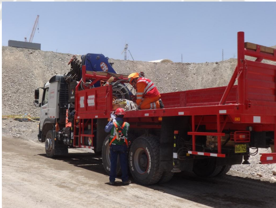
Foto 82 Revisión de los Permisos de Izajes a equipos
