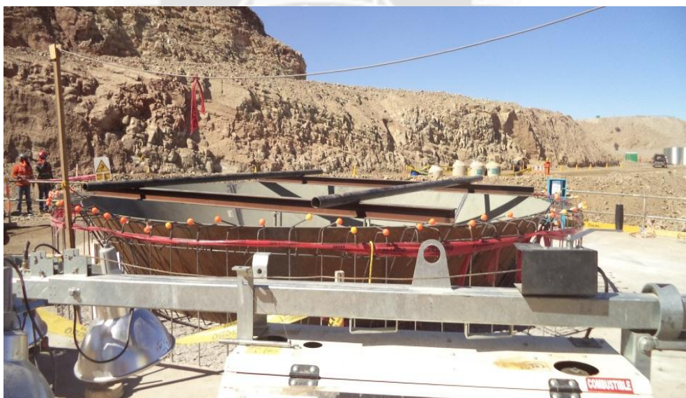
Foto 65 Soldadura de cono de revolución
