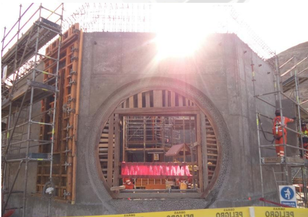
Foto 7 Desencofrado de muros en TK-11
