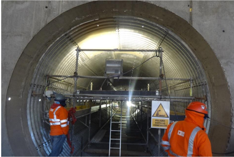
Foto 62 Colocación de soportes dentro de tubería multiplate
