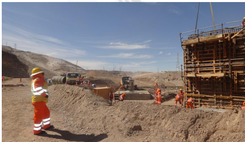
Foto 74 Control de izajes por parte de señalera
