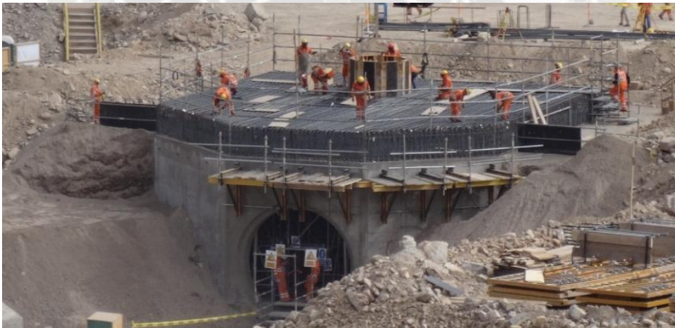
Foto 9 Colocación de Acero en losa del TK-30
