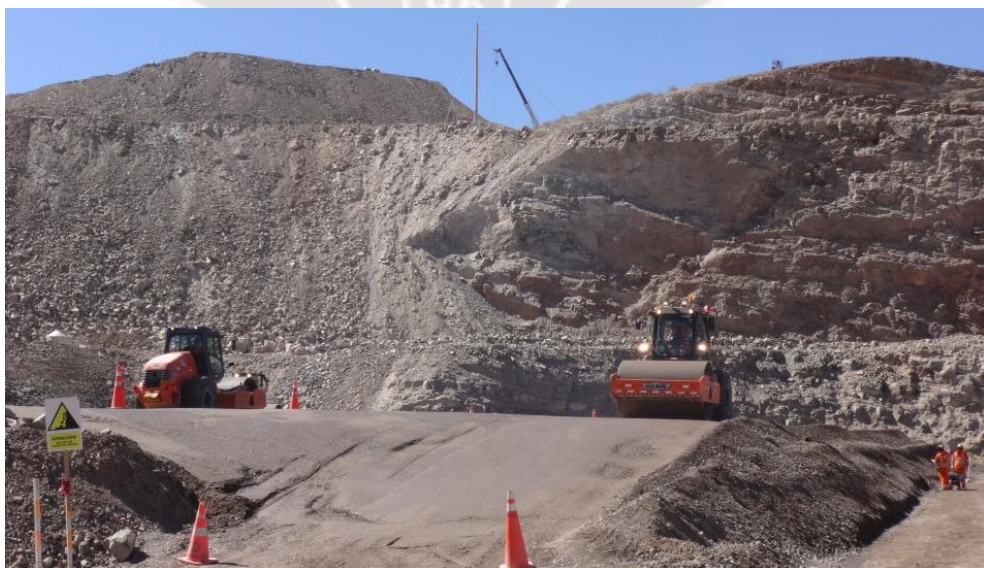
Foto 45 Compactación de capas de relleno estructural masivo
