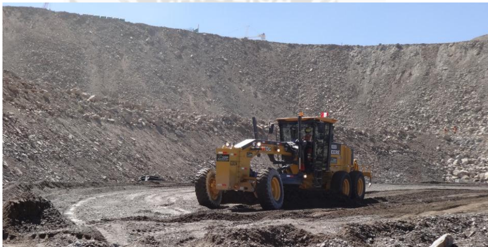
Foto 44 Conformación de capas de relleno
