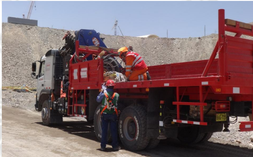
Foto 73 Revisión de Procedimientos de Izaje por Supervisor de Seguridad
