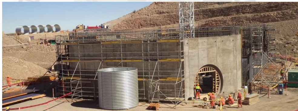
Foto 22 Desencofrado de los muros primer nivel lado este
