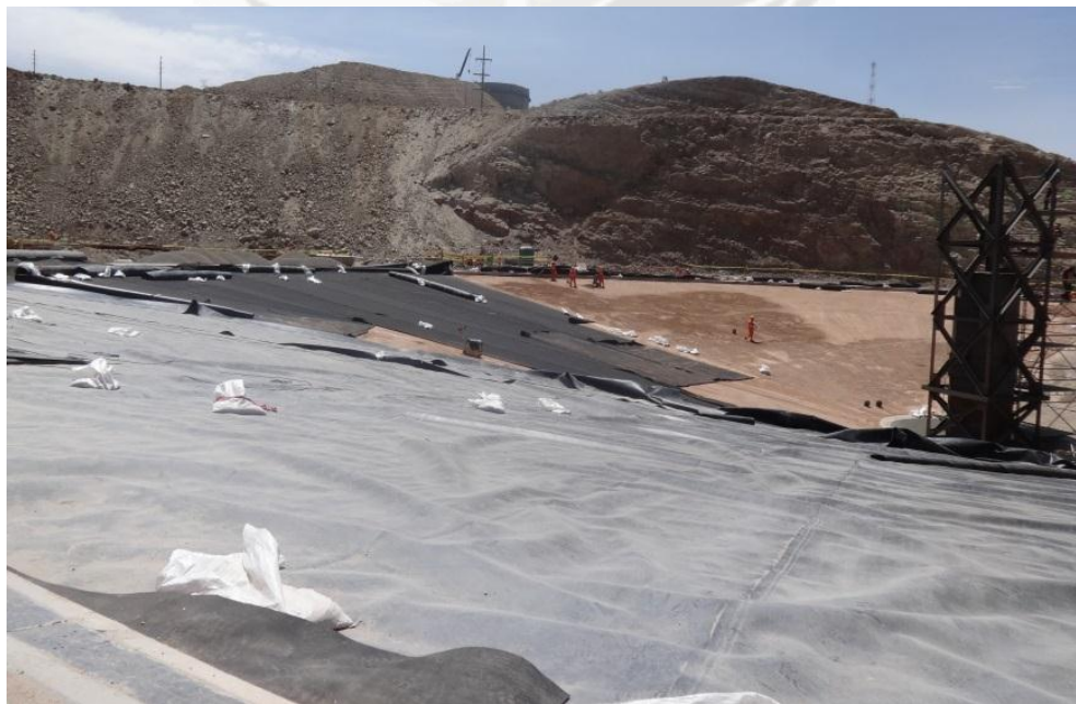
Foto 16 Colocación de membrana HDPE sobre geotextil
