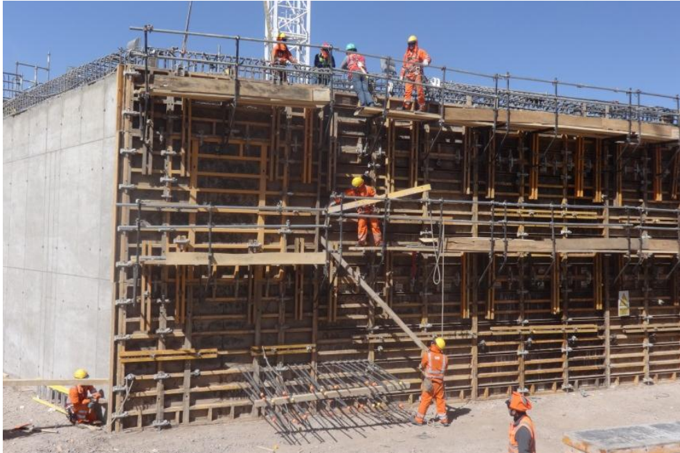
Foto 60 Encofrado de muro sur en cámara central
