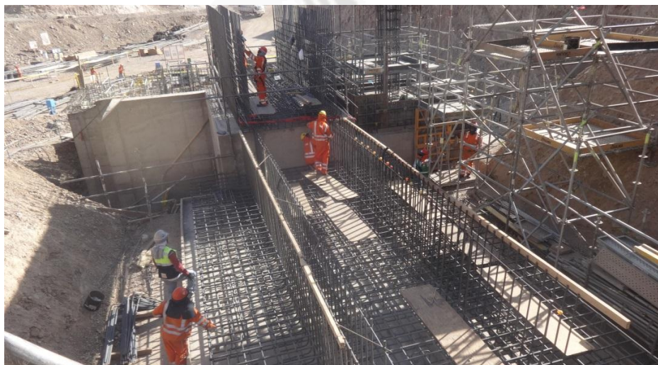
Foto 77 Colocación de Sistemas de Protección Colectiva por la cuadrilla
