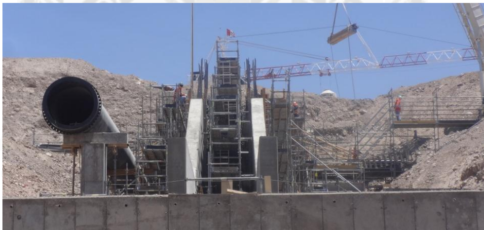
Foto 33 Vista Sur del canal Slurry Fall en construcción
