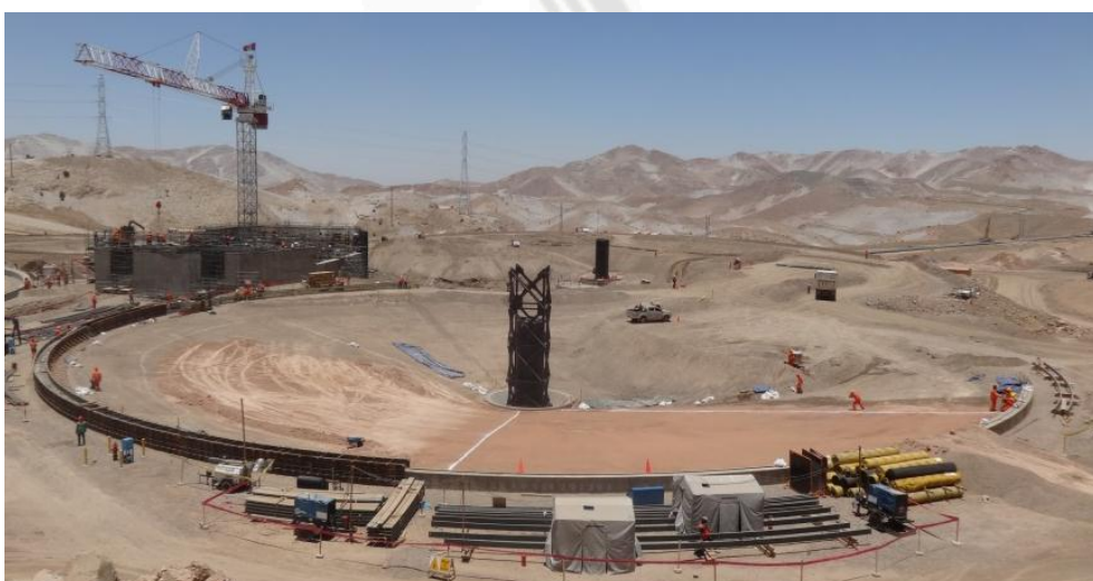
Foto 14 Colocación de Arcilla preparada
