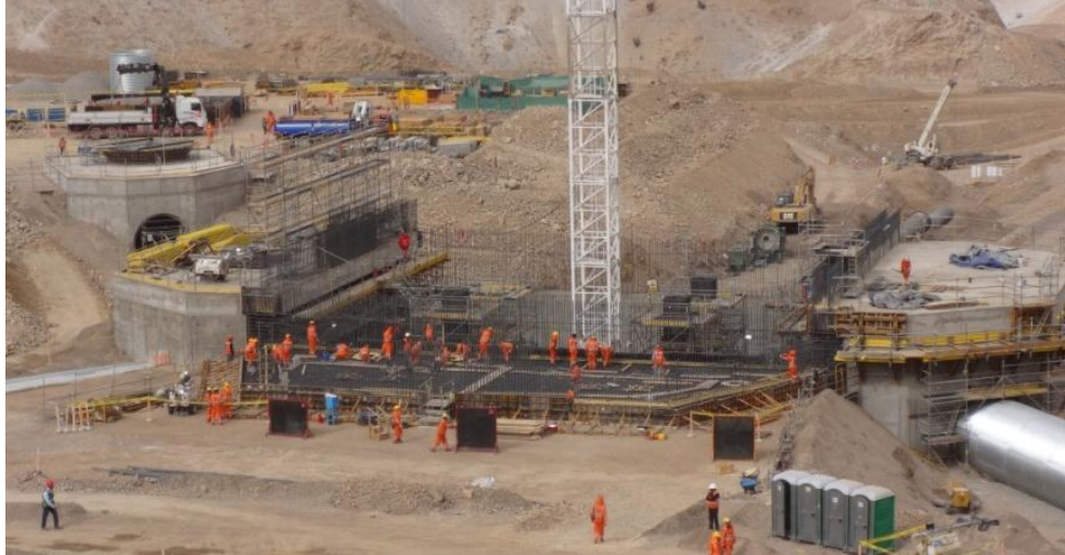
Foto 24 Colocación de acero en ala contra terreno norte
