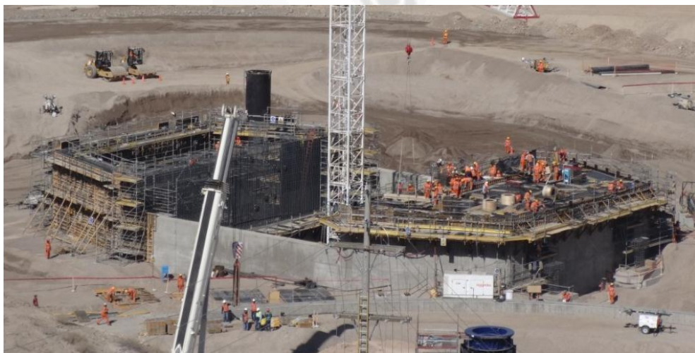
Foto 30 Vaciado de concreto en losa sur de la cámara central
