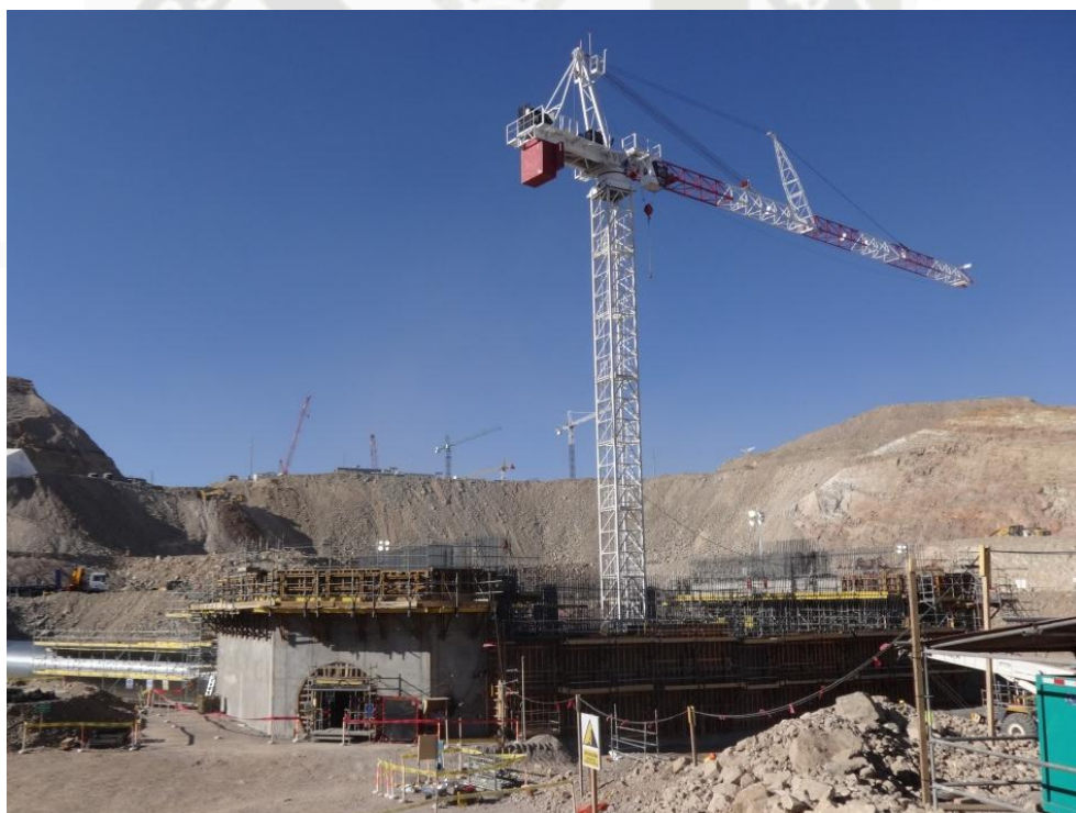
Foto 68 Izajes con torre grúa de paneles de encofrados
