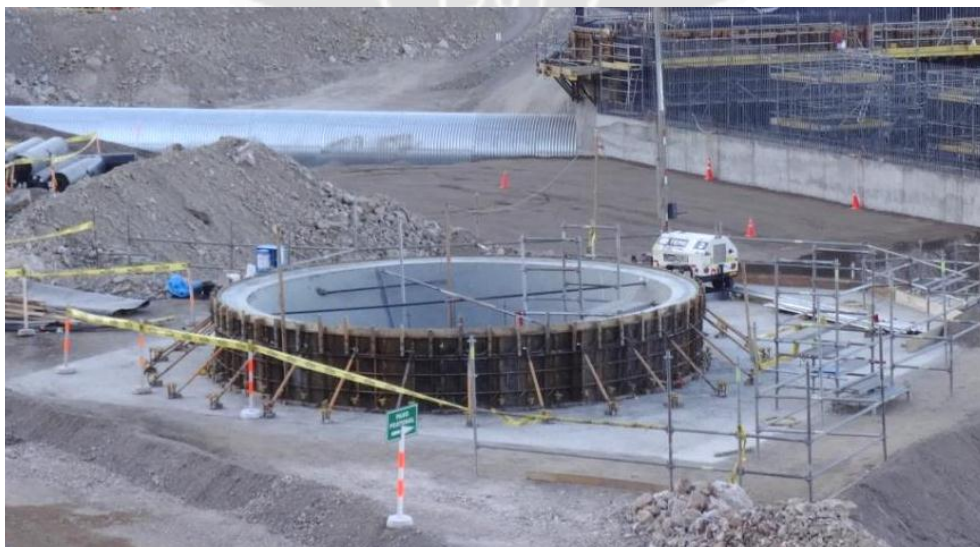
Foto 10 Concreto en el cono de revolución del TK-12
