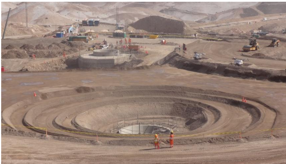
Foto 12 Relleno masivo sobre el tanque TK-12
