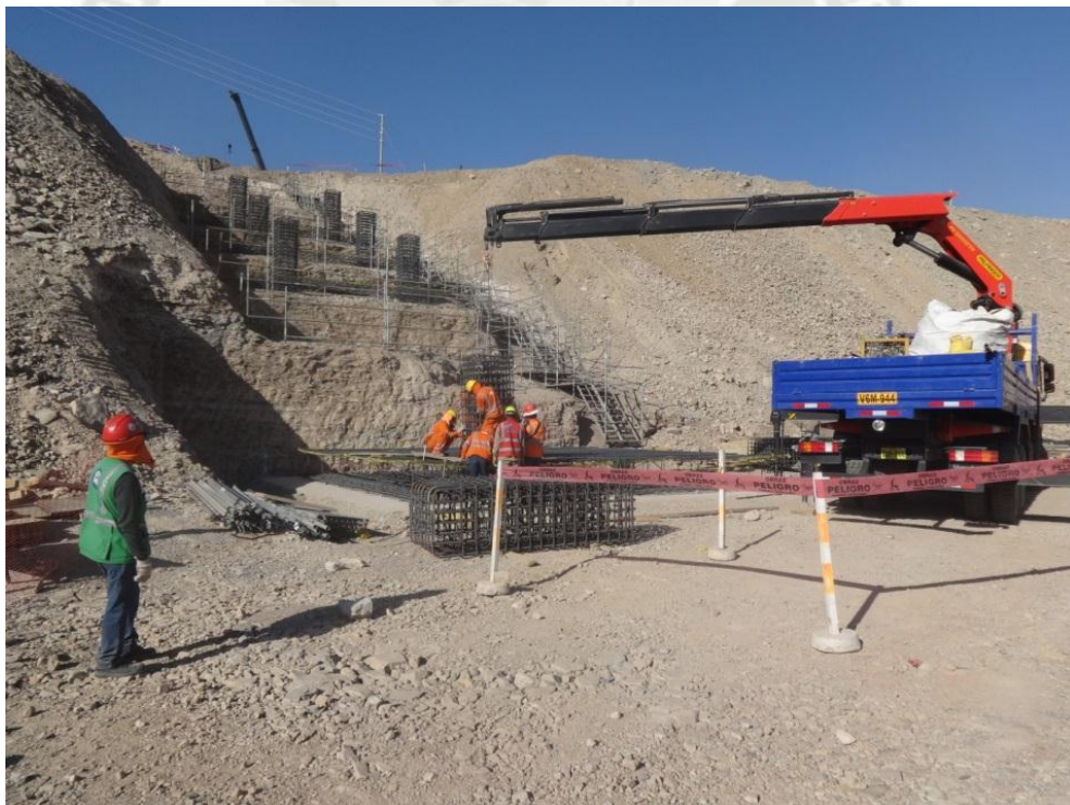
Foto 66 Izaje de estructuras pre-armadas en acero de refuerzo.
