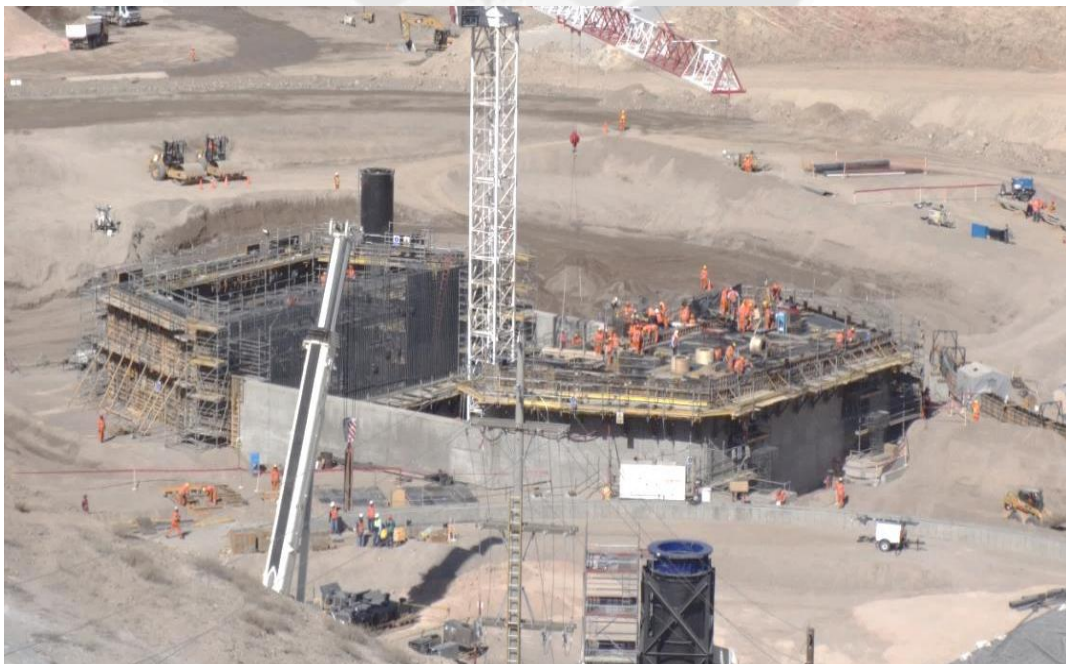
Foto 4 Cámara de reciclaje de agua en construcción para el proyecto en estudio.
