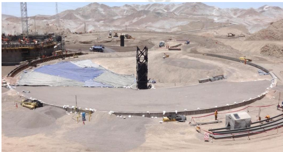
Foto 2 Construcción del tanque de espesado TK-12. Octubre 2014
