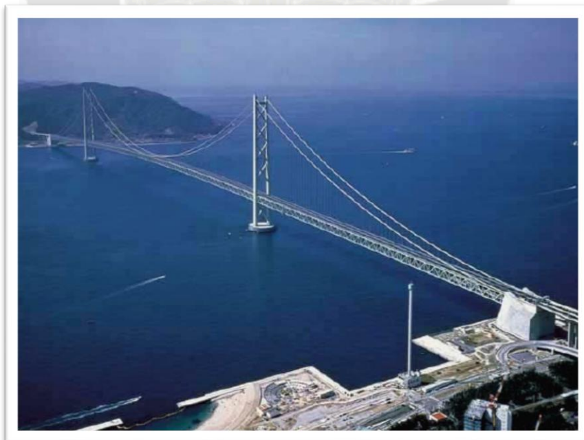
Figura 2.2. Vista aérea del puente colgante Akashi-Kaikyo en Kobe, Japón. (Ouchi, 2003).
