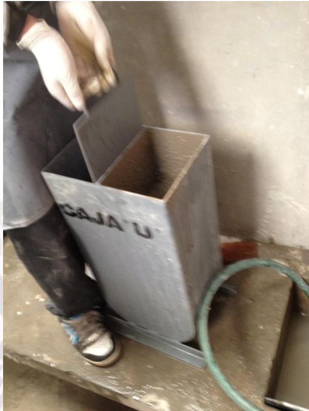
Figura Anexo 09: Abriendo la compuerta de la caja "U" para que el concreto pase las rejillas de acero en la parte inferior para el segundo compartimiento por peso propio.
