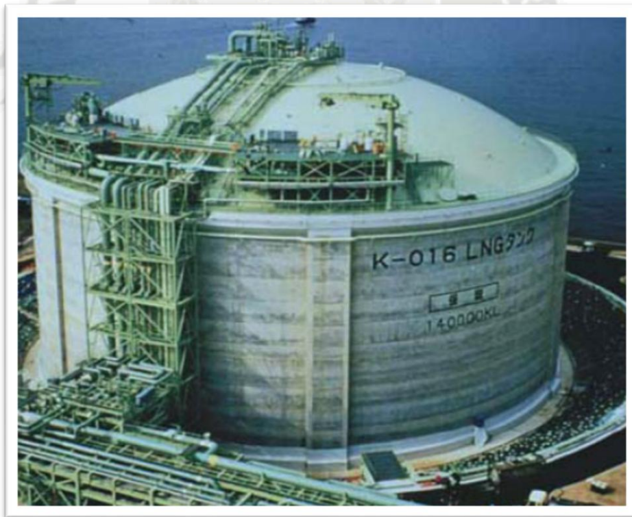
Figura 2.4. Tanque de gas licuado de la Compañía de Gas Osaka (Japón) construido con concreto autocompactante.
