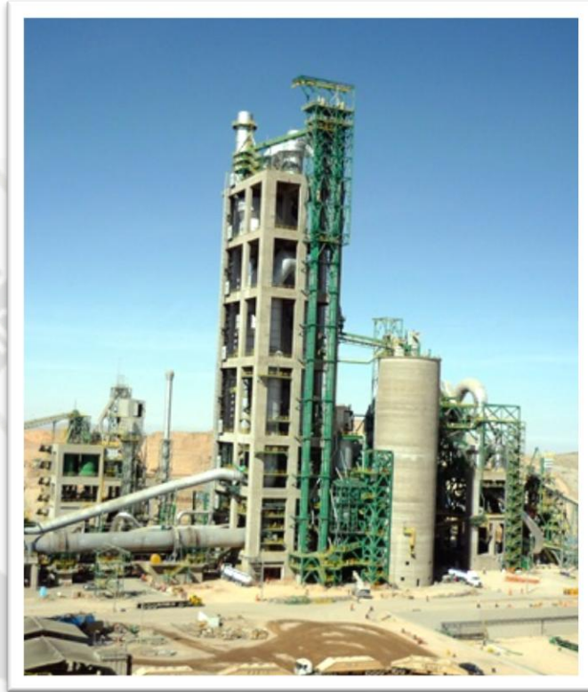
Figura 2.7. Vista del Edificio Industrial más alto del Perú, planta de cementos Yura – Arequipa.
