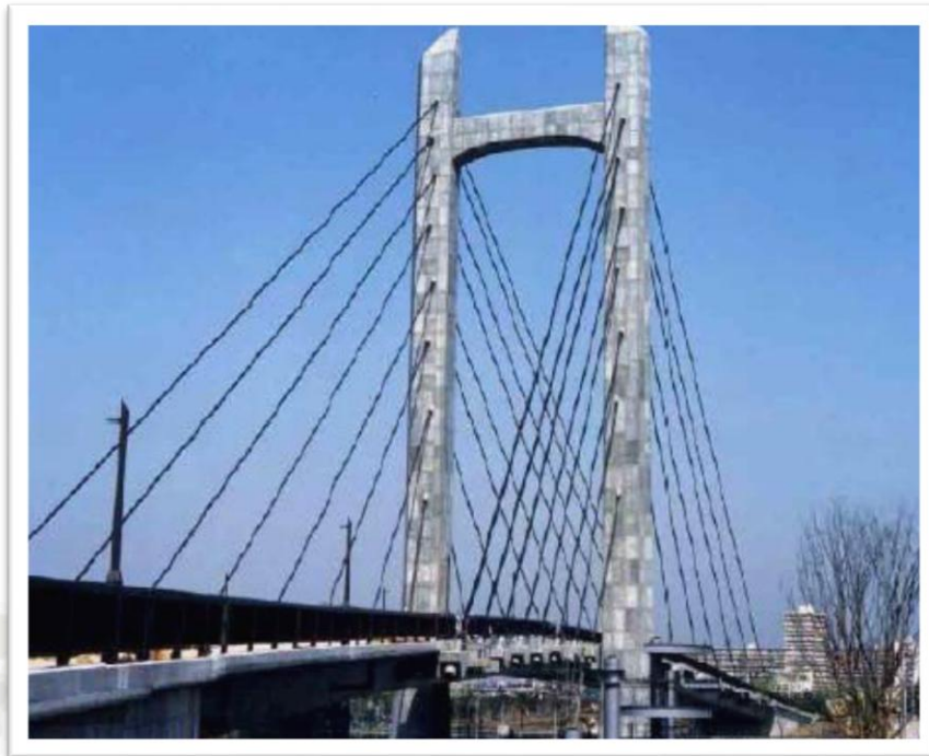
Figura 2.1. Torre del puente colgante Shin-Kiba Ohashi (Japón) de concreto autocompactante pretensado. (Okamura y Ouchi, 1998).
