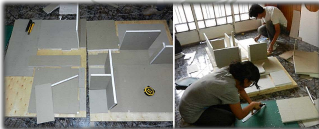
Figura 47. Armando bases de pisos y muros.
