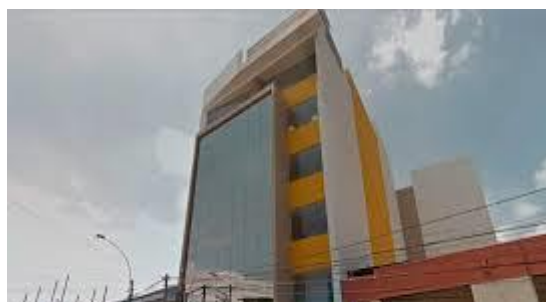
Figura 3: Fachada Policlínico Espíritu Santo Fuente: Google Imágenes
