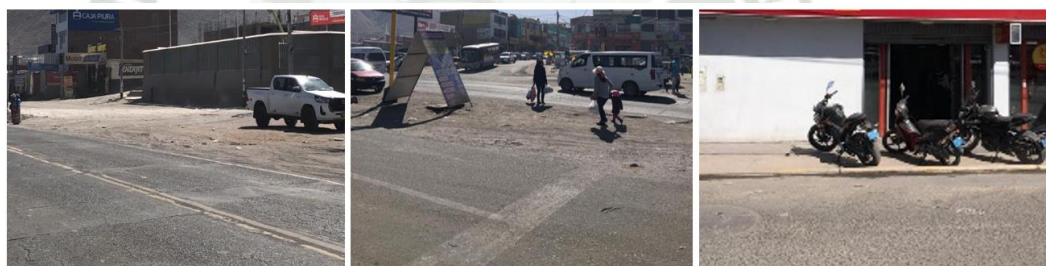
Figura 26 Señalización horizontal en la zona de estudio
