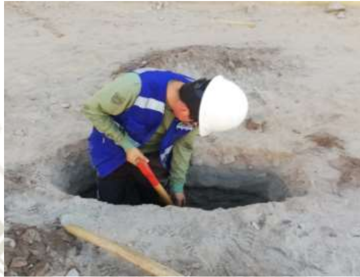
Fotografía 7: Calicata N°2 ubicada en el km 22+030
