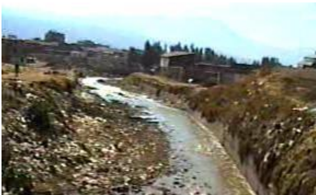
Anexo 1. Encauzamiento antes del PROGAISH
