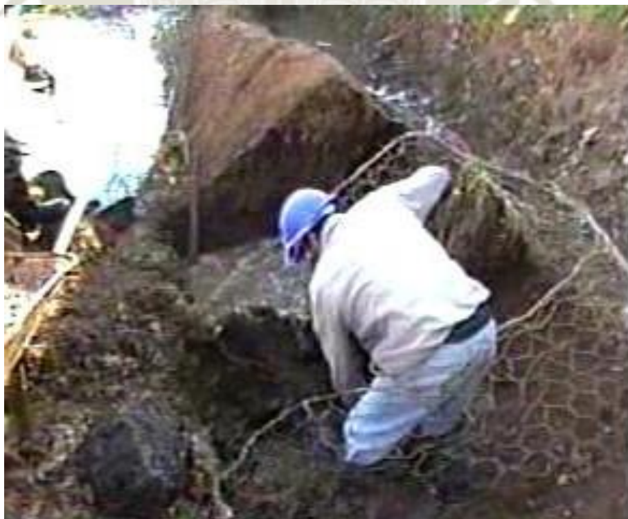
Anexo 2. Trabajos para la construcción de gaviones
