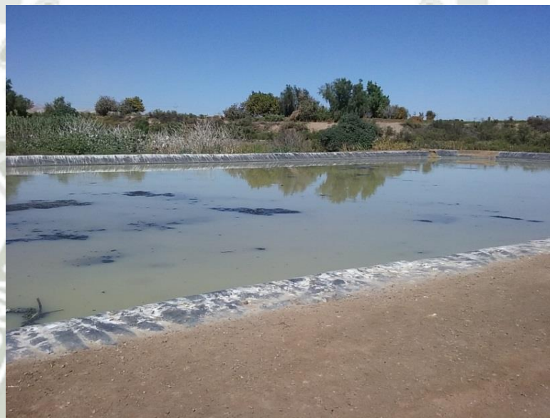
Figura 7 Laguna de oxidación de La Joya – Sector Río Seco
