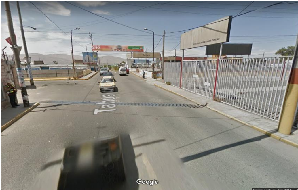
FOTOGRAFÍA N°1: VISTA DESDE EL CRUCE DE LA AV. FERNANDINI CON TAHUAYCANI, aquí iniciaría el puente de 20 metros que cruzaría la VARIANTE.
