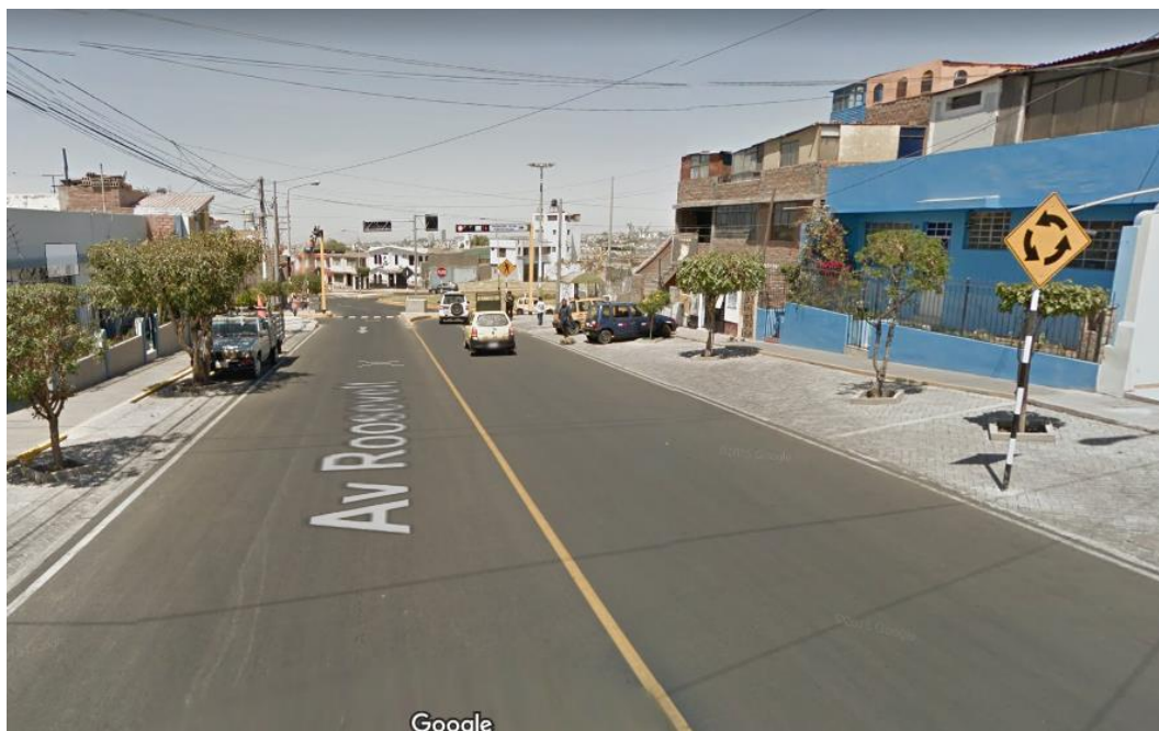
FOTOGRAFÍA N°4: Ingreso al Puente por el distrito de Alto Selva Alegre desde la parte Norte
