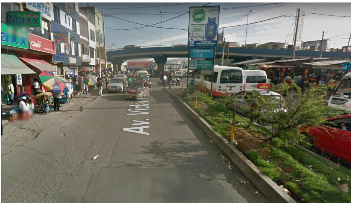
FOTOGRAFÍA N°4: VISTA DESDE LA AV. VIDAURRAZAGA zona sur, la cual está deteriorada y es también utilizada por los comerciantes como plataforma comercial libre, las zonas de parqueo han sido también utilizadas por ellos.
