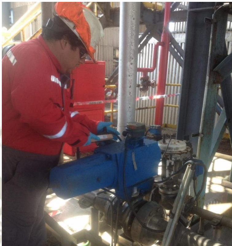
Figura 72. Mantenimiento Preventivo a Válvula neumática de bola (Planta Prillex 2018)
