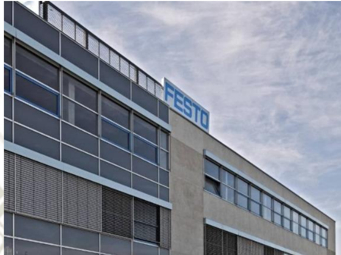
Figura 77. Instalaciones FESTO donde se realizó capacitación de control neumático (Chile, 2016)
