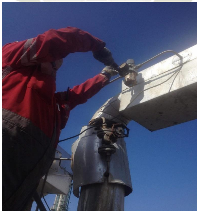
Figura 62. Cambio de Regulador de aire a válvula de neumática (Plante Prillex 2017)
