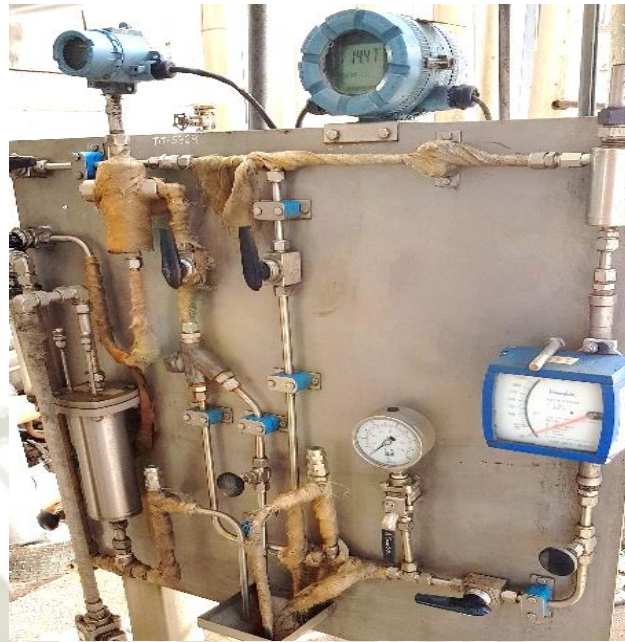
Figura 67. Panel de toma muestra y medición para sensores de PH (Planta Prillex, 2017)
