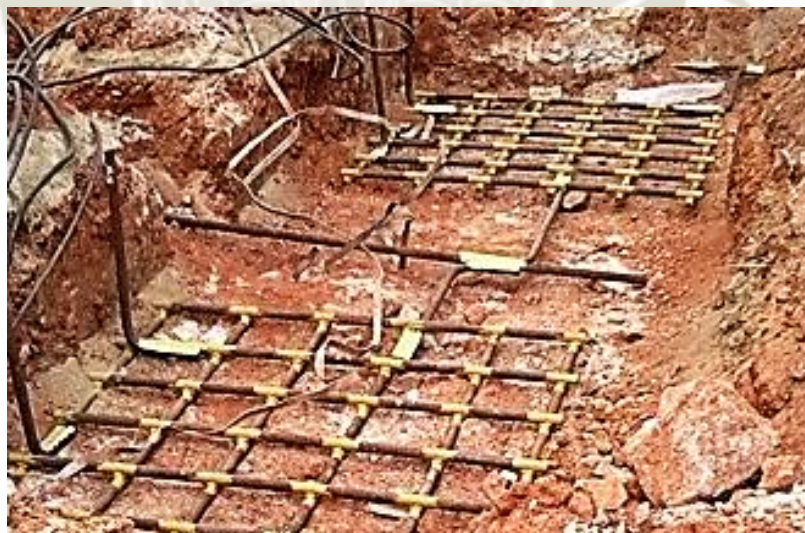
Figura 75. Malla de tierra en proceso de construcción (Chile. 2019)
