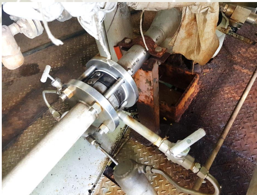
Figura 70. Toma de proceso de un sensor de Flujo de tipo placa orificio (Planta Prillex, 2018)
