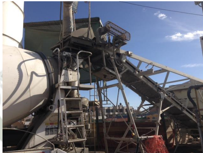
Fig. 2.12 Descarga en el alimentador de camión mixer.
