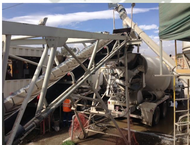
Fig. 2.9 Agregados transportados al camión mezclador de concreto a través de faja.
