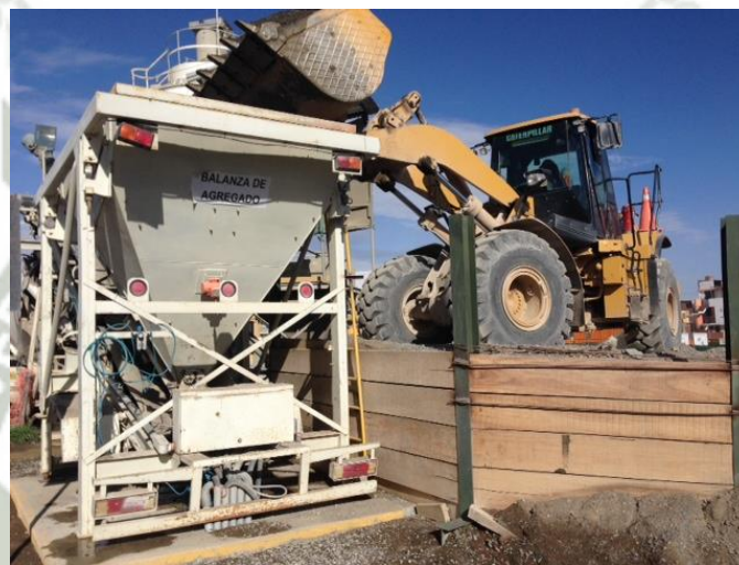
Fig. 2.6 Alimentación de agregados con cargador frontal.
