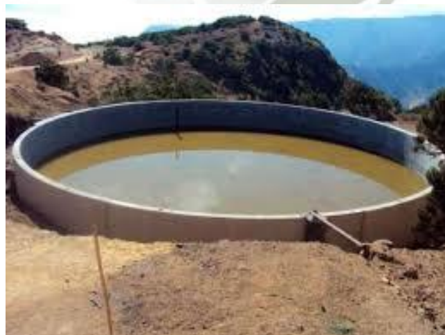
Fig. 2.18 Reservorio de concreto para el almacenaje de agua.
