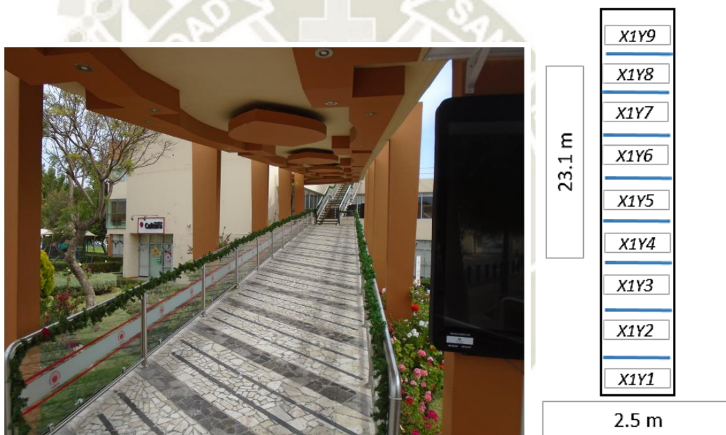
Foto 25: Rampa Acceso Segundo Piso
