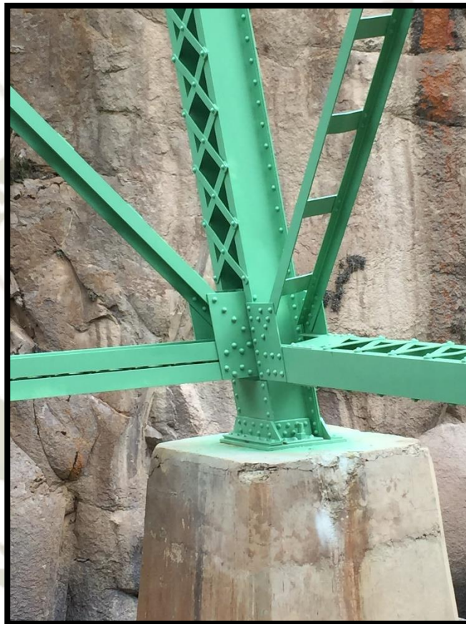
Fotografía 18: Conexión remachada
