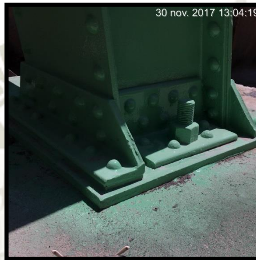
Fotografía 16: Placa de conexión pilar – cimentación de concreto
