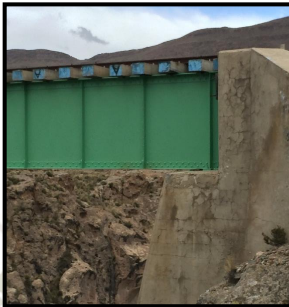
Fotografía 20: Estribo sur del Puente Sumbay
