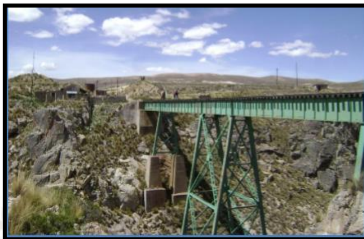
Fotografía 6: Fotografía del Puente Sumbay del año 2014
