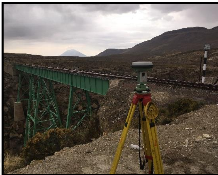
Fotografía 3: Obtención de coordenadas mediante el uso de GPS Diferencial (Modo Post-proceso) de la Estación SUMB-01
