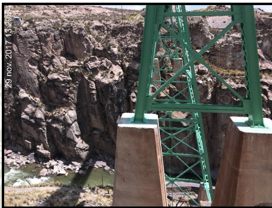
Fotografía 9: Cimentación de los pilares del Puente Sumbay
