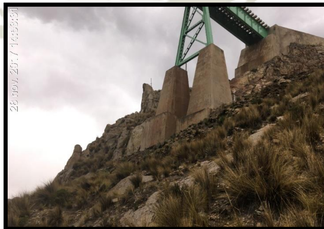
Fotografía 17: Pilar 3 cimentado sobre roca
