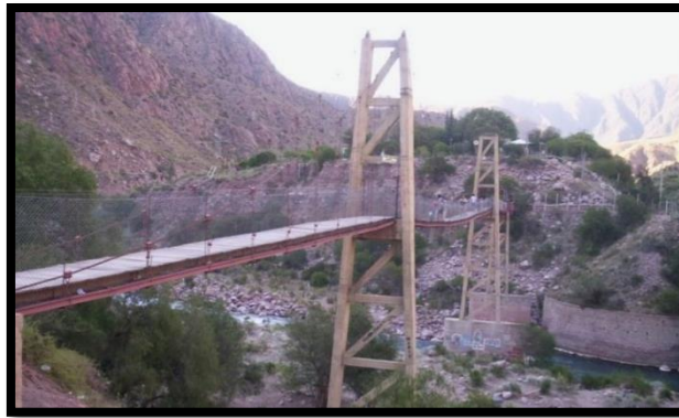
Fotografía 2: Puente ferroviario de la antigua traza del Trasandino en Cacheuta - Mendoza, Argentina
