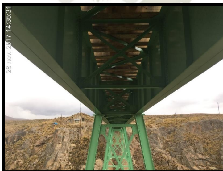
Fotografía 5: Tablero del Puente Sumbay
