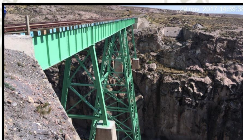
Fotografía 7: Fotografía del Puente Sumbay del año 2017, después del mantenimiento realizado
