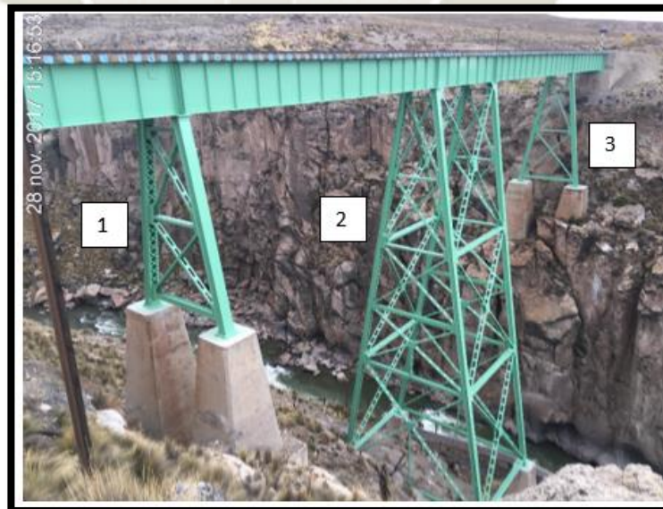
Fotografía 15: Pilares del Puente Sumbay
