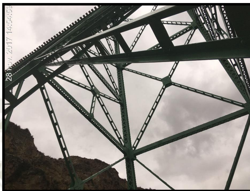
Fotografía 10: Pilar Central del Puente Sumbay
