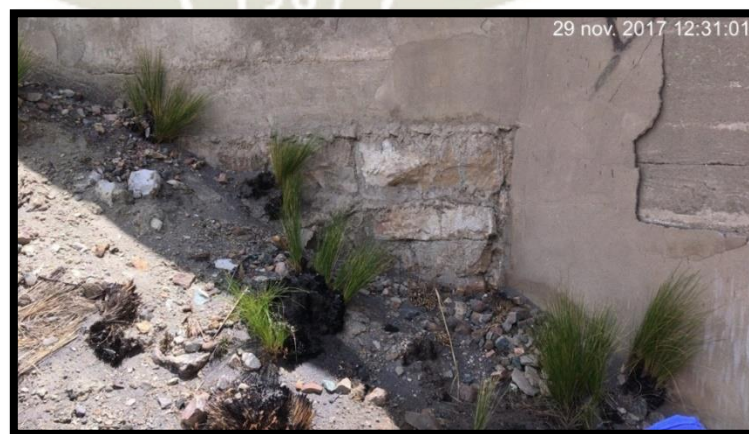
Fotografía 19: Estribo norte del Puente Sumbay
