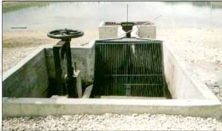
Ilustración 17 Cámara de rejas
