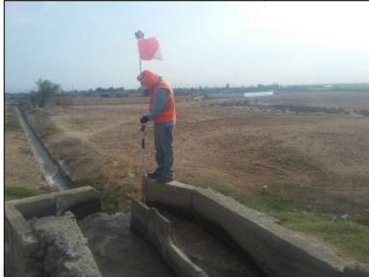
Ilustración 3 Canal existente sin cámara de captación
