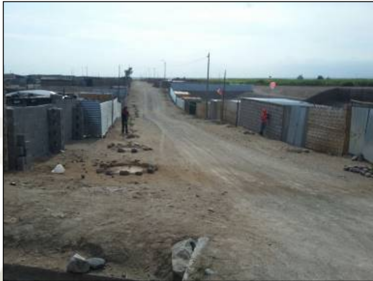
Ilustración 5 Calle principal C.P. Señor de los Milagros sin alcantarillado sanitario
