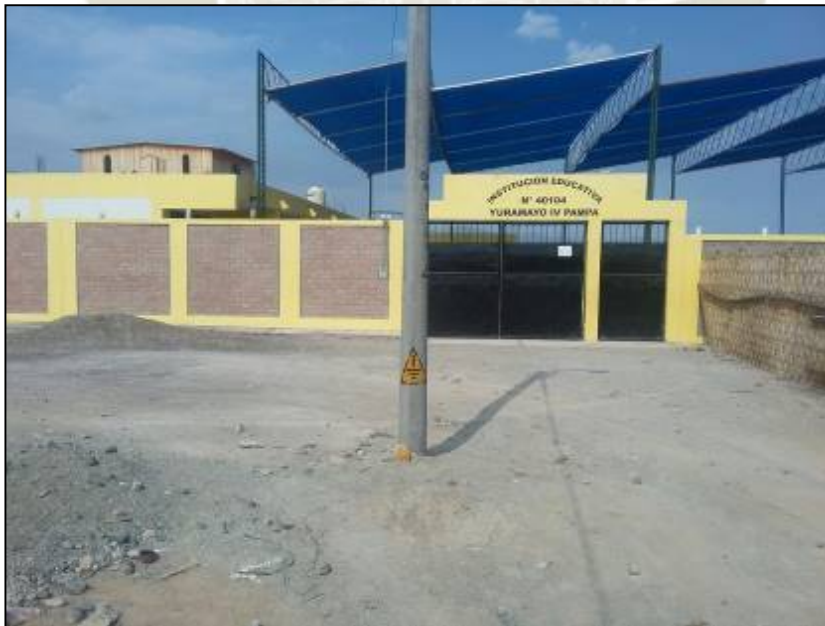
Ilustración 6 Calle secundaria C.P. Villa Hermosa sin alcantarillado sanitario
