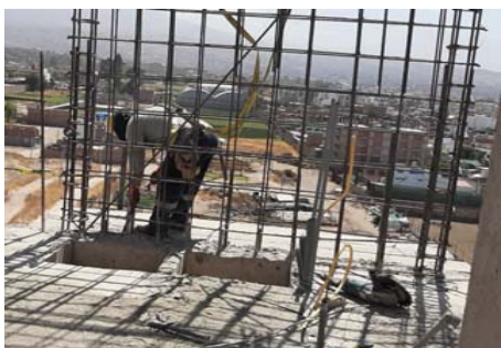
FIG 5: Obrero perteneciente al personal en estudio quitando considerable cantidad de restos de concreto en base de placa de borde que impiden poder colocar las planchas correctamente.
