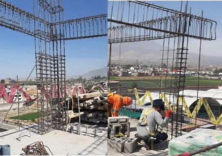
FIG 1: A la izquierda la columna C-2 antes de ser encofrada y a la derecha la columna C-3 empezando a ser encofrada. Ambas en forma de "L".
