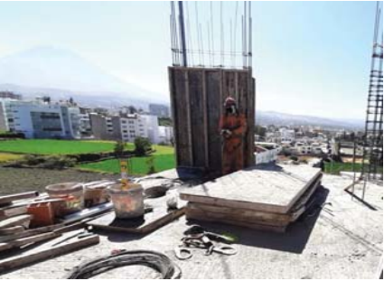
FIG 3: Obrero perteneciente al personal en estudio perforando un panel con un perforador manual en lugar de uno eléctrico, por lo que esta actividad demoró más.
