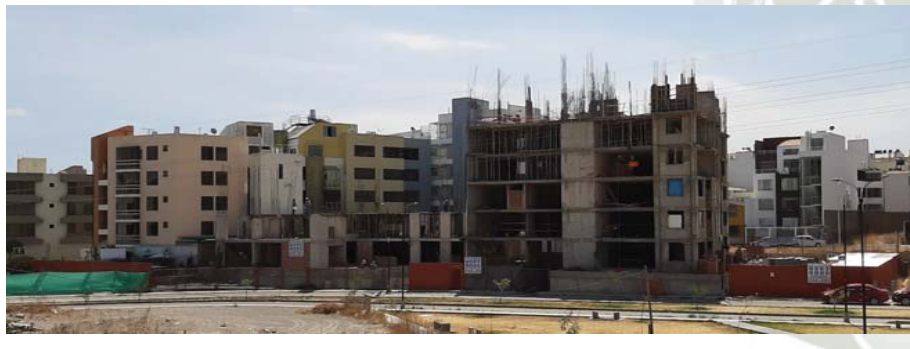
FIG 5: Obra en la que se tomaron los datos.
