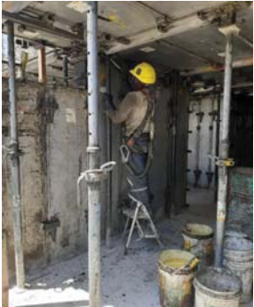
FIG 1: Contramuro ubicado en la sección "E" del sector de trabajo 4, único en ser apuntalado debido a ser un CONTRAMURO.
