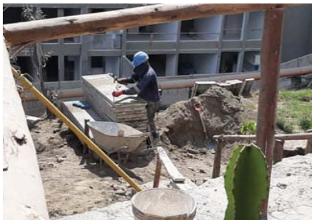
FIG 5: Obrero perteneciente al personal en estudio realizando la limpieza de las planchas metálicas.
