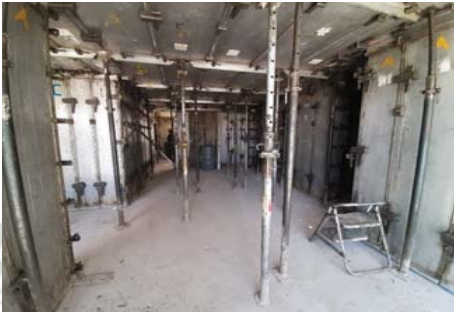
FIG 5: Parte del Sector de Trabajo, en el que se tomaron los datos, terminado de ser encofrado.
