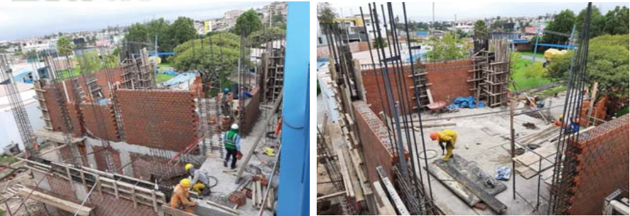
FIG 1: Sector de trabajo en el que se tomaron los datos antes de realizarse el trabajo de encofrado de columnas.
