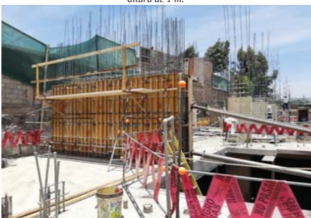
FIG 6: Placa con el encofrado terminado.
