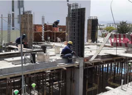
FIG 2: Obrero perteneciente al personal en estudio, identificado con una cinta de color negra en el casco, realizando el encofrado de una columna de borde
