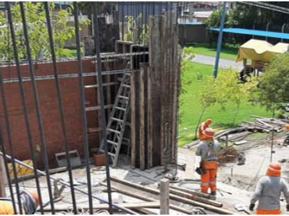
FIG 2: Obrero perteneciente al personal en estudio, identificado con una cinta de color azul en el casco, cortando alambre (Habilitación de alambre) a la derecha de la placa P-1.
