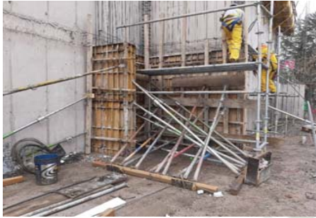
FIG 4: Muro de ductilidad limitada MDL 1 con el encofrado terminado y con un apuntalado especial debido a estar a contramuro.
