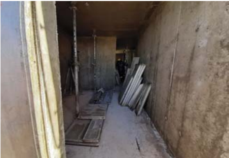
FIG 6: Paño de Sector de Trabajo realizado el día anterior, desencofrado.
