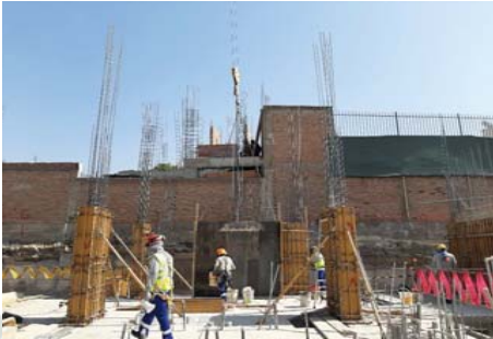
FIG 3: Obrero perteneciente al personal en estudio colocando desmoldante a una formaleta metálica armada que está siendo sujeta por la GRÚA TORRE
