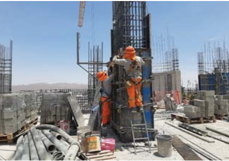
FIG 2: Obreros pertenecientes al personal en estudio colocando las pasarelas en la columna para armar una plataforma y poder encofrar la parte de arriba de la columna en "L" de 3m.
