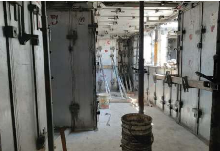
FIG 2: Parte del sector de trabajo en el que se ubica un antepecho por lo que se colocó un separador entre este y la losa
