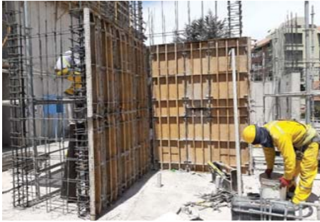
FIG 3: Encofrado en proceso de MDL 2.
