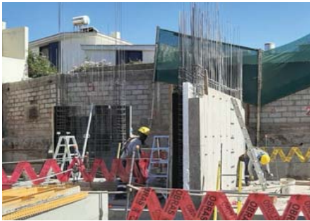
FIG 2: Obrero perteneciente al personal en estudio (Derecha) colocando distanciadores en una placa que se encuentra separada de otra ya vacada mediante una gruesa plancha de tecnopor.
