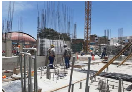
FIG 4: Obrero recibiendo instrucciones del capataz acerca de la placa que se encuentra separada de otra ya vaceada mediante una gruesa plancha de tecnopor, y cuya parte inferior ya está vaceada hasta una altura de 1 m.
