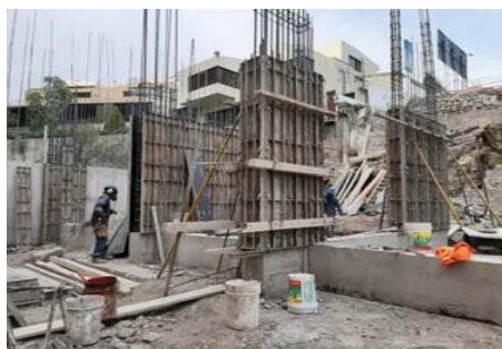
FIG 7: Dos placas de la derecha terminadas de encofrar mientras que la de la izquierda está muy avanzada.
