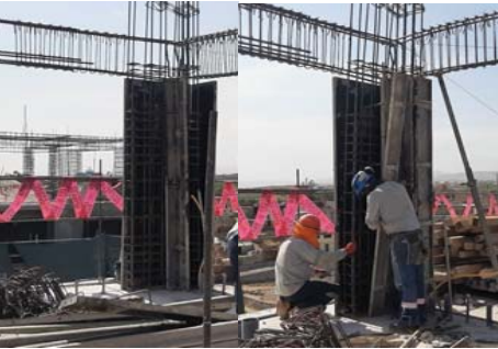
FIG 2: Columna C-2 en proceso de encofrado, donde se puede apreciar la cara interna más pequeña que tenía una dimensión atípica, que se cubrió, por una parte, con una tabla de madera.
