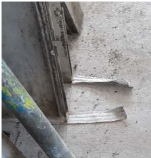
FIG 4: Base de plancha colocada debajo de la misma.
