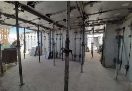
FIG 9: Sector de trabajo, en el que se tomaron los datos, con el encofrado avanzado.
