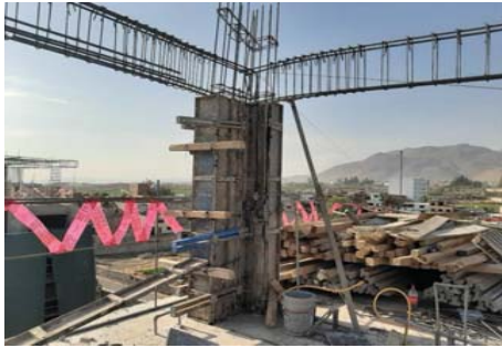
FIG 3: Encofrado terminado de la columna C-2, donde también se puede ver a la derecha la presencia de un puntal apuntalando el acero de viga para que pueda entrar la plancha.
