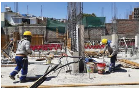
FIG 7: Obrero de la derecha colocando desmoldante a distanciadores, mientras que su compañero (izquierda) está transportando consigo accesorios.
