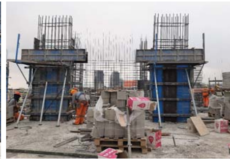
FIG 6: Columna de la derecha terminada de ser encofrada mientras que la columna de la izquierda se encuentra con el encofrado muy avanzado.
