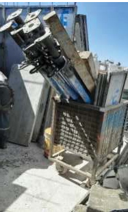
FIG 10: Carro de accesorios cargado de planchas y puntales
