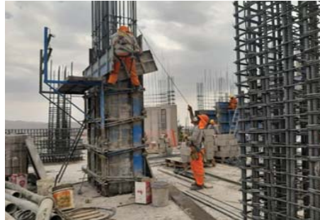
FIG 4: Obreros utilizando una soga como polea para subir y colocar una plancha en la parte superior de la columna de 3m.
