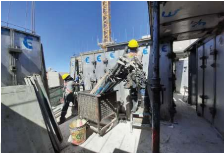
FIG 6: Pareja de encofradores realizando el encofrado de MDL.
