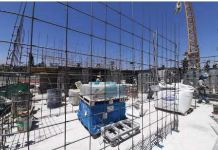
FIG 1: Sector de trabajo en el que se tomaron los datos antes de ser encofrado.
