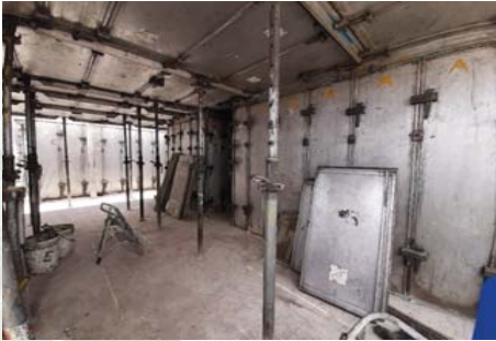
FIG 5: Parte del Sector de Trabajo, en el que se tomaron los datos, casi terminado de ser encofrado.
