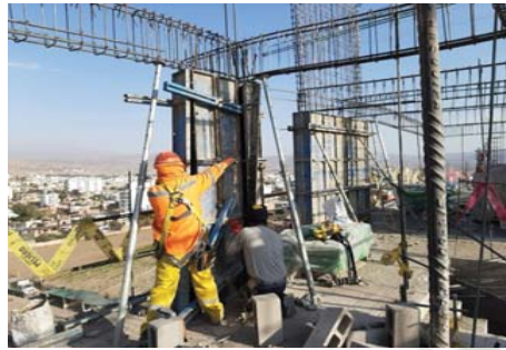
FIG 4: Obreros pertenecientes al personal en estudio colocando una tabla de madera en la cara interna más pequeña de la columna C-3, que tiene una dimensión complicada debido a su reducido tamaño
