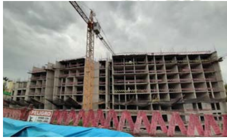
FIG 6: Bloque "A" de la Obra en la que se tomaron los datos.
