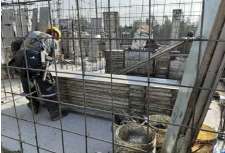
FIG 6: Obrero limpiando pila de planchas.
