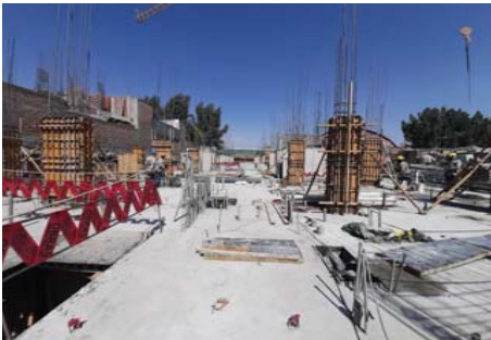
FIG 8: Parte del sector de trabajo, en el que se tomaron los datos, con el encofrado muy avanzado.
