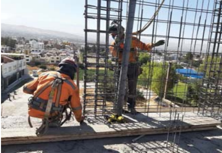
FIG 2: Obrero perteneciente al personal ubicado a la izquierda e identificado con una cinta de color azul en su casco, midiendo la horizontalidad del suelo mientras que su compañero se encuentra en la plataforma de borde.
