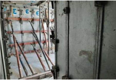
FIG 1: Contramuro ubicado en la sección "E" del sector de trabajo 4, único en ser apuntalado debido a ser un CONTRAMURO.
