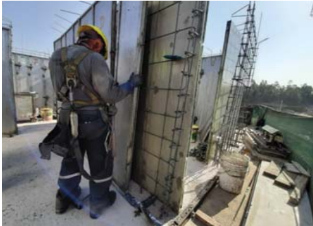
FIG 4: Obrero levantando plancha sobre la cinta que se usa como base.
