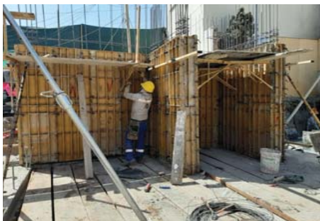
FIG 7: Obrero perteneciente al personal en estudio armando una plataforma colocada en el muro M-58, el cual ya se encuentra con el encofrado muy avanzado.
