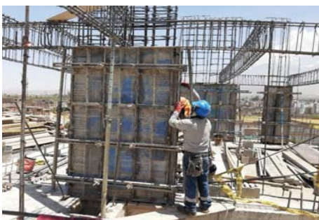
FIG 6: Obrero perteneciente en estudio midiendo con plomada la verticalidad de la placa.
