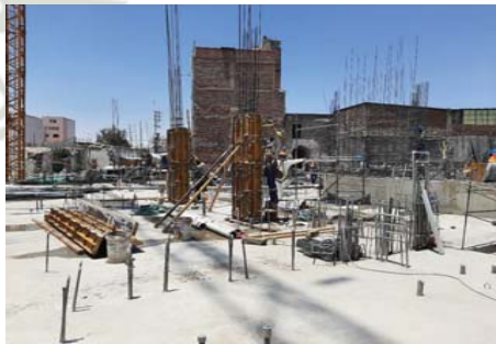
FIG 7: Obreros pertenecientes al personal en estudio colocando alineadores en cada respectiva columna.
