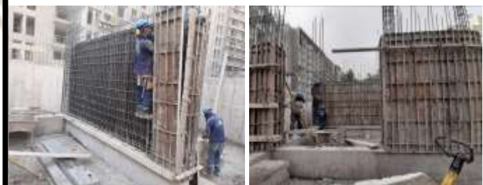
FIG 3: Obrero perteneciente al personal en estudio colocando una plancha en una placa donde se puede ver con claridad la base de encofrado colocada por tratarse de un muro de sótano.
