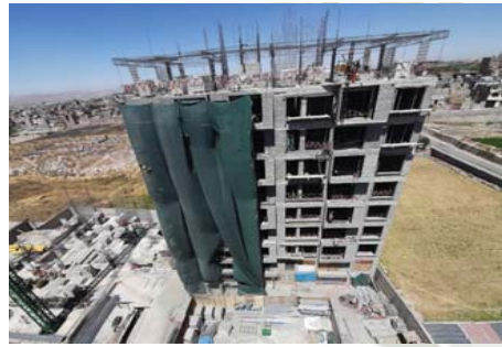
FIG 6: Fachada de la Torre 1 donde se tomaron los datos correspondientes.
