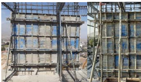
FIG 7: Algunas de la placas terminadas de encofrar.
