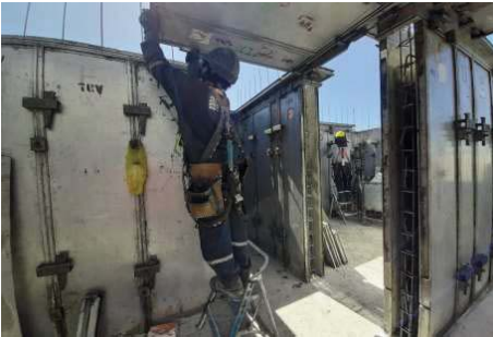
FIG 7: Obrero colocando plancha en losa, con ayuda de su escalera personal.
