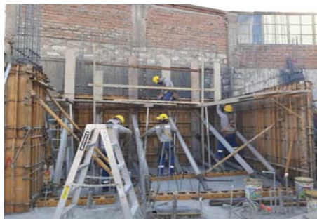
FIG 8: Obreros pertenecientes al personal en estudio terminando de apuntalar el muro a una cara mientras que el obrero de arriba termina de armar la plataforma.
