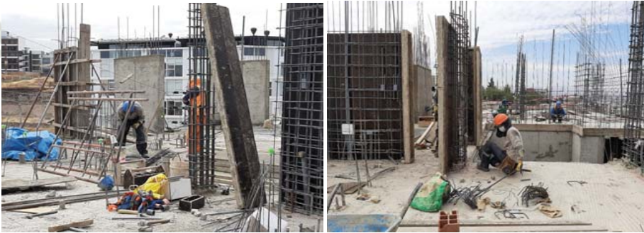
FIG 3: Obreros pertenecientes al personal en estudio habilitando
