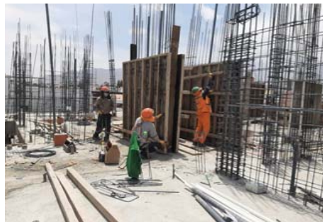
FIG 4: Encofrado de madera de placas en proceso.
