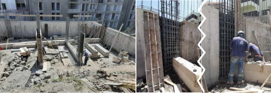
FIG 1: Sector de trabajo en el que se tomaron los datos. FIG 2: Placa central de un muro de sótano de borde ya vacado y de diferente espesor, conectada con una viga de cimentación ya vacada; razones por lo que su encofrado demoró más de lo habitual.
