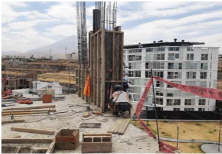
FIG 3: Pareja de encofradores pertenecientes al personal en estudio colocando barrotes.
