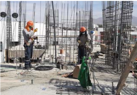
FIG 2: Pareja de encofradores perteneciente al personal en estudio habilitando material, específicamente alambre.
