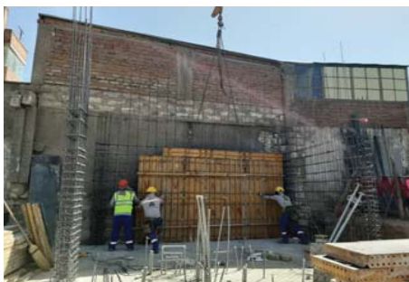
FIG 3: Dos obreros pertenecientes al personal en estudio, junto con el rigger, instalando una formaleta metálica (ya armada) con la GRÚA TORRE en una cara del muro M-62.
