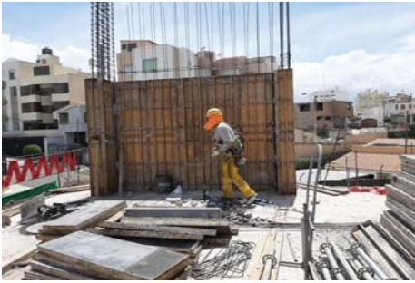
FIG 2: Obrero perteneciente al personal en estudio, identificado con una cinta de color azul en el casco, realizando el encofrado del MDL 3.
