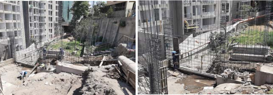
FIG 1: Muro de borde escalonado y de nivel de sótano, que tiene como colindante el jardín de una casa, antes de ser encofrado
