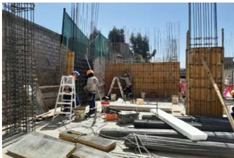
FIG 3: Obrero de casco azul trasladando escalera mientras que su compañero coloca distanciadores y el obrero de atrás se dispone a movilizarse por escalera.
