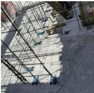
FIG 5: Distanciadores de planchas colocados en piso antes de iniciar la tarea de encofrado.
