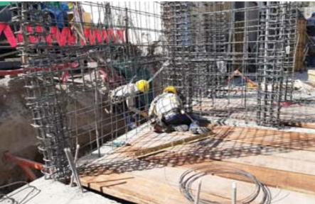
FIG 2: Pareja de obreros pertenecientes al personal en estudio colocando una plataforma para el encofrado en borde del muro M-58 (muro en forma de "F").
