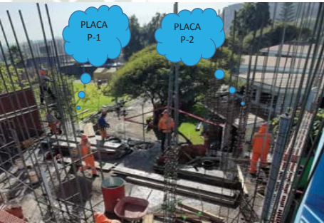
FIG 1: Sector de trabajo en el que se tomaron los datos donde se puede apreciar las placas antes de ser encofradas.
