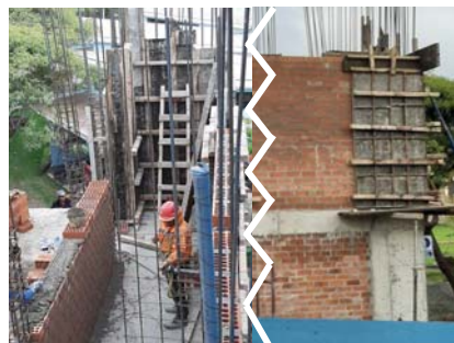
FIG 4: A la izquierda se observa a un obrero perteneciente a la muestra habilitando material (alambre) y a su detrás se ve la placa P-2 con el encofrado avanzado. A la derecha se observa una de las caras en borde de la placa P-2 con el encofrado terminado.
