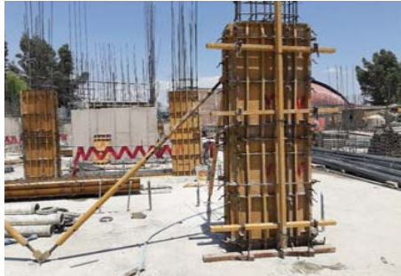
FIG 6: Columna terminada de ser encofrada donde se puede apreciar el detalle del barrote pegado a la base del elemento siendo ajustado por la presencia de 2 cuñas y las estacas colocadas, asegurando así la base del encofrado.
