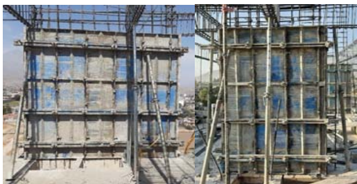
FIG 7: Algunas de la placas terminadas de encofrar.
