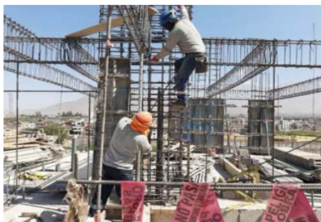
FIG 4: Obrero de casco rojo apuntalando acero de viga para así poder elevarlo y permitir que plancha pueda entrar para colocarla correctamente.
