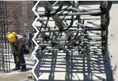
FIG 2: A la izquierda, un obrero perforando el suelo haciendo agujeros que bordean el elemento a encofrar, a fin de colocar estacas usadas para mantener el recubrimiento entre el acero y el encofrado ó para asegurar la base del encofrado ajustando un barrote pegado a ella. A la derecha, los agujeros realizados en el borde de una columna.
