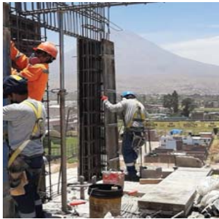
FIG 5: Obrero perteneciente al personal en estudio levantando plancha en la columna de borde C-1.
