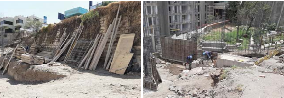
FIG 3: Material apilado a un costado del sector de trabajo.
