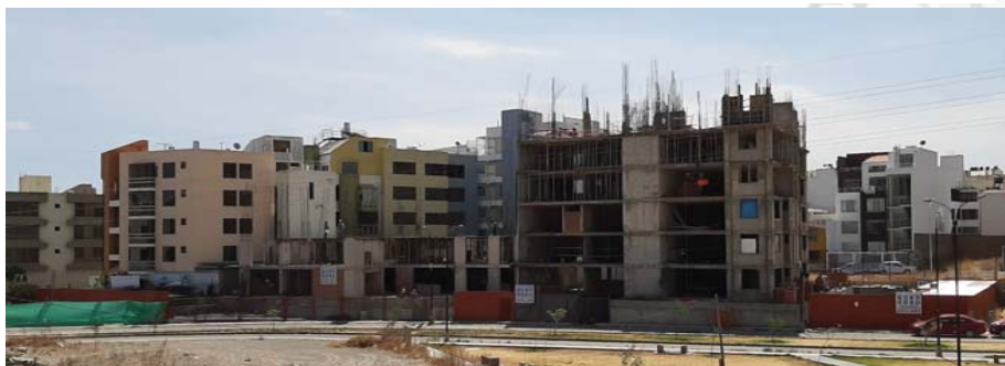
FIG 5: Obra en la que se tomaron los datos.
