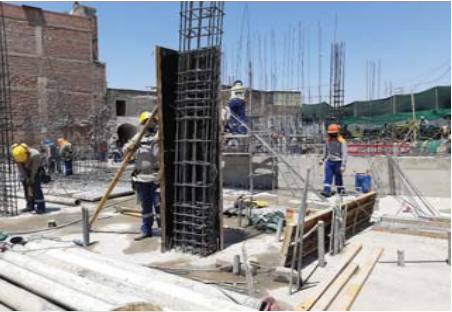
FIG 5: Obrero perteneciente al personal en estudio encofrando columna central. En la base del encofrado se pueden apreciar las estacas colocadas para mantener el recubrimiento entre el acero y el encofrado.
