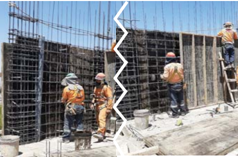
FIG 4: A la izquierda, un obrero identificado con cinta negra colocando tubos (cantillones) en placa mientras que su compañero con cinta azul se dispone a movilizarse para traer material. A la derecha un obrero con cinta roja acomodando alambre y su compañero asegura el panel.
