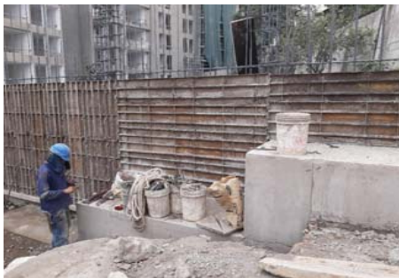
FIG 7: Obrero perteneciente al personal en estudio colocando desmoldante sobre distanciadores utilizando su dedo.
