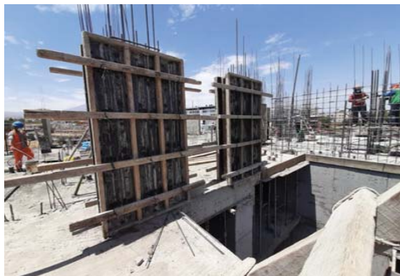
FIG 3: Encofrado de columnas completamente terminado.
