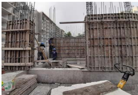
FIG 6: Obrero perteneciente al personal en estudio apuntalando una placa de mayor espesor, mientras que dos obreros ubicados detrás levantan una plancha de otra placa de mayor longitud.
