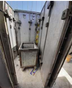
FIG 3: Paño, considerablemente pequeño, en proceso de encofrado teniendo en su interior a un carro de accesorios.
