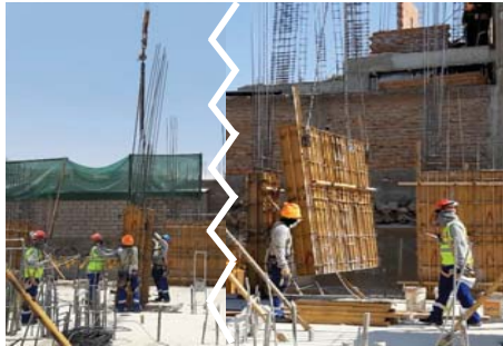
FIG 4: Dos obreros pertenecientes al personal en estudio junto con el rigger transportando/instalando una formaleta metálica ya armada por la GRÚA TORRE.
