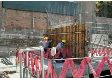
FIG 1: Obreros pertenecientes al personal en estudio realizando la extracción de distanciadores de una placa vaciada. Labor que provocaba tomar descansos recurrentemente debido al esfuerzo físico.
