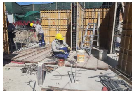
FIG 6: Obrero de la derecha colocando plástica a distanciadores, mientras que su compañero de la izquierda se encuentra apuntalando una parte del muro M-58.
