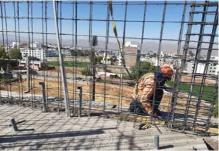
FIG 1: Obrero perteneciente al personal en estudio, identificado con una cinta de color rojo en su casco, revisando la horizontalidad con un nivel de mano
