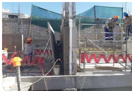
FIG 4: Obrero perteneciente al personal en estudio aplicando desmoldante sobre una formaleta metálica armada que hace unos instantes fue extraída del muro vaceado el día anterior.
