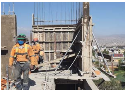
FIG 6: Placa de borde con el encofrado terminado y donde se puede apreciar el apuntalamiento en borde.
