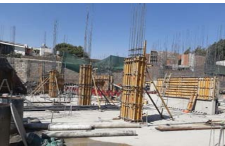
FIG 8: Parte del sector de trabajo, donde se tomaron los datos, con el encofrado terminado.
