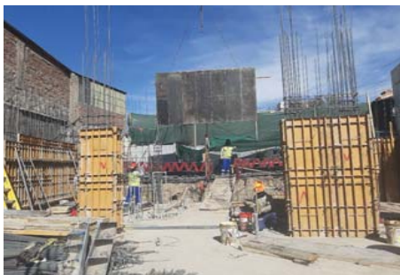
FIG 5: Rigger dirigiendo el transporte de una formaleta metálica (ya armada) con la GRÚA TORRE en otra cara del muro M-62.
