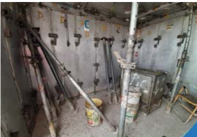
FIG 6: Paño con el encofrado avanzado.
