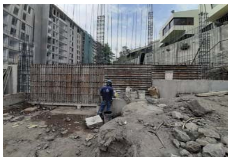
FIG 8: Muro de borde escalonado y de nivel de sótano, que tiene como colindante el jardín de una casa, con el encofrado avanzado.
