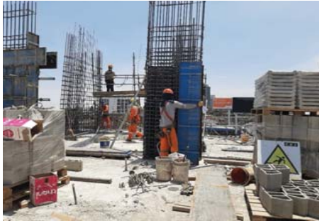
FIG 3: Obrero perteneciente al personal en estudio levantando plancha en una columna.
