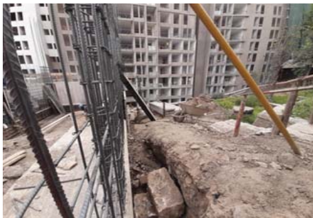
FIG 6: Cara del muro que tiene como colindante el jardín de un casa por lo que para poder encofrar se tuvo que rellenar parte de la franja excavada anteriormente.
