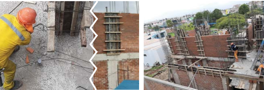
FIG 4: A la izquierda se puede observar a un obrero perteneciente al personal en estudio ajustando con alambre dos barrotes, y a la derecha el encofrado de una columna de borde.
