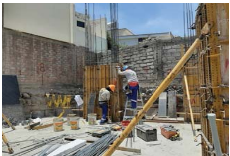
FIG 5: Obrero pertenecientes al personal en estudio encofrando una placa en "L"
