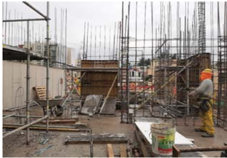
FIG 5: Obrero perteneciente al personal en estudio, identificado con una cinta de color azul en el casco, iniciando con el encofrado de otro MDL.
