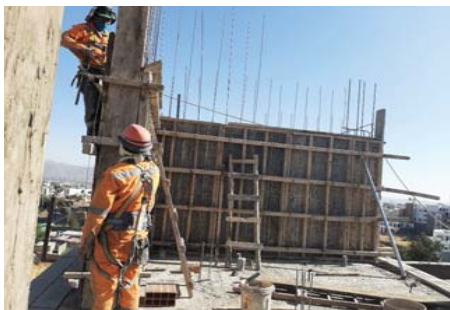
FIG 5: Placa de borde con el encofrado avanzado
