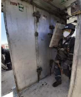
FIG 8: Obrero transportando plancha de aluminio, portando su mascarilla según protocolo.
