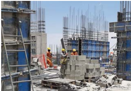
FIG 5: Obreros pertenecientes al personal en estudio trayendo material que previamente desencofraron del nivel inferior al no contar con material disponible en el sector de trabajo.
