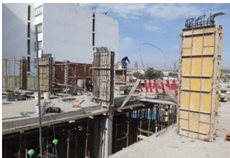
FIG 4: Columnas con el encofrado terminado.
