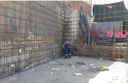
FIG 1: Obrero perteneciente al personal en estudio clavando estacas alrededor del muro M-62 (muro en forma de "L"), usadas para mantener el recubrimiento entre el acero y el encofrado.
