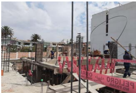
FIG 3: Parte del sector de trabajo donde se puede apreciar la escalera de madera por donde se sube al 3er nivel. Debido a que esta es estrecha el traslado de materiales era lento.
