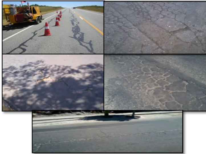
Imagen 2.3.11.1.8.1 Tratamiento de fisuras necesarias en las zonas en evaluación (EP)
