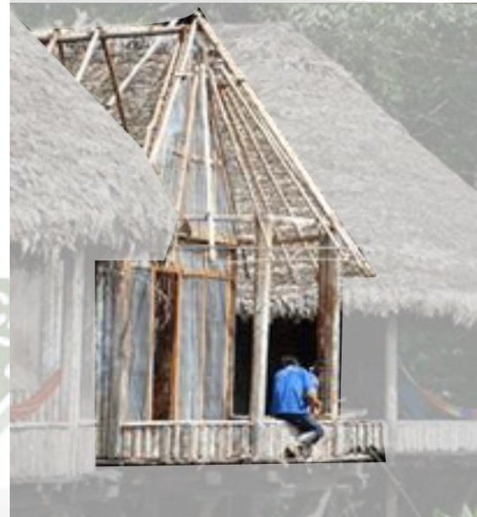
IMAGEN N°9 PROCEDIMIENTO PREVIO A LA COBERTURA CON HOJAS DE PALMA
