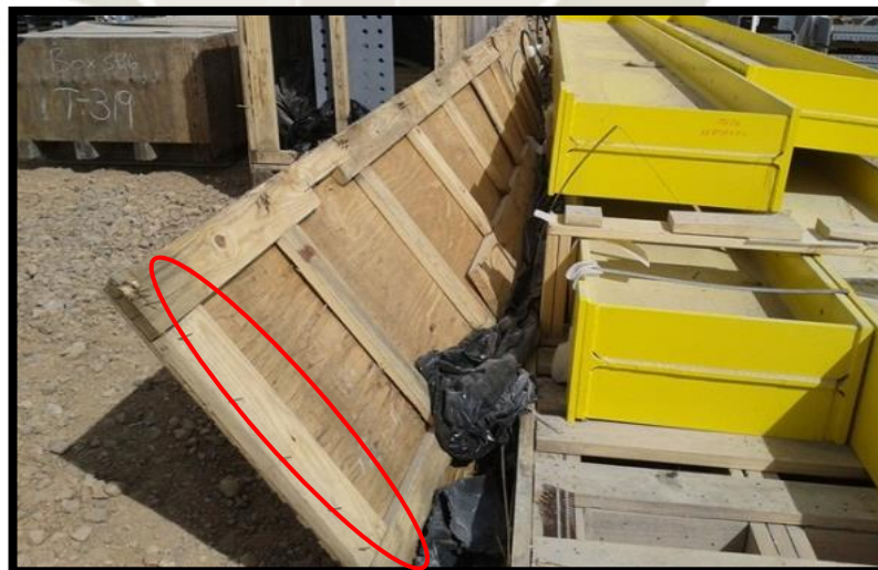
Figura 49: Cajas abiertas con los clavos expuestos.
