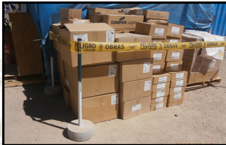
Figura 36: Cajas de lámparas y fusibles almacenados en contacto directo con el suelo y en el exterior.
