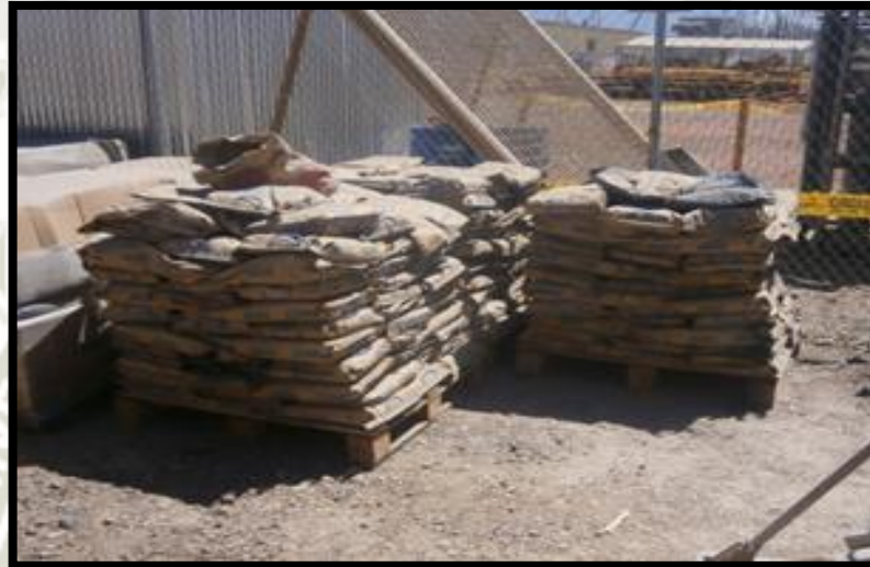
Figura 24: GEM almacenado sin protección contra la lluvia.
