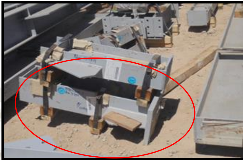
Figura 17: Viga almacenada inclinada hacia un lado.
