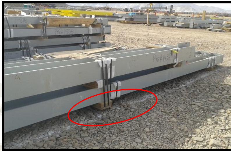
Figura 16: Columna con sus puntos de apoyo fijados incorrectamente.
