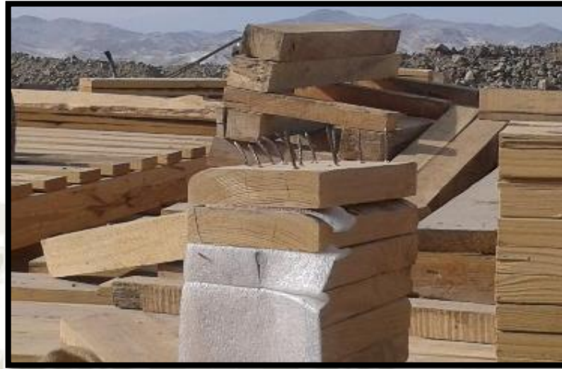
Figura 50: Clavos totalmente expuestos de un taco de madera.
