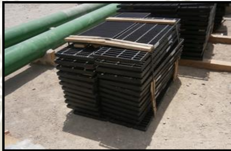
Figura 32: Grating almacenado sin usar los puntos de apoyo adecuadamente.
