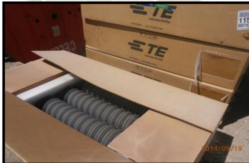
Figura 25: Aisladores almacenados sin protección contra la lluvia.
