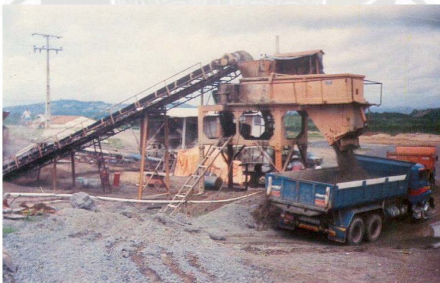
Fig. N°2.4: Colocación del concreto de la central en camión para su transporte
