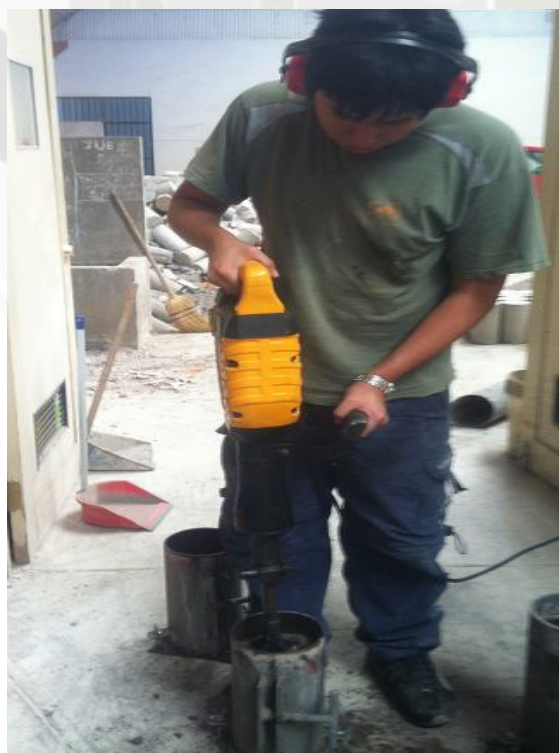
Fig. N°6.9: Vaciado de mezcla por capas y aplicación de martillo vibratorio
