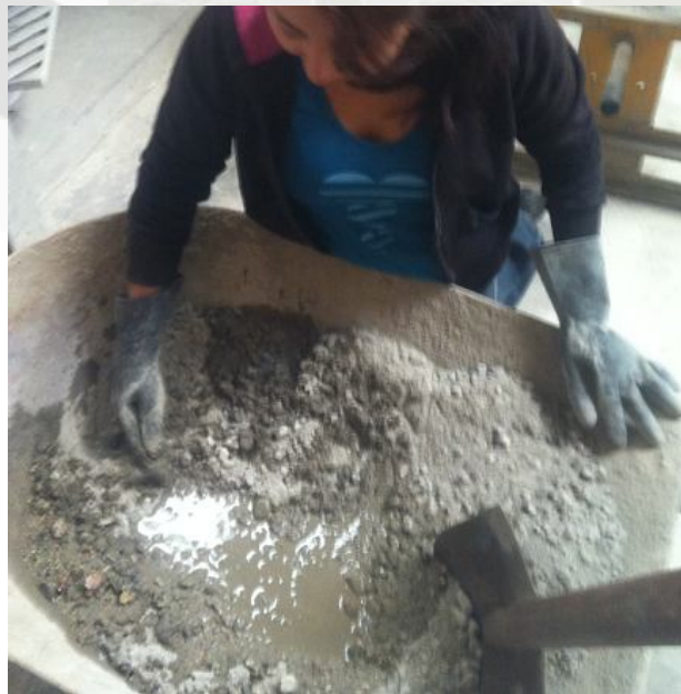
Fig. N°6.7: Mezclado manual de cemento, agregados y agua
