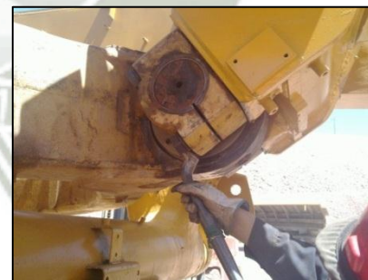
Desmontaje pernos anclaje Figura N° 81
