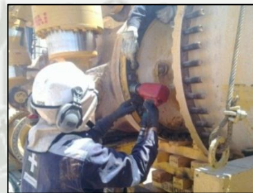
Torqueo pernos de anclaje
