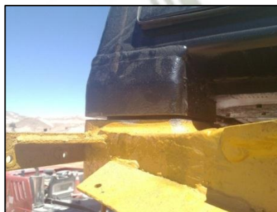
Instalación de Shines Figura N° 75
