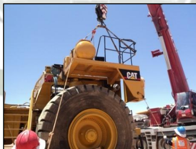
Izaje de plataforma RH Figura N° 80
