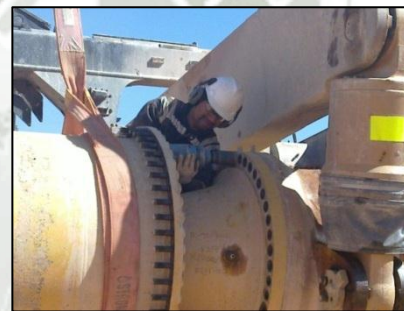
Desmontaje pernos anclaje MF Figura N° 66
