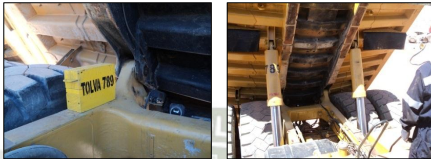
Instalación de tacos de seguridad para calibración de tolva Figura N° 117 y 118
