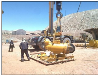
Izaje de Transmisión Figura N° 43
