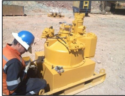
Izaje de Convertidor de torque Figura N° 60
