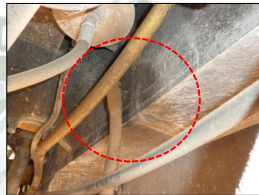
Fisura en larguero izquierdo Fig. N° 26
