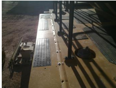
Instalación pernos de acople de mascara Figura N° 84
