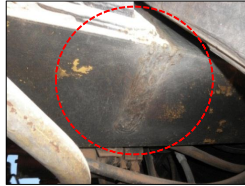
Fisura en larguero izquierdo Fig. N° 18
