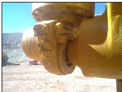
Instalación de Tapones Figura N° 51
