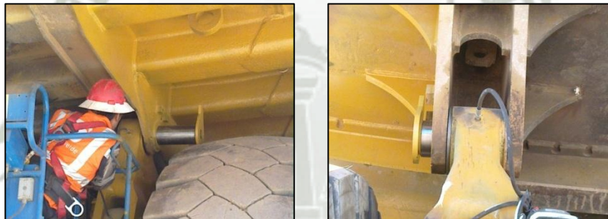
Instalación de Pines Pivots Figura N° 112 y 113.
