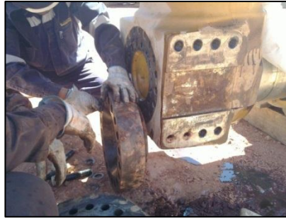
Instalación plato extractor Figura N° 72
