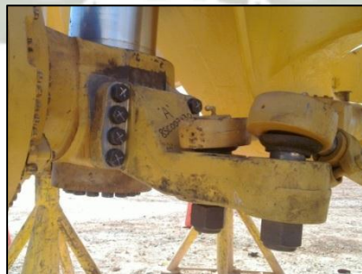
Instalación Barras de dirección Figura N° 34
