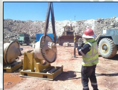
Instalación rueda en base Figura N° 74
