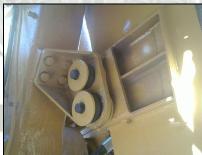
Desmontaje Soportes TK HYD Figura N° 50
