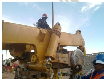
Instalación de Cilindros de izaje Figura N° 47
