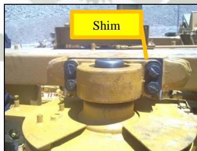
Instalación de chumacera
