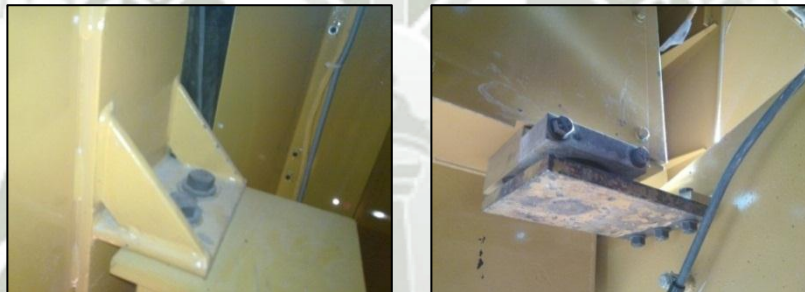
Instalación de pernos de anclaje Figura N° 68 y 69
