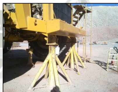
Instalación Soportes delanteros Figura N° 62
