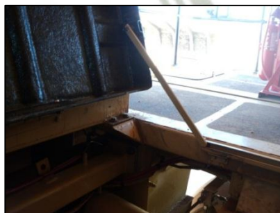
Instalación de tapa de motor Figura N° 86
