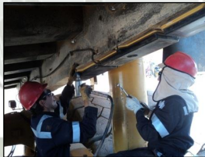
Instalación de Pad's de tolva
