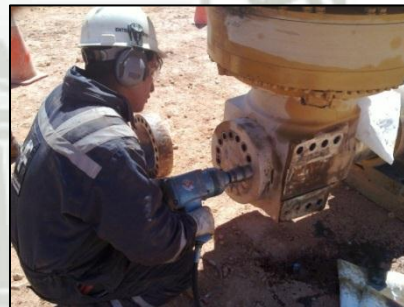
Desmontaje pernos anclaje Figura N° 71
