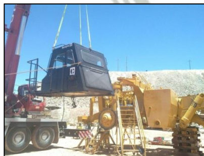
Desmontaje de Cabina Figura N° 61
