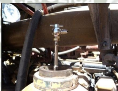
Instalación de Chuck para carga de Acumuladores Figura N° 95
