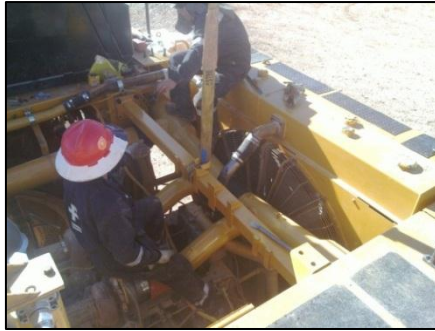
Desmontaje Puente Chasis Figura N° 37
