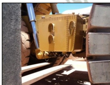
Izaje de Tanque Hidráulico Figura N° 48
