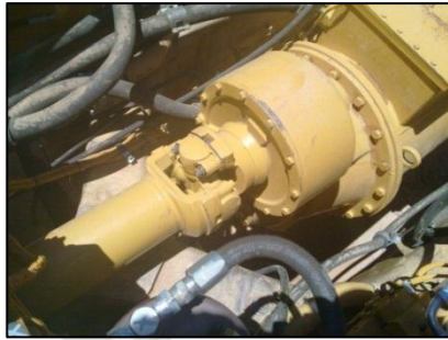
Desmontaje Cardan Potencia Figura N° 44
