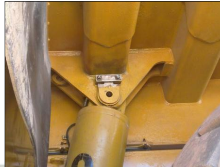
Desmontaje seguro Figura N° 2
