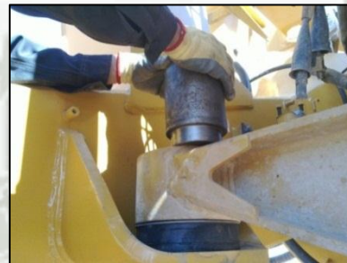
Instalación Sleeves de montaje Figura N° 65
