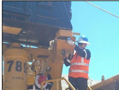
Instalación de pernos de anclaje Figura N° 76
