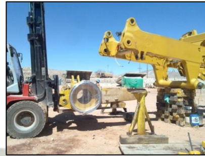
Desmontaje de A-Frame Figura N° 83
