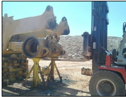
Izaje de A-Frame Figura N° 82
