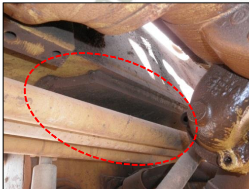
Larguero derecho reparado Fig. N° 11
