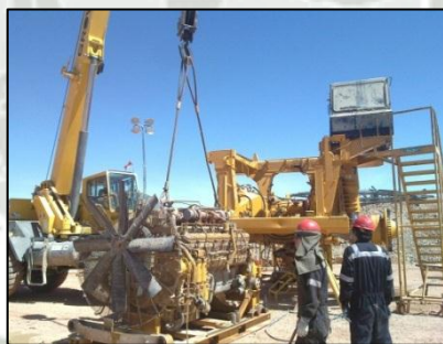
Izaje de Motor Figura N° 63
