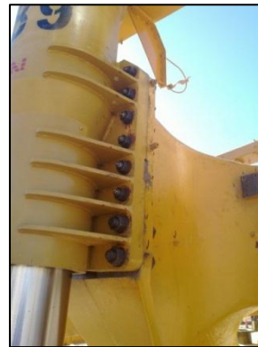
Instalación pernos anclaje
