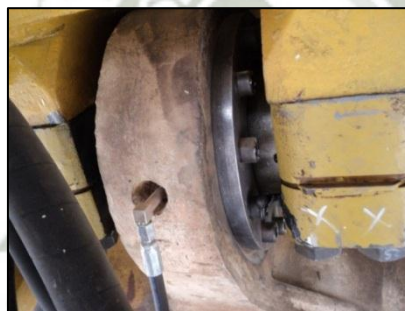
Instalación pernos anclaje Figuras N° 6
