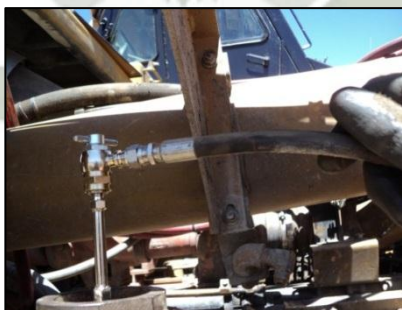
Instalación de mangueras de carga de acumuladores Figura N° 96
