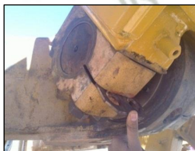
Instalación chavetas en chumaceras Figura N° 8
