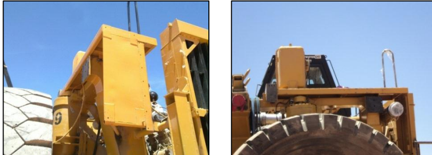
Izaje de plataforma RH Figura N° 78 y 79
