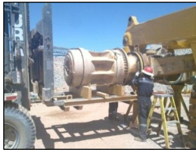
Instalación de pernos anclaje
