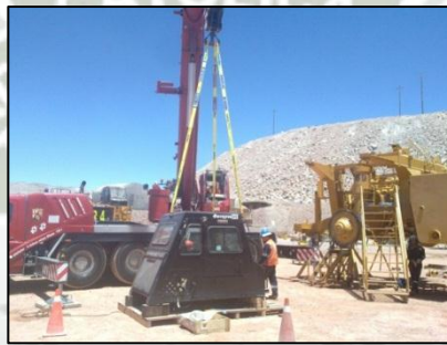
Izaje de cabina Figura N° 74
