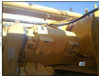
Bomba de Izaje Figura N° 53
