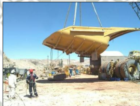
Izaje de tolva Figura N° 6
