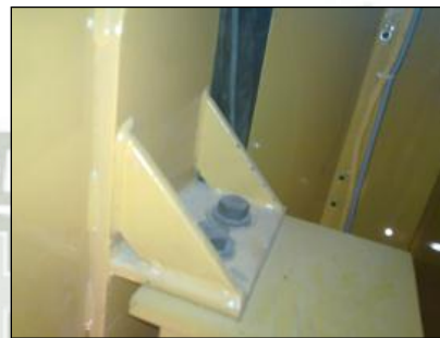
Retiramos Anclajes Laterales Figura N°36
