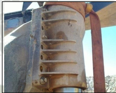
Desmontaje pernos anclaje Susp. Delantera Figura N° 68
