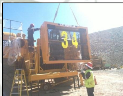
Izaje de Mascara Protectora Figura N° 33
