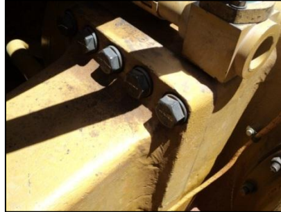
Instalación Pernos acople Funda Diff. Figura N° 2
