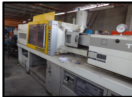
Foto N° 2. Inyectora mecánica 11INM02.
