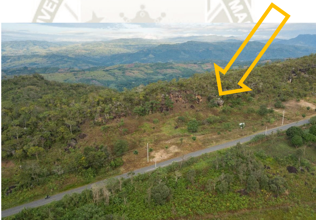
Imagen N° 34: Terreno 1; Fuente: Fotografías propias
