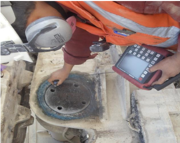
Fig. 6.16 Inspección 4 Fuente SPCC
