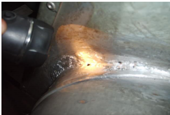
Fig. 4.3 Ensayo Inspección visual
