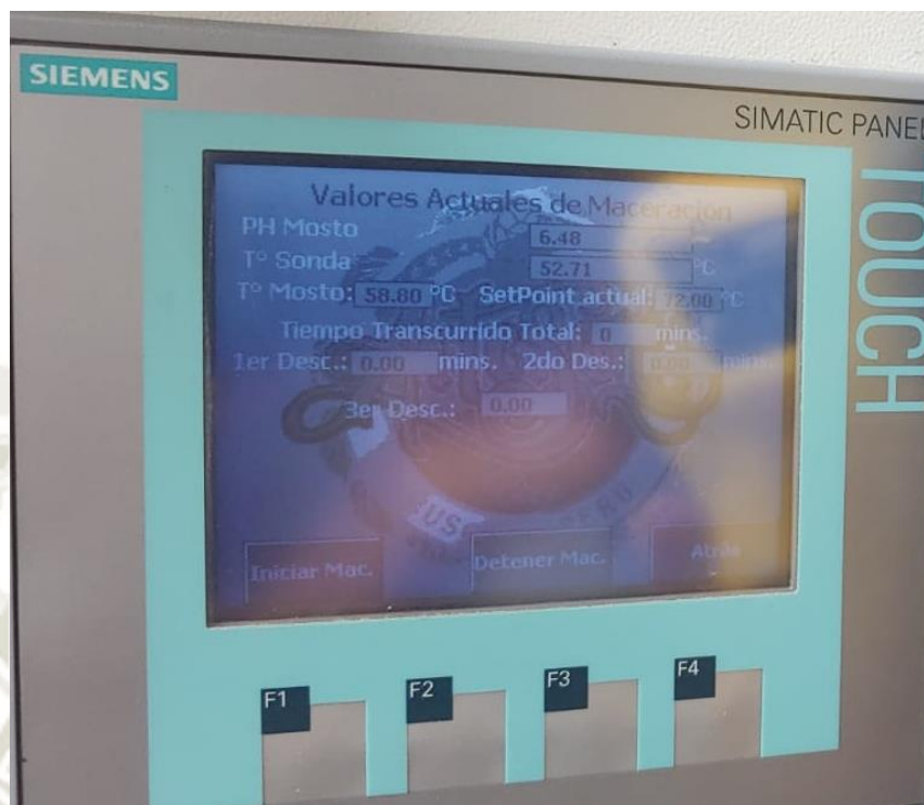
Fig. 89. Monitoreo de maceración en pantalla HMI
